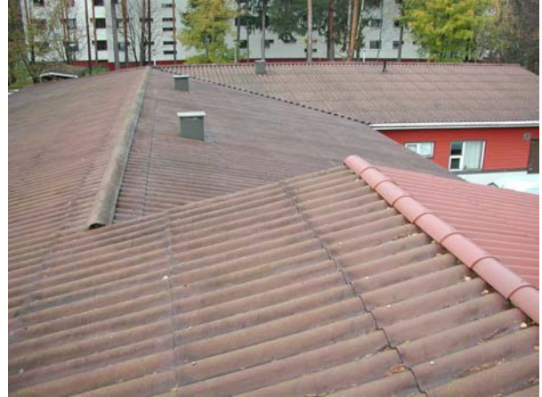
Kuva 8. Vesikatto on enintään tyydyttävä-kuntoinen. Se on monitoimihallin kohdalta uusittu vuonna 1999.
