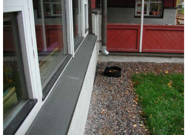
Kuva 4. Ikkunakarmit ja -puitteet ovat hyväkuntoiset. Kattojen sadevedet ohjataan sadevesikaivoihin ja seinänvierellä on sepeli.
