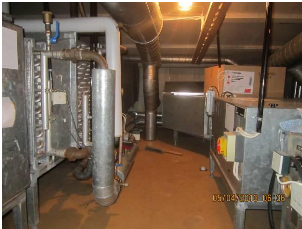
Kuva 17 Yleiskuva ullakon IV-konehuoneesta.
