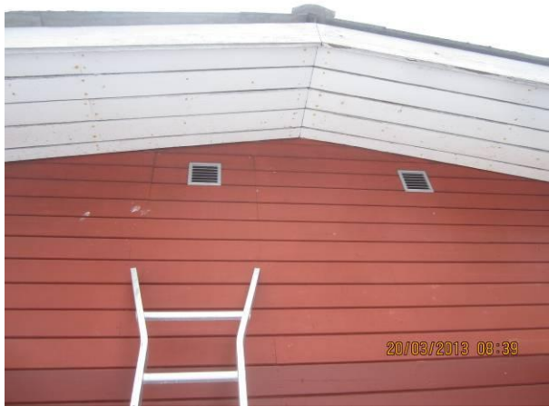
Kuva 5 Pääsy yläpohjaan pienistä luukuista.
