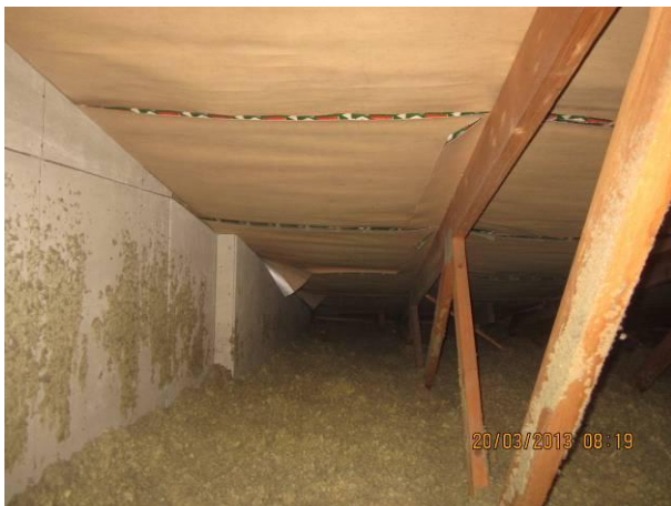
Kuva 13 Palokatkoiseinä on lujalevyä.
