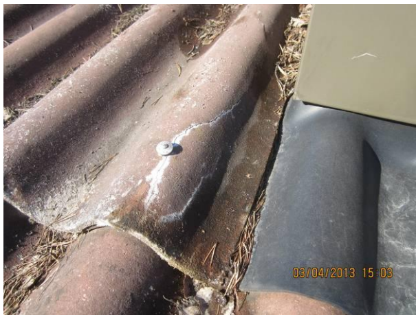
Kuva 3 Yksittäinen halkeama.
