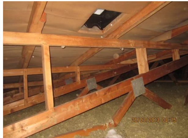
Kuva 8 Tuuletuspiipun alla hieman lunta.
