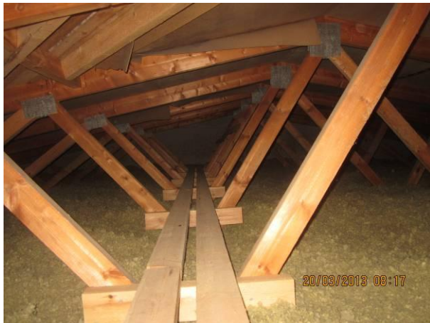
Kuva 7 Yläpohjan kulkusilta
