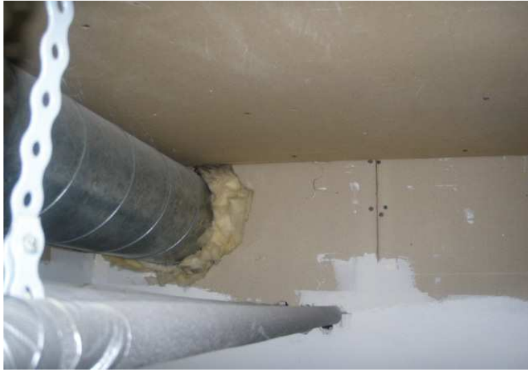
13. Näkymä alasasketun katon sisäpuolelta yläpohjaa vasten olevasta kipsilevystä ja väliseinän yläpäästä.
