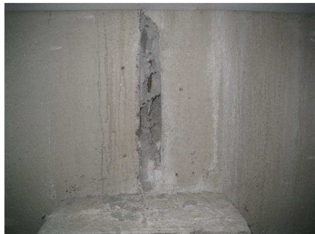
Kuva 22 Valamaton sokkelipalkkien liittymä tilan 119 alla.
