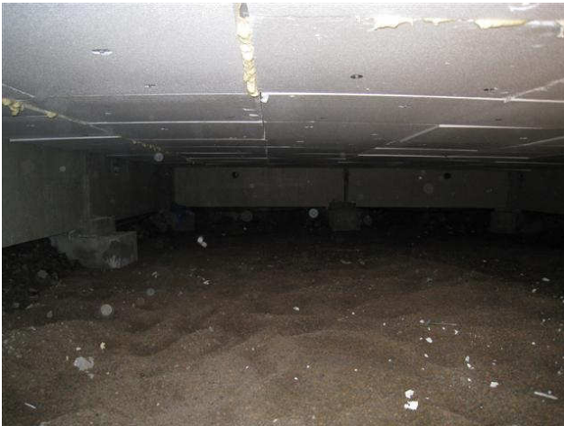
Kuva 3 Yleiskuva alustatiloihin tilan 125 ja 126 suuntaan. Pohjalla on kevytsoraa.
