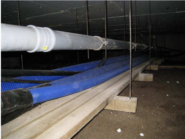
Kuva 19 Tilojen 109 A-C alla kulkeva kesto- puarina ja viemäri.
