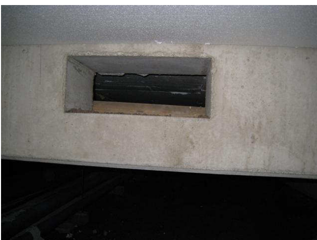
Kuva 23 Virtausaukko peruspalkissa tilan 132 alla.
