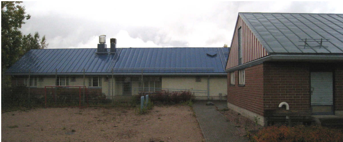
Eteläsivu, laajennusosaa vasemmalla
