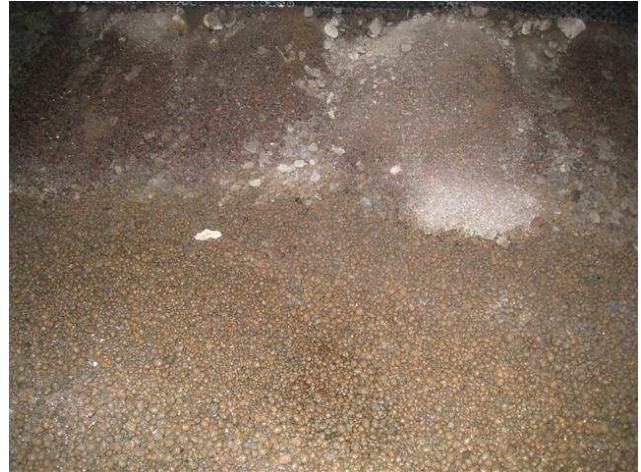
Kuva 26 Kosteaa kevytsoran alla oli vettä väh. 10 cm syvyydeltä tilojen 116 – 120 alla, jossa alustatilan korkeus on lähes 1,5 m.
