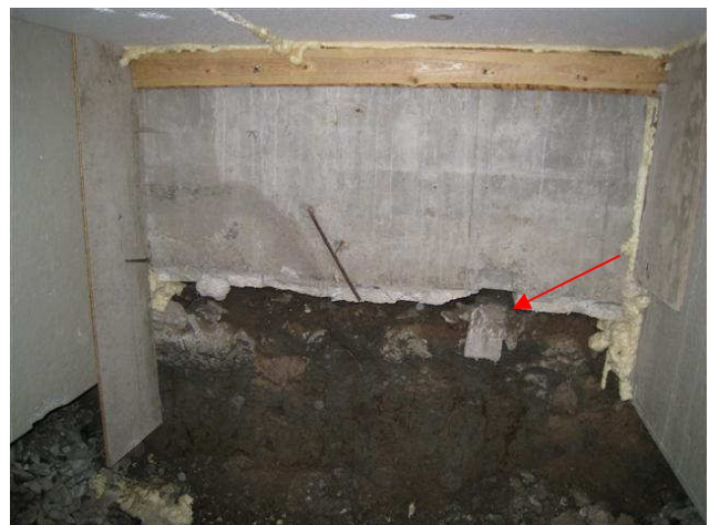
Kuva 12 Alkuperäisen ja laajennuksen rajalla on savimaata ja sen päällä hiekkaa. Palkin
