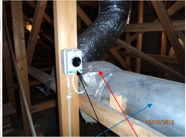
kuva 4 Alustatilaan palveleva kanavapuhallin (10 PF8), äänenvaimennin ja turvakytkin.
