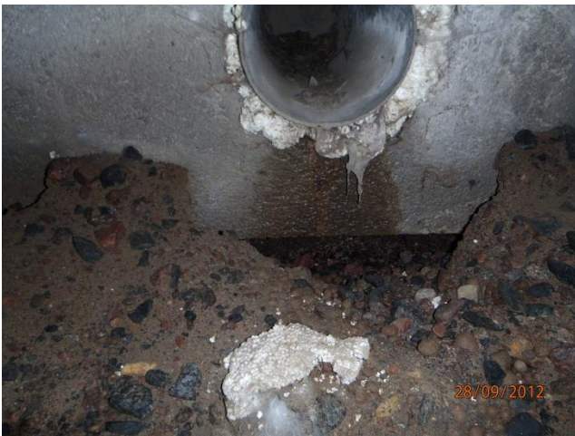
kuva 5 Kosteusjälkiä sokkeliläpiviennissä. (A4)
