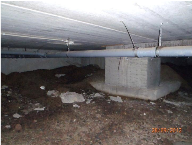
kuva 17 Alustatilan pohjalla on ohut kerros sepeliä.
