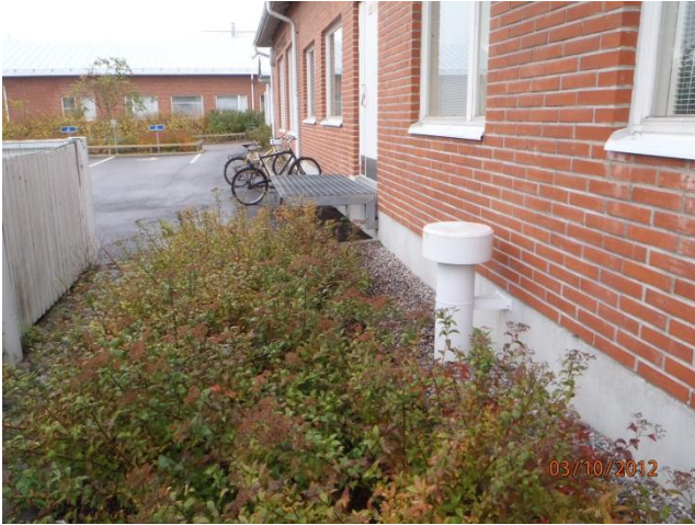
kuva 3 Alustatilan korvausilmakanava. (R3,1-S3,1)
