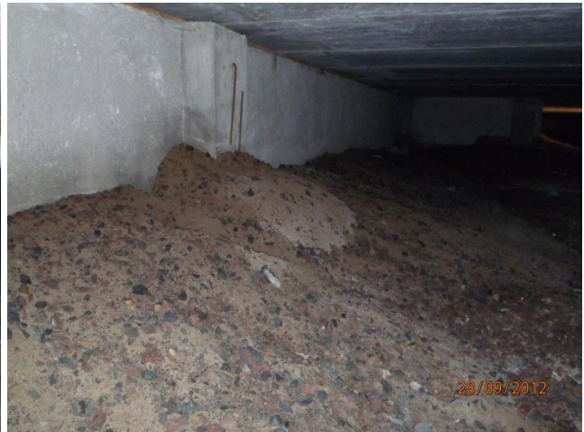
kuva 18 Sepelin seassa näkyy hienojakoista hiekkaa.
