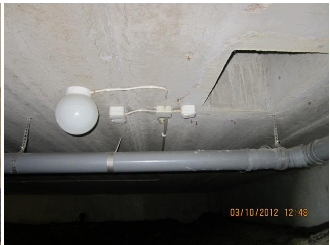
kuva 8 Alustatila on valaistu kaikkien kulkuluukkujen kohdalta ja osittain myös muualta.
