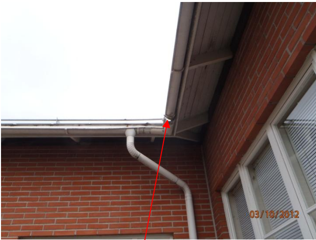
kuva 15 Rännien saumoja on useita repeytyneet auki.
