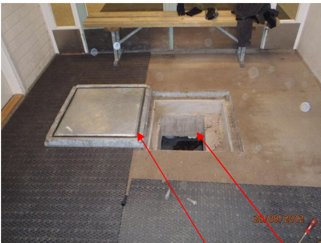
kuva 7 Kulkuluukuissa on kumitiivisteet. Kalkuaukko on hyvin ahdas.
