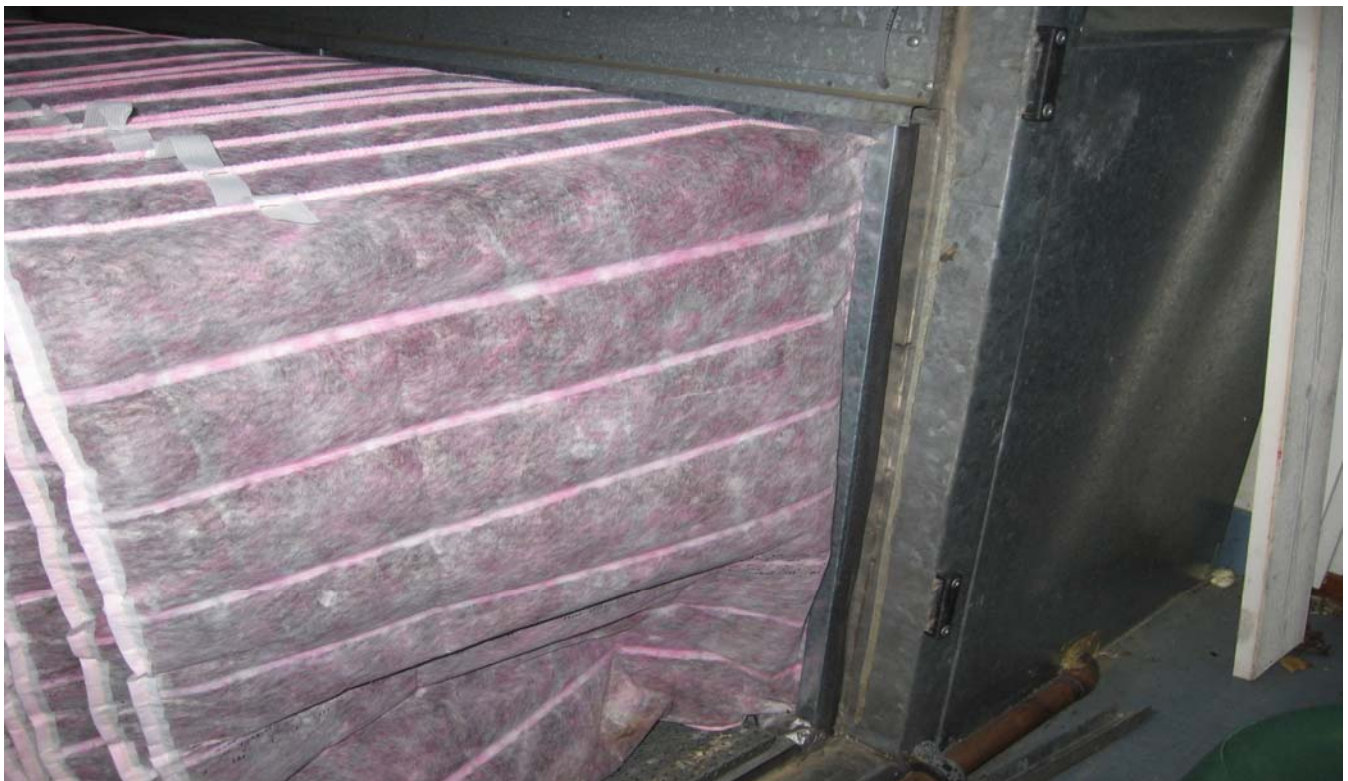
KUVA 22. Suodattimet ovat melko puhtaat, mutta suodatinseinät eivät ole tiiviitä.
