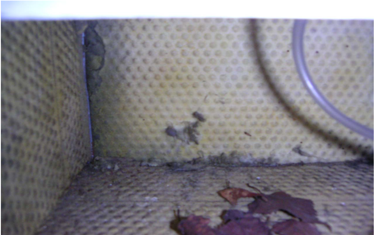
KUVA 3. Tasauslaatikoissa on paljon roskaa.
