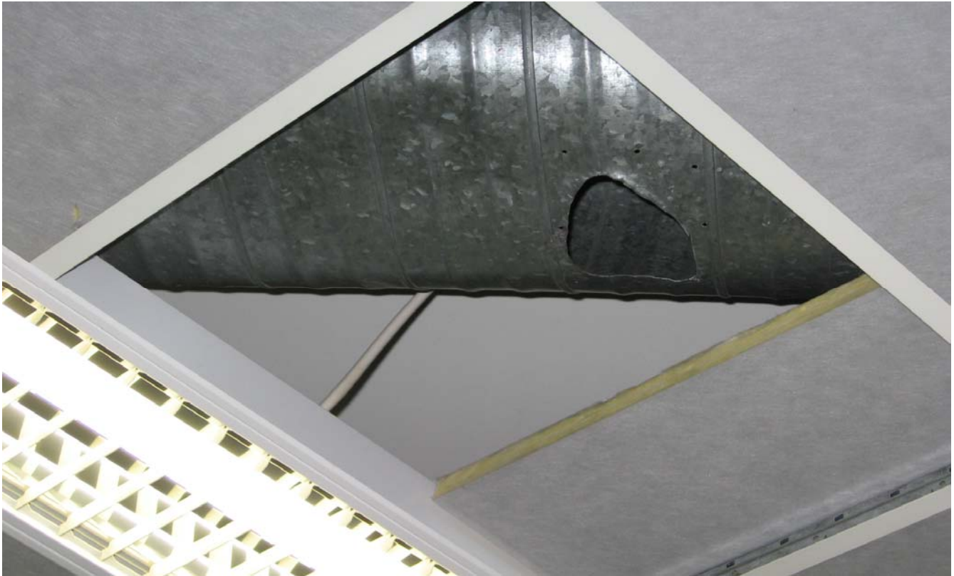
KUVA 17. Tuloilmakanavassa on reikä.
