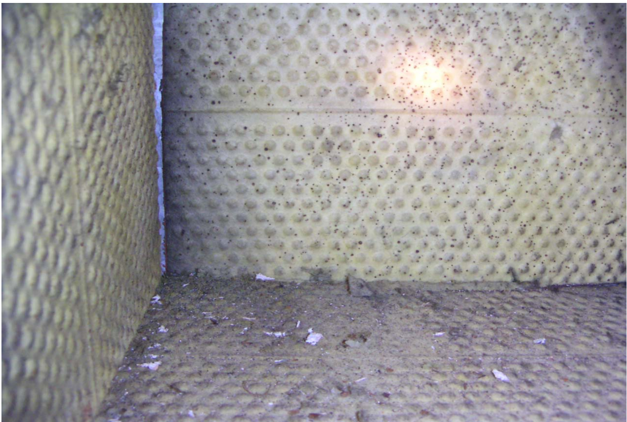
KUVA 4. Tasauslaatikoissa on paljon roskaa ja villan kappaleita.
