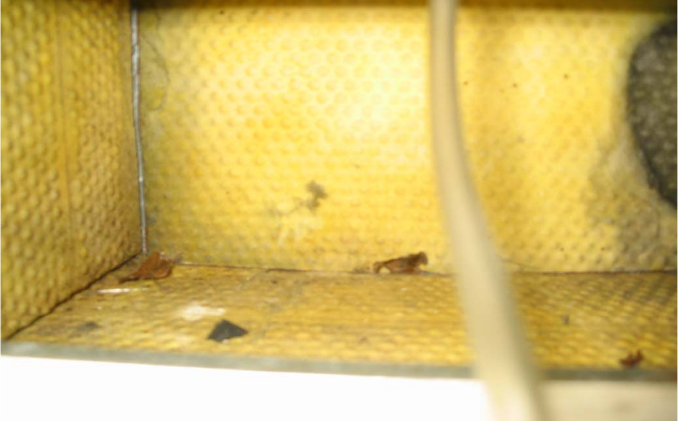
KUVA 11. Lepohuoneen n:o 41 tasauslaatikossa on puunlehtiä.
