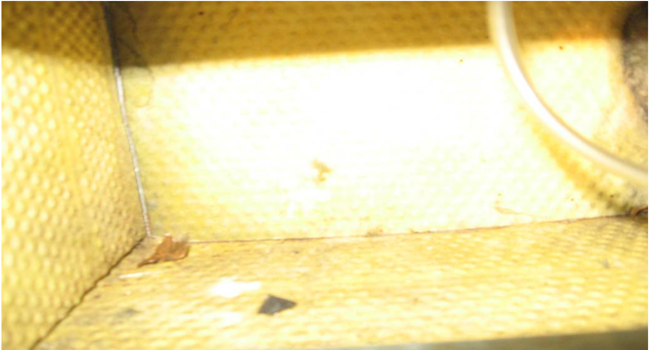
KUVA 19. Lepohuoneen n:o 41 tasauslaatikossa on puunlehtiä.
