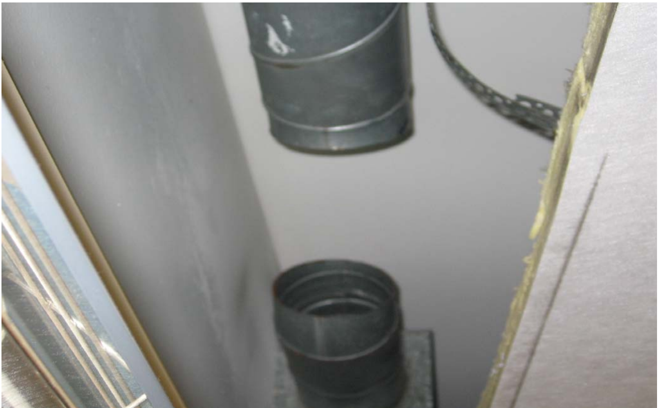
KUVA 18. Leikkihuoneesta n:o 13 puuttuu IV- kanavaa.
