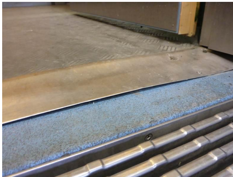
Kuva 8. Keittiön 136 tuulikaappiin 155 johtavan oven kynnyksistä on osittain irti. Keittiön 136 lattian pesuvesiä voi päästä kynnyksistä alle. Riippuen kahden lattiapäällysteen liitoskohdan tiiveydestä pesuvesiä voi päästä myös lattiapäällysteiden alle.
