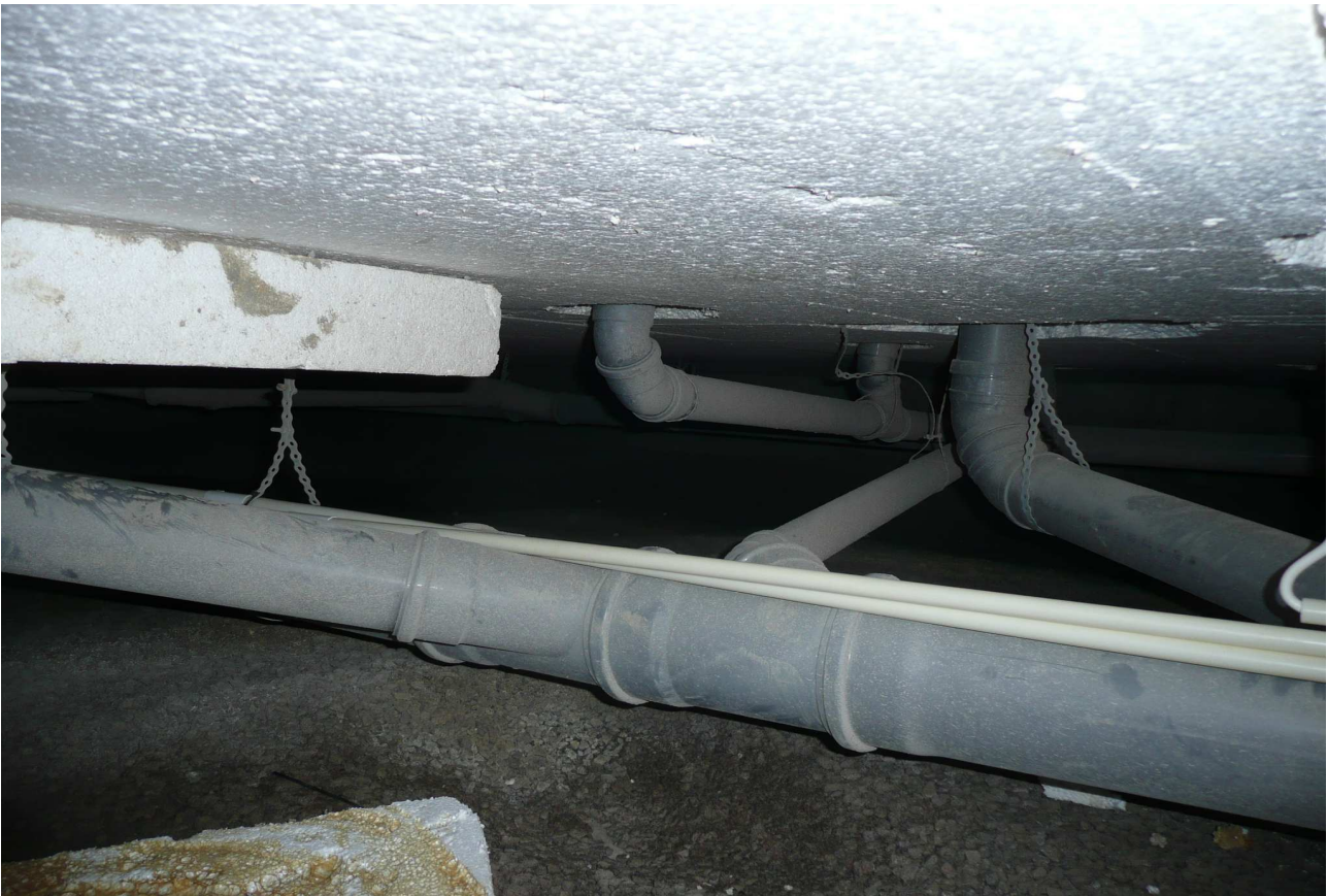
RAK- kuva 5. Yleiskuva alapohjasta.
