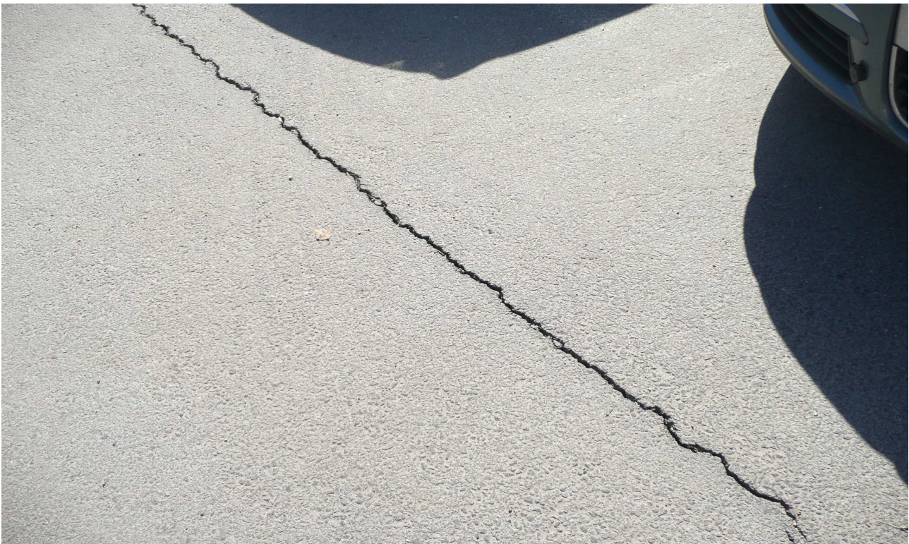
RAK- kuva 2. Yleiskuva asfalttipihalta.
