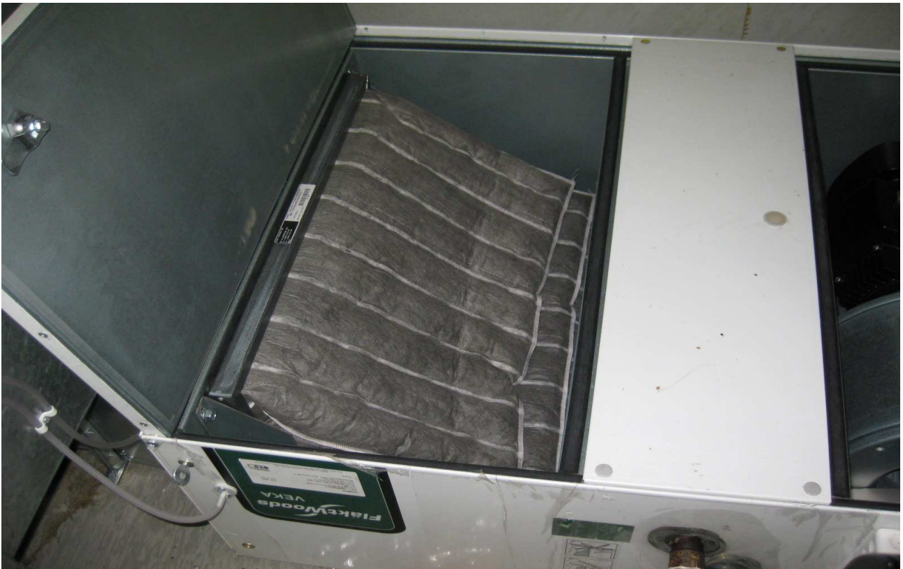
LVI- kuva 12. Yleiskuva alustatilan tuloilmakoneen suodattimesta.
