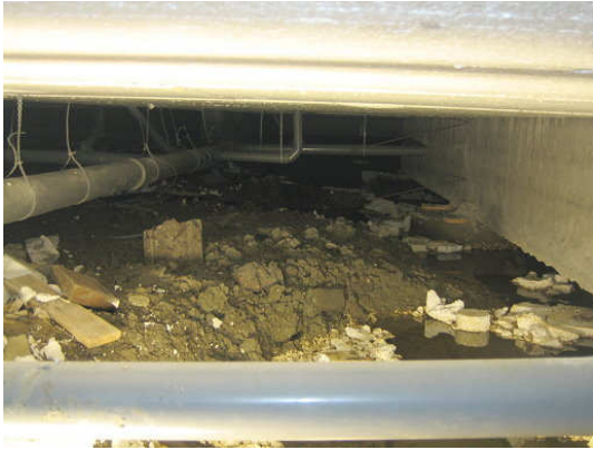
Kuva 1 Alustatilan maapohjana on mm. sa-vea.
