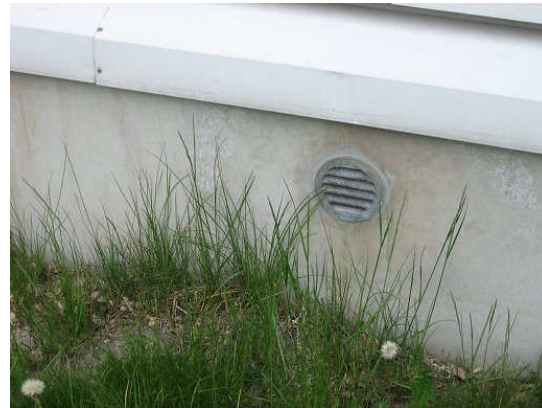
Kuva 10 Sokkelielementissä oleva tuuletusaukko.
