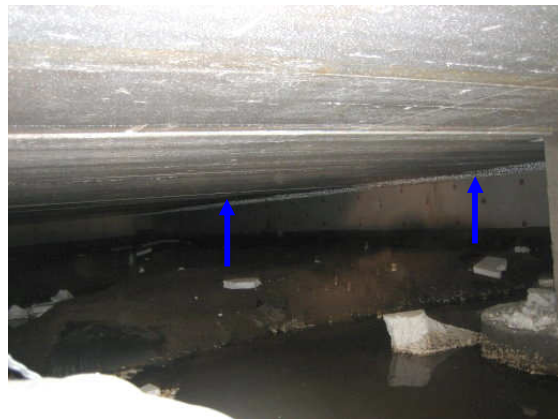
Kuva 4 Vesistönpuoleisella sivustalla on kosteutta tiivistynyt ontelolaatan polystyreenilevyjen pintaan.
