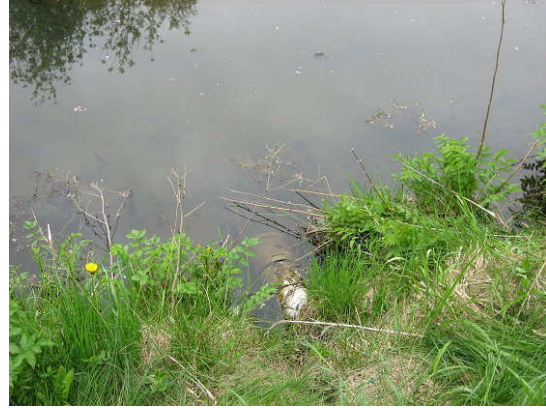
Kuva 14 Purkuputki on veden pinnan alapuolella. Vedenpinnasta sokkelin yläpintaan on noin 160 cm.
