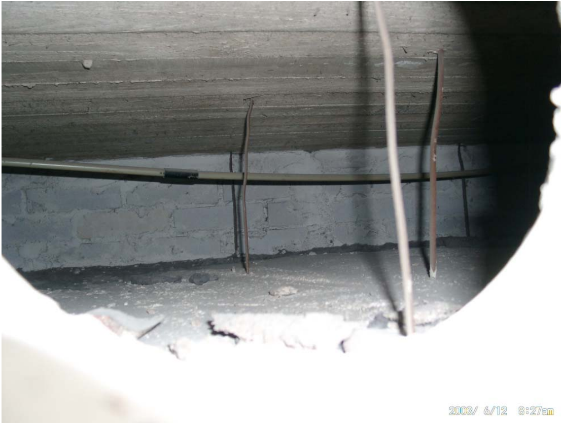
Kuva 1.IV-kanavissa oli roskaa ja pölyä. Kuva on otettu Voimistelusalin poistoventtiilistä. Huoneen 014 tuloilmakanavassa oli paljon roskaa, esim. hyönteisten raatoja.
