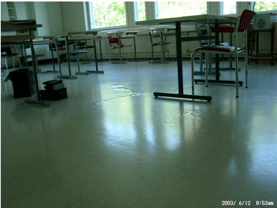
Kuva 2.Luonnonopin luokan lattian muovimatto oli irronnut lattiasta. Vaikutti sille kuin maton kopo kohdat noudattelisivat mahdollisia lattiassa olevia halkeamia.
