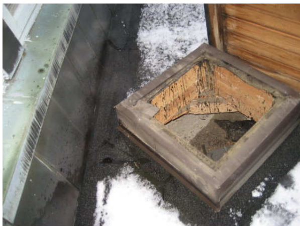
Kuva 19 Länsisivun kattoluukku, jonka kohdalta tutkittiin ulkoseinän alaosaa.
