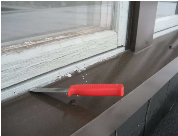
Kuva 11 Uusi vesipellititys on viety karmirakoon ja liittymässä on joustavakitti.
