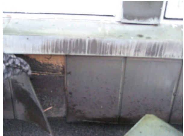
Kuva 18 Ikkunoiden alla oleva juurinoston avauskohta länsisivulla.
