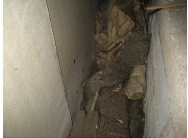
Kuva 22 Ulkoseinän vieressä on kivirakenteinen IV-kanava. Eristeenä on vuorivillaa.
