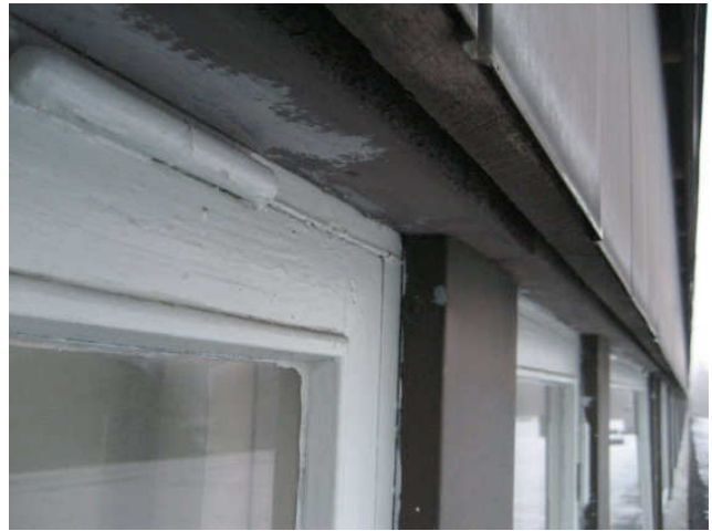
Kuva 4 Ikkunoiden yläosia suojaa ulkoseinän ulkoneva osa. Julkisivun pellitysten alle on tuuletusrako. Räystäs on ok.
