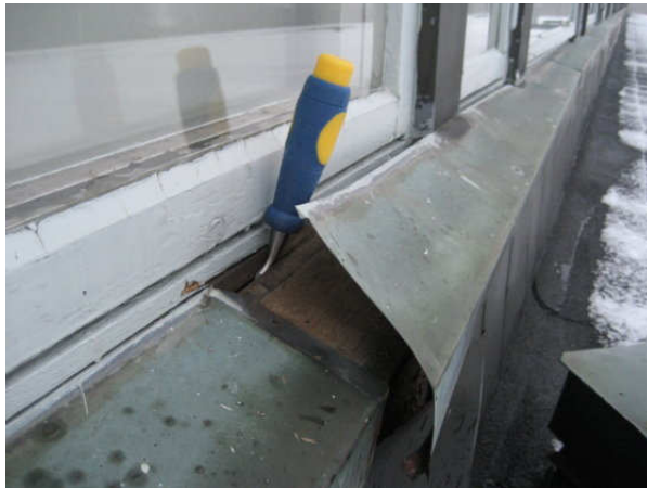
Kuva 17 Vesipellityksen avauskohta länsisivulla
