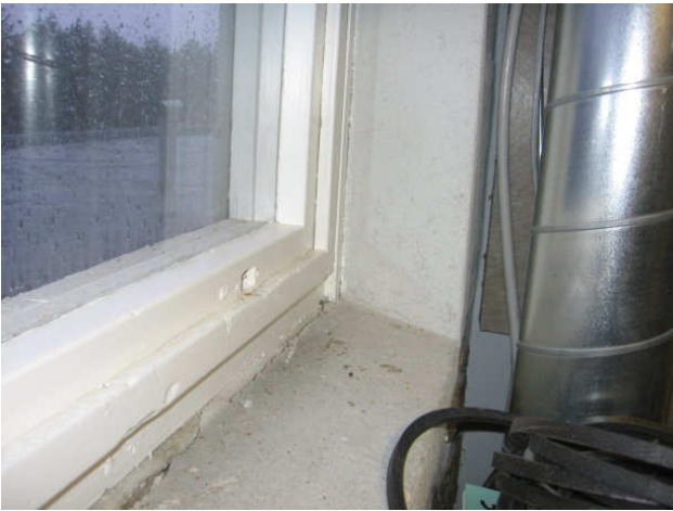
Kuva 3 A-osan IV-konehuoneen ikkuna. Sisäseinät ovat kiviaineisia.
