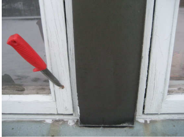
Kuva 12 Puitteiden ulkopinnassa on pintalahoja. Käyntivälit vaihtelevat.
