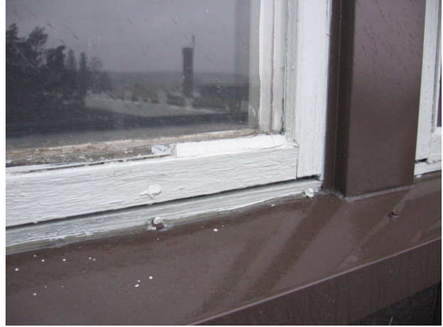
Kuva 10 Alapuitteiden lasituskitit ovat lohkeilleet.
