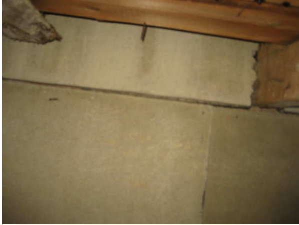
Kuva 21 Luukun kohdalla oleva ulkoseinän alaosa.
