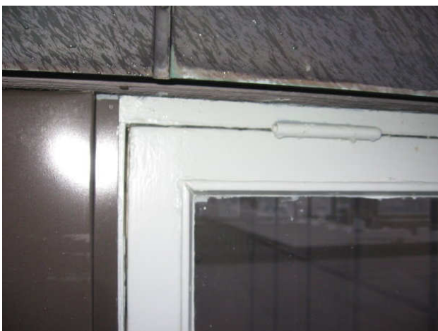
Kuva 7 Ikkunoiden yläosat ovat tyydyttävässä kunnossa.
