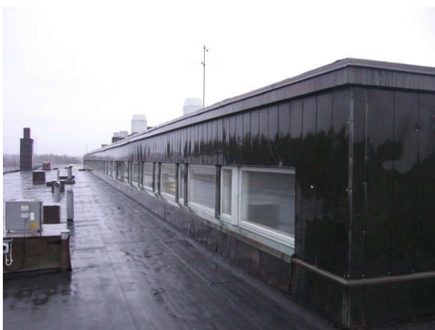
Kuva 1 Yleiskuva länsisivun ikkunoista.
