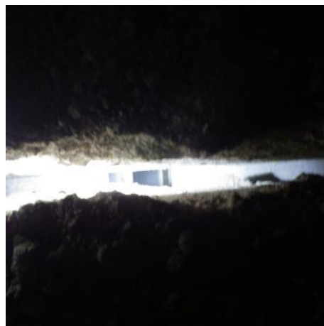
Kuva 11. Liikuntasauamasta on näköyhteys alapuolella, opetustilan A308 kohdalla, olevan käytävän alakattotilaan.
