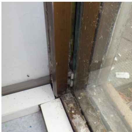
Kuva 40. Osa työsalin A244 ikkunoista on metallirunkoisia. Lasien kiinnitys puitteisiin on epätiivis kiinnityskitin haristumisesta johtuen.
