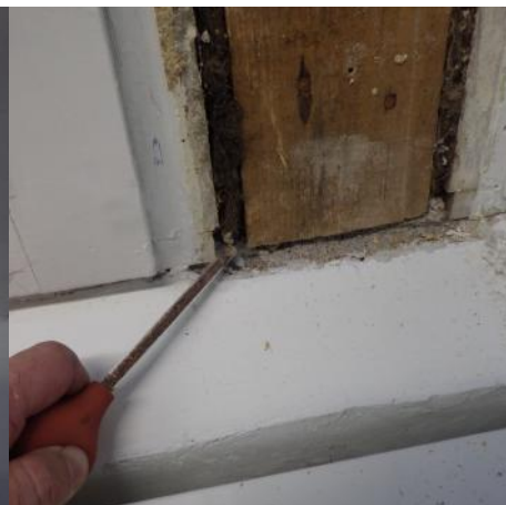
Kuva 6. Rakenneavaus kuvan 6 kohdasta. Näkyvissä ikkunoiden välinen rakenne.
