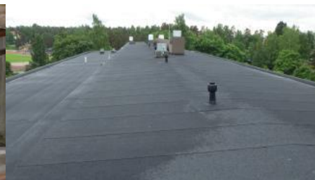
Kuva 15. Yleisnäkymä 4. kerroksen vesikatosta
