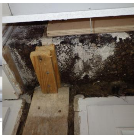
Kuva 4. Rakenneavaus kuvan 4 kohdasta. Näkyvissä ikkunoiden välinen rakenne ja leukapalkin korkkieristettä.
