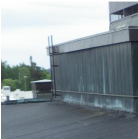
Kuva 42. 4. kerroksen katolle johtavat tikkaat.
