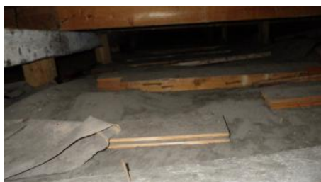
Kuva 16. Yleisnäkymä 4. kerroksen yläpohjan tuulettuvasta tilasta
