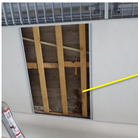
Kuva 25. Luokan A208 alakaton rakenneaukaisu kosteusvauriojäljen kohdalta.
