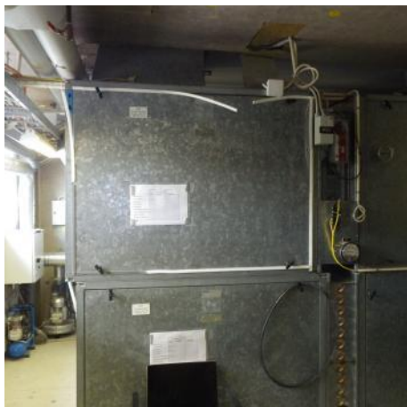
Kuva 51. IV-kammioiden luukkua on tiivistetty ulkopuolelle asennettujen tiivisteiden avulla.
