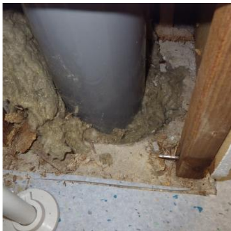
Kuva 35. Välipohjarakenne koteloiden välillä on kuiva.
