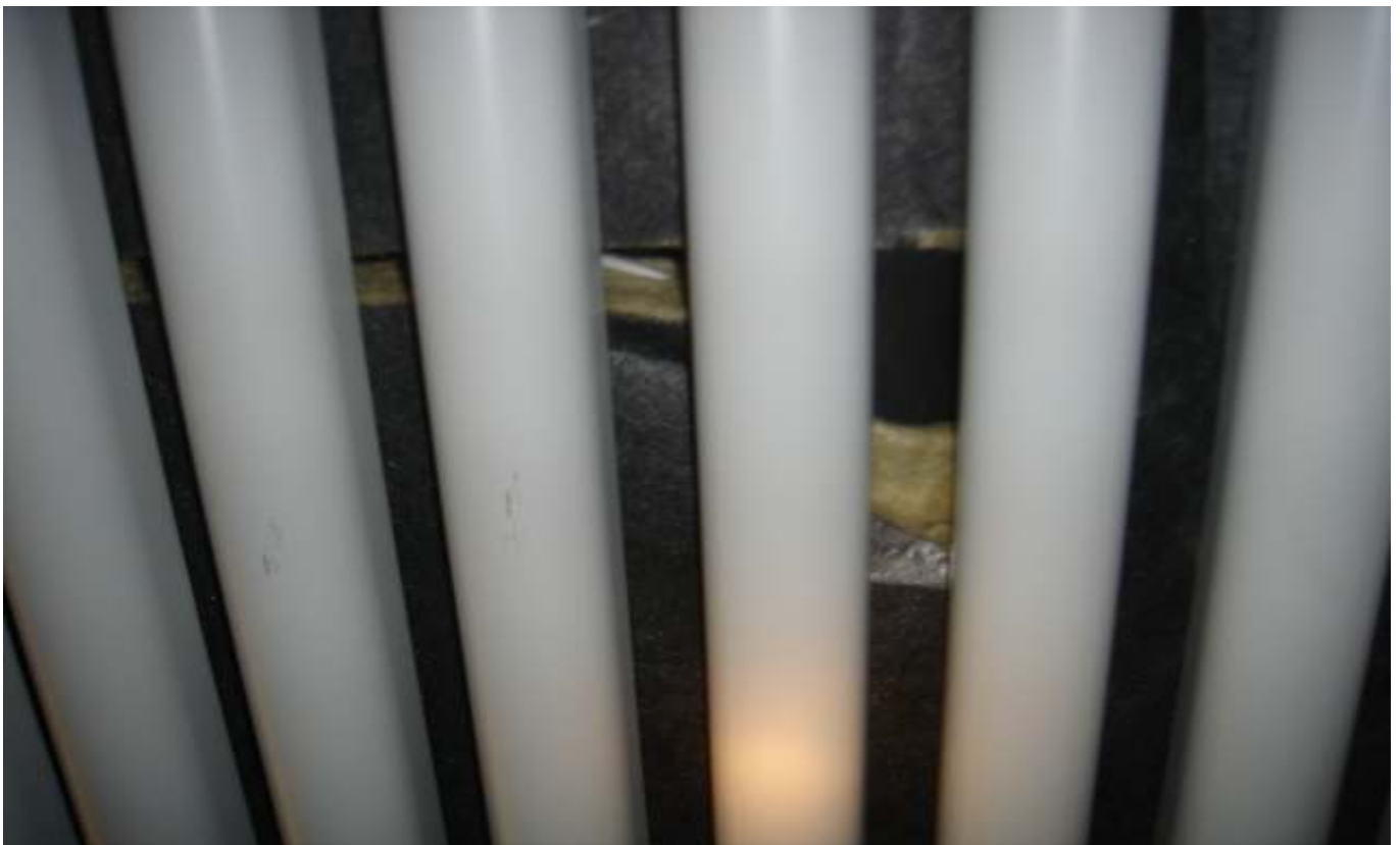
KUVA 33. Yleiskuva käytävän alakatosta.
