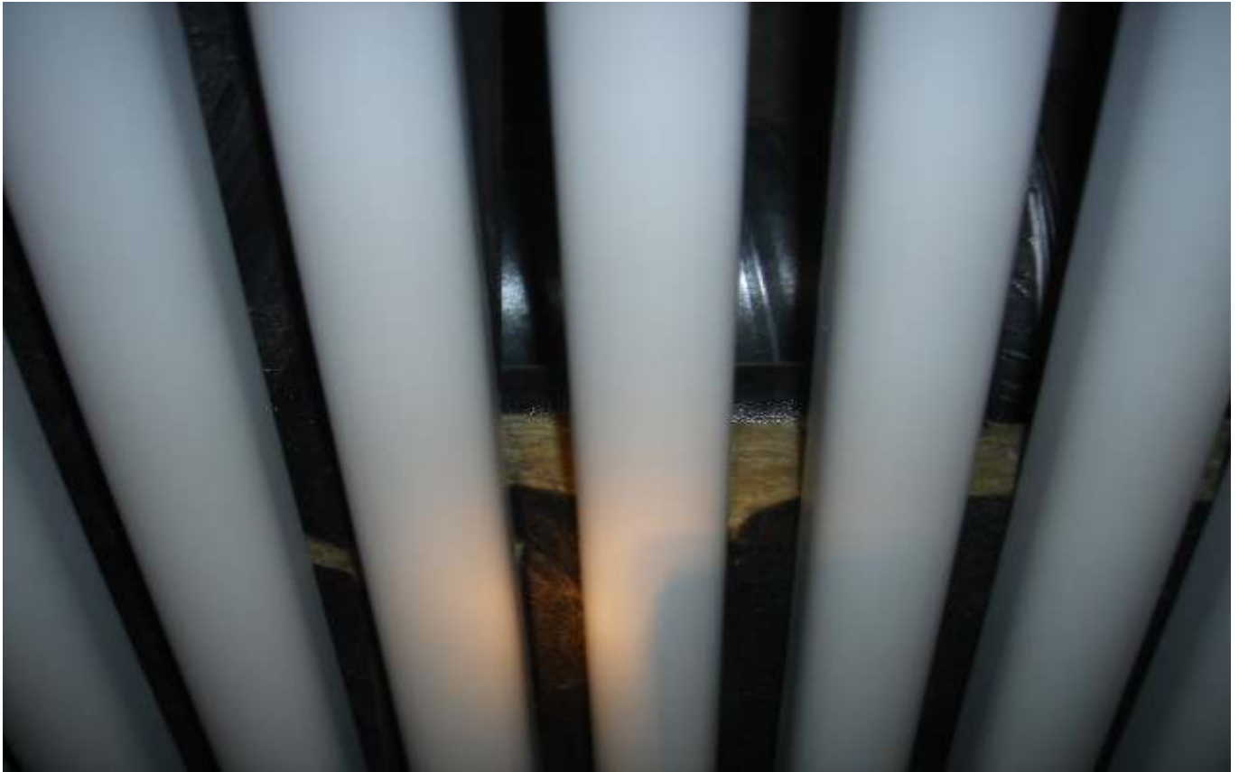
KUVA 32. Yleiskuva käytävän alakatosta.
