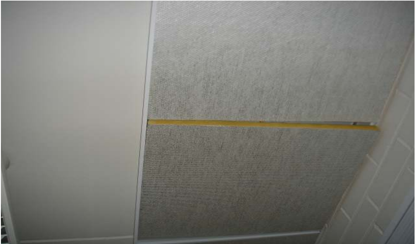
KUVA 34. Yleiskuva luokkahuoneen katosta.
