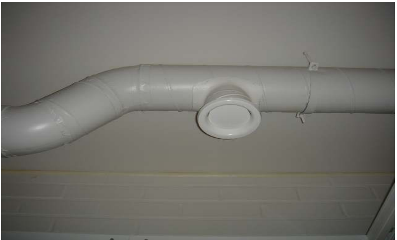
KUVA 29. Yleiskuva poistoilmaventtiilistä.
