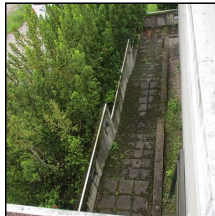
Itäpäädyn tukimuurissa on teräskorroosion aiheuttamia vaurioita. Rakennuksen takana olevat kulkutiet ovat heikossa kunnossa.
