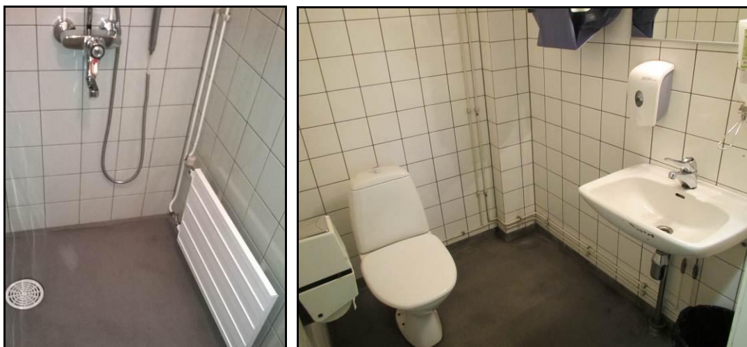
Märkätilojen rakenteet ovat pääasiassa tyydyttävässä kunnossa.
