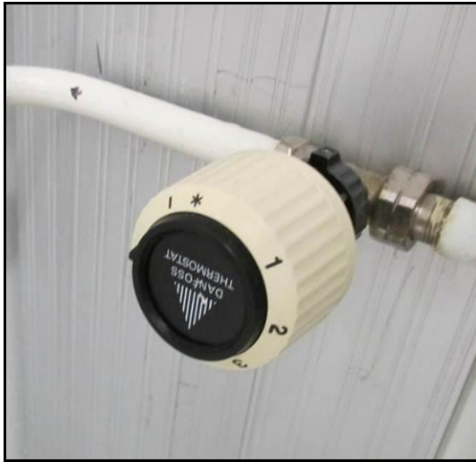
Yleiskuva termostaattisesta patteriventtiilistä.
