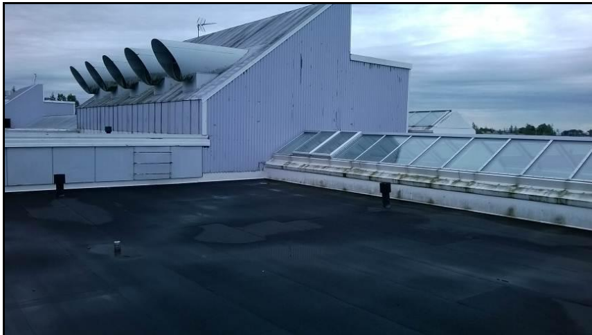
Vesikatetta on osin uusittu rakennuksen länsipäädyssä.
