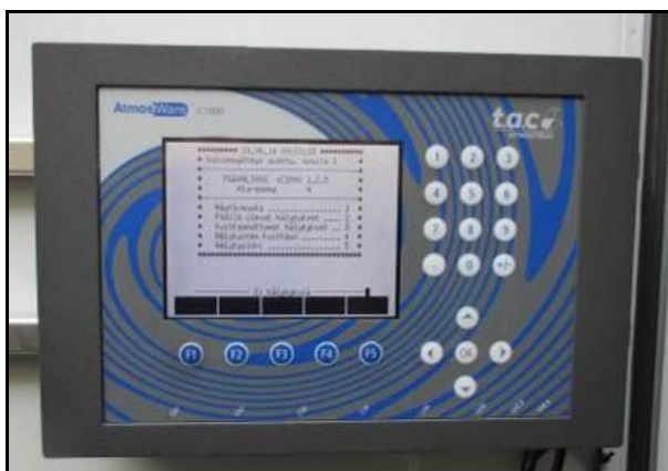
Valvonta-alakeskuksen käyttölaite.
