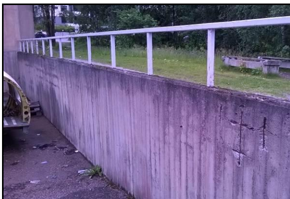
Itäpäädyn tukimuurissa on teräskorroosion aiheuttamia vaurioita. Rakennuksen takana olevat kulkutiet ovat heikossa kunnossa.
