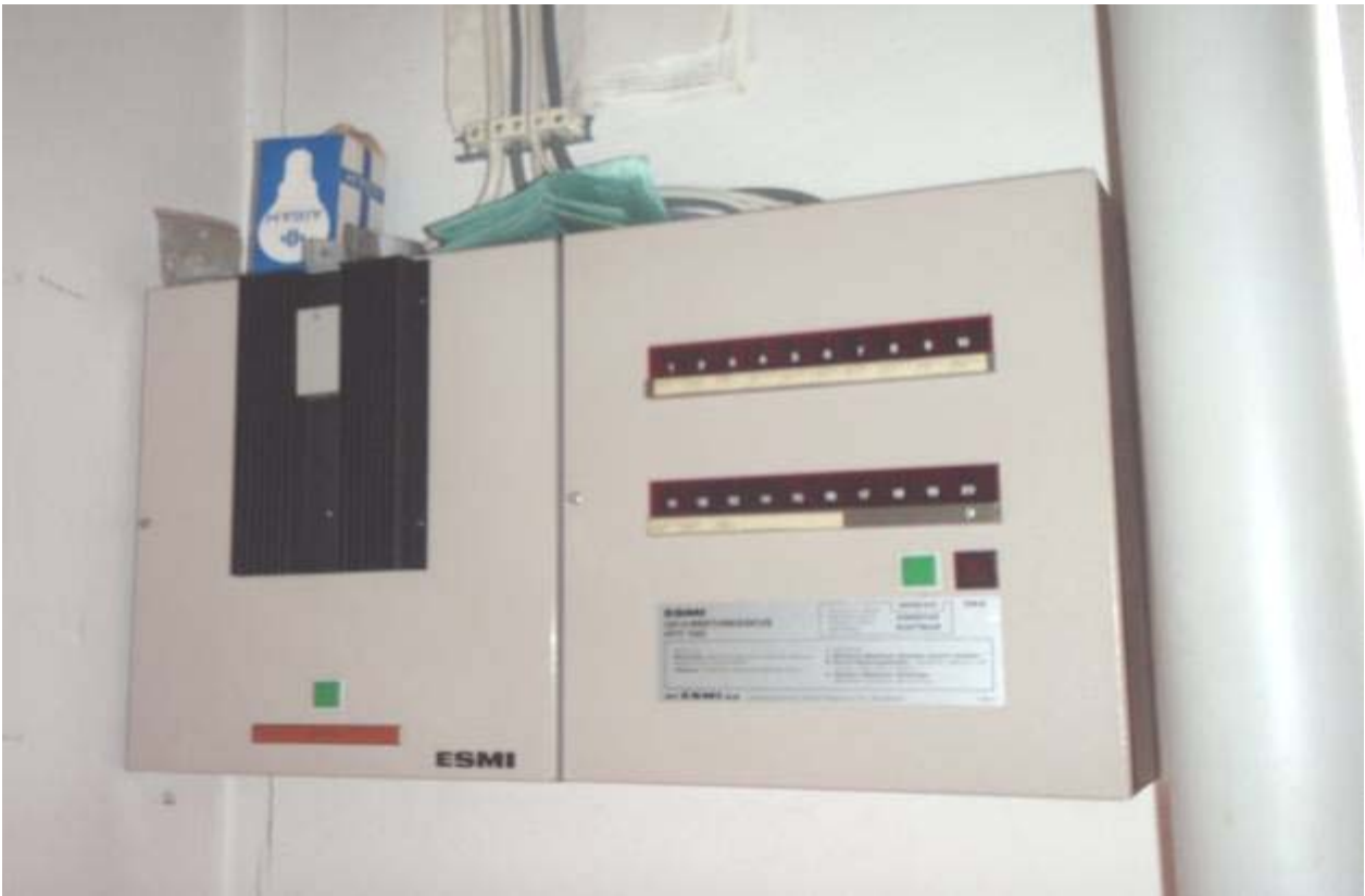
S-KUVA 13. Ovimerkkivalaistuksen keskus ja LVI- hälytyskeskus
