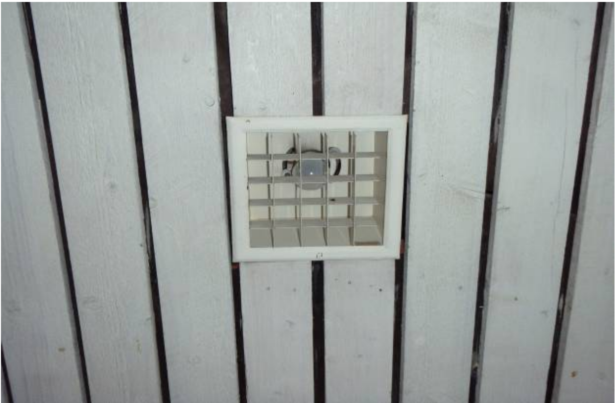
S-KUVA 1. Sisäänkäynnin valaistus
