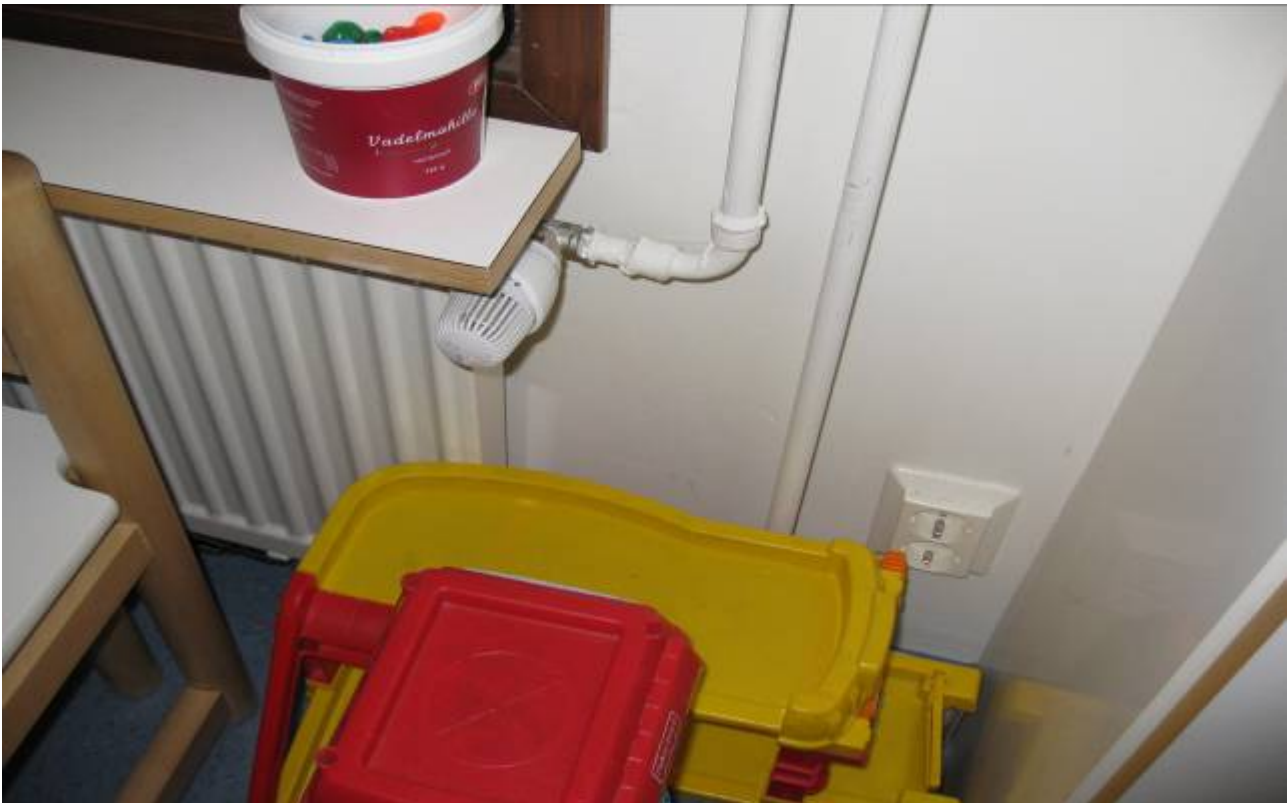
LVI-kuva 3. Yleiskuva uudesta patteriventtiileistä.
