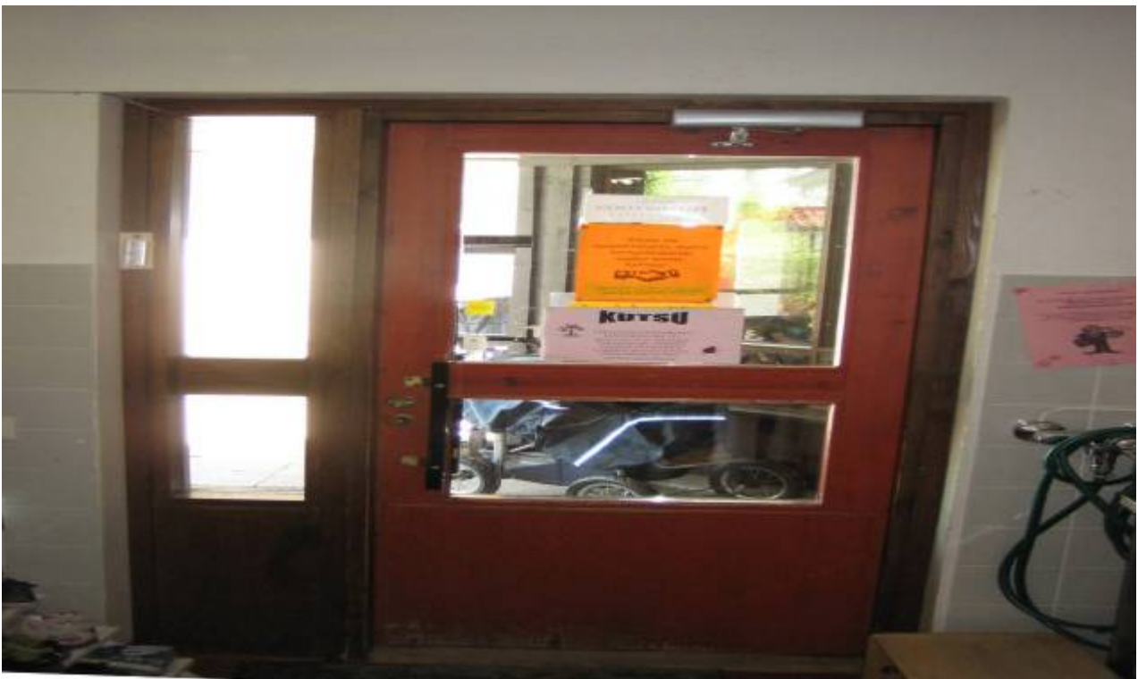
RAK-KUVA 10. Alkuperäiset ulko-ovirakenteet arvioitiin edellyttävän kunnostustoimenpiteitä.
