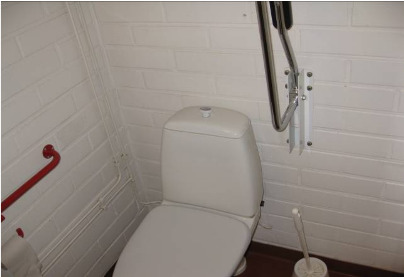
LVI-kuva 7. Yleiskuva vanhoista wc-istuimista.
