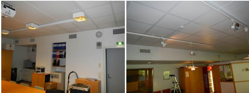
Kuvat 43-44. Tuloilman ja poistoilman pääte-elimet.
