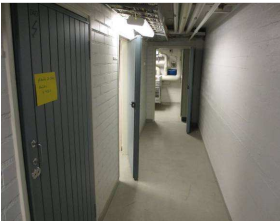
Kellarikerroksen tiloissa havaittiin yleisesti kohonneita kosteuspitoisuuksia
