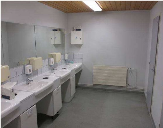
yläkerroksen miesten wc- tiloissa ei havaittu viitteitä kosteusvaurioista
