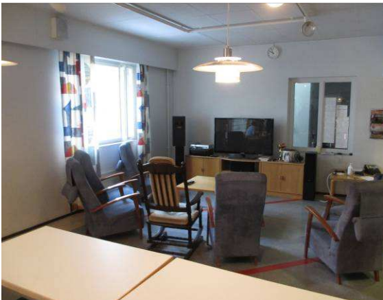
1. kerroksen yleisissä tiloissa ei viitteitä kosteusongelmista
