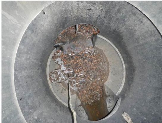
Kuva 28. Kaivon pohjakourussa sora, svk1.
