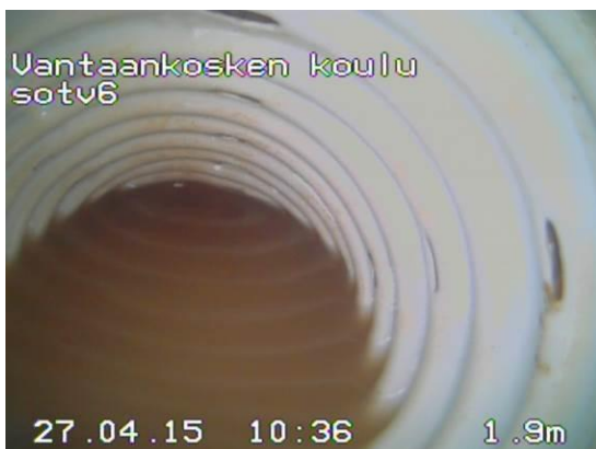
Kuva 43. Painuma ja tukkeuma, ei saatu pestyä auki, sotv6.
