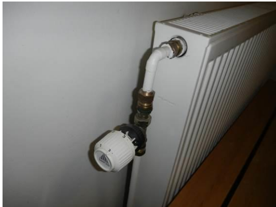
Kuva 6. Vanha patteriventtiili, merkki Danfoss.
