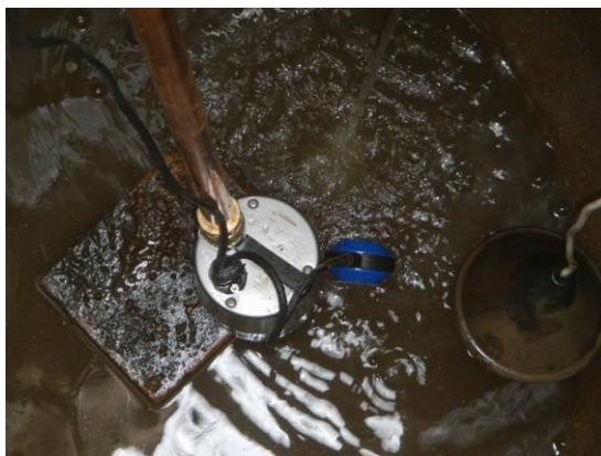
Kuva 37. Uusittu pumppu.
