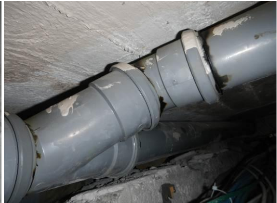
Kuva 19. Uusittuja muoviviemäreitä kellari-kerroksessa.
