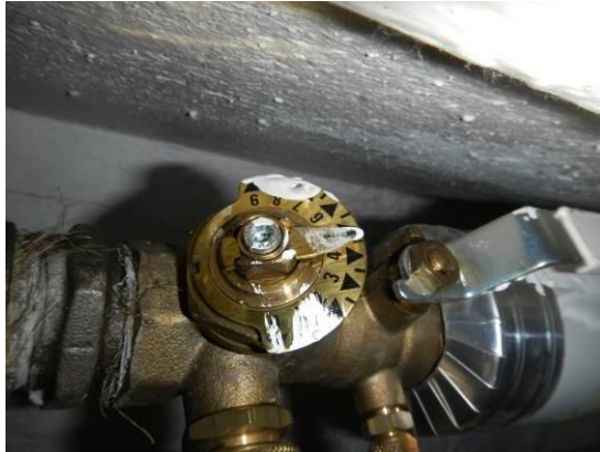
Kuva 4. Lämpöjohtoverkoston virtaamat on näyttötaulujen mukaan säädetty.
