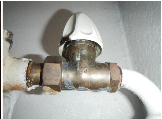
Kuva 7. Vanha patteriventtiili, vuotojälkiä.
