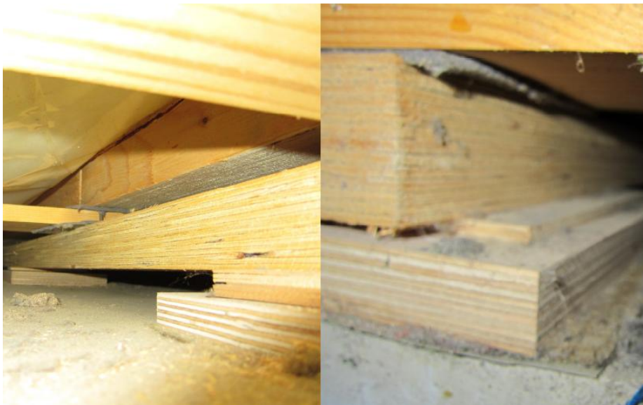
Kuva 4. Liikuntasalin puurakenteisessa aluejoustavassa lattiassa ei havaittu kosteuden aiheuttamaa vaurioitumista.
