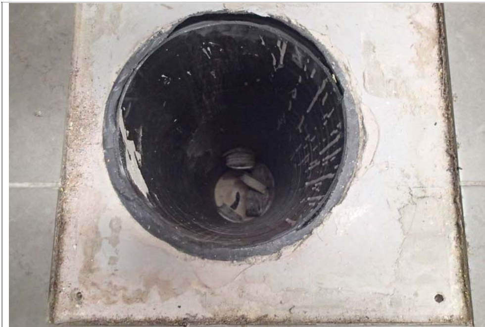
Kuva 13: Luokassa B045 on salaojan tarkastuskaivo. Kaivo oli kuiva, kaulus tiivis, ei havaittu poikkeavaa hajua.
