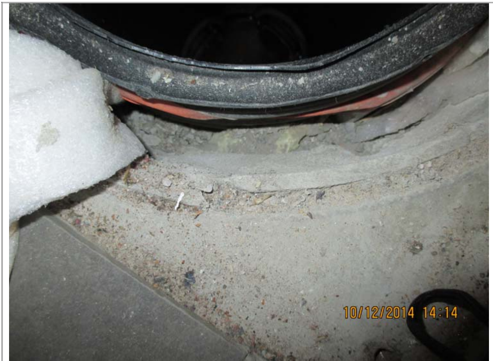
Kuva 18: Tarkastuskaivon liitos betonilaattaan on epätiivis. Maaperästä välittyvillä hajuilla on yhteys sisäilmaan epätiivin kannen kautta.
