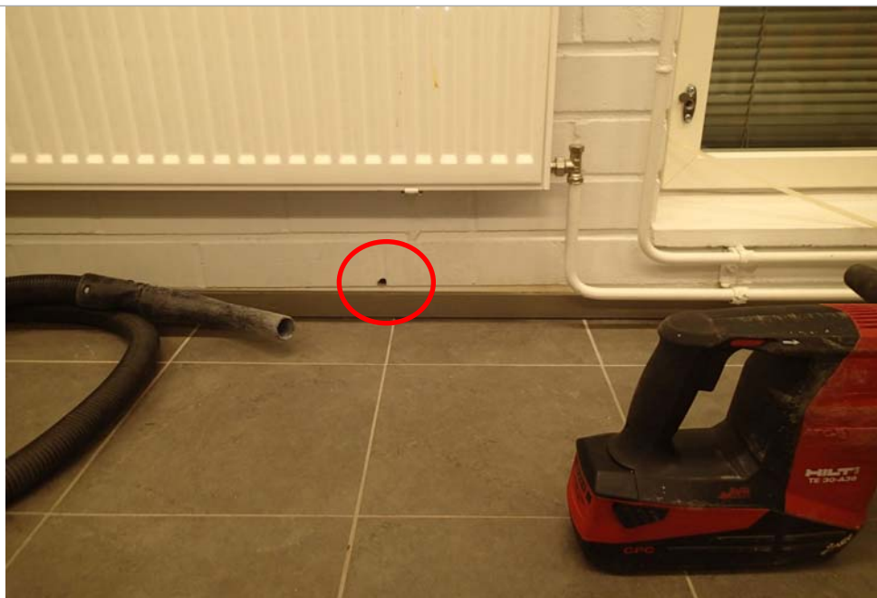
Kuva 4: Ulkoseinärakenteen eristeestä otettiin ko. tutkimusreiästä yksi materiaalinäyte, ei viitettä vauriosta.
