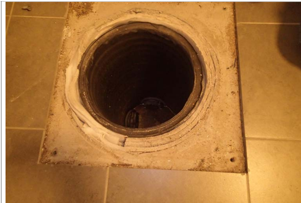
Kuva 17: Käytävällä B094 on salaojien tarkastuskaivo.
