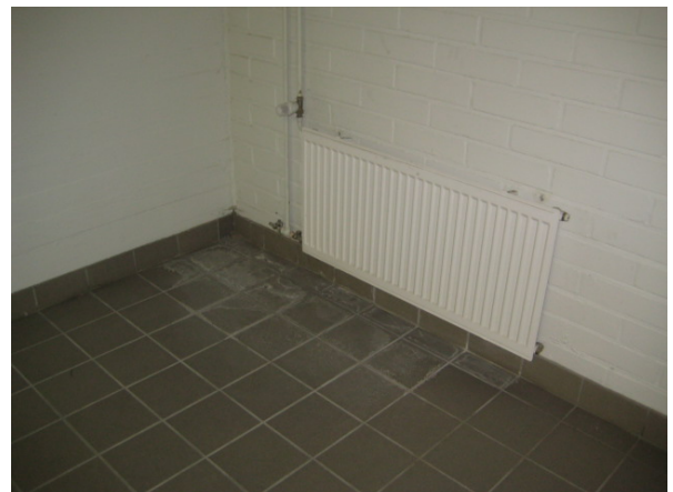
Kuva 6. Lattian seinän vierustat olivat "kosteita". Kuvan kalkkimuodostuma lattiapinnalla todennäköisesti johtuu kuitenkin patterin vahasta vesivuodosta (tila 068).
