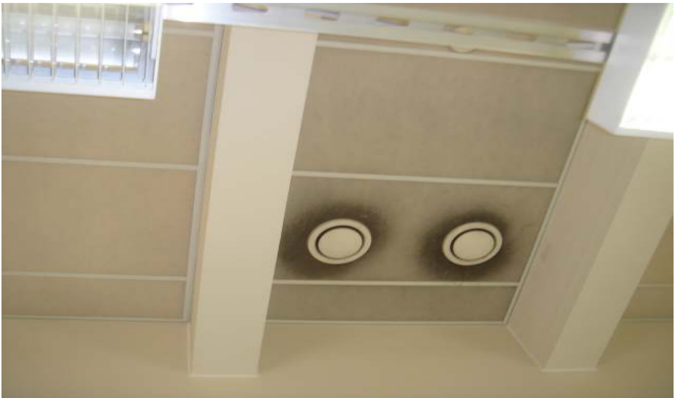
KUVA 16. Yleiskuva luokkatilojen kattolevyistä.
