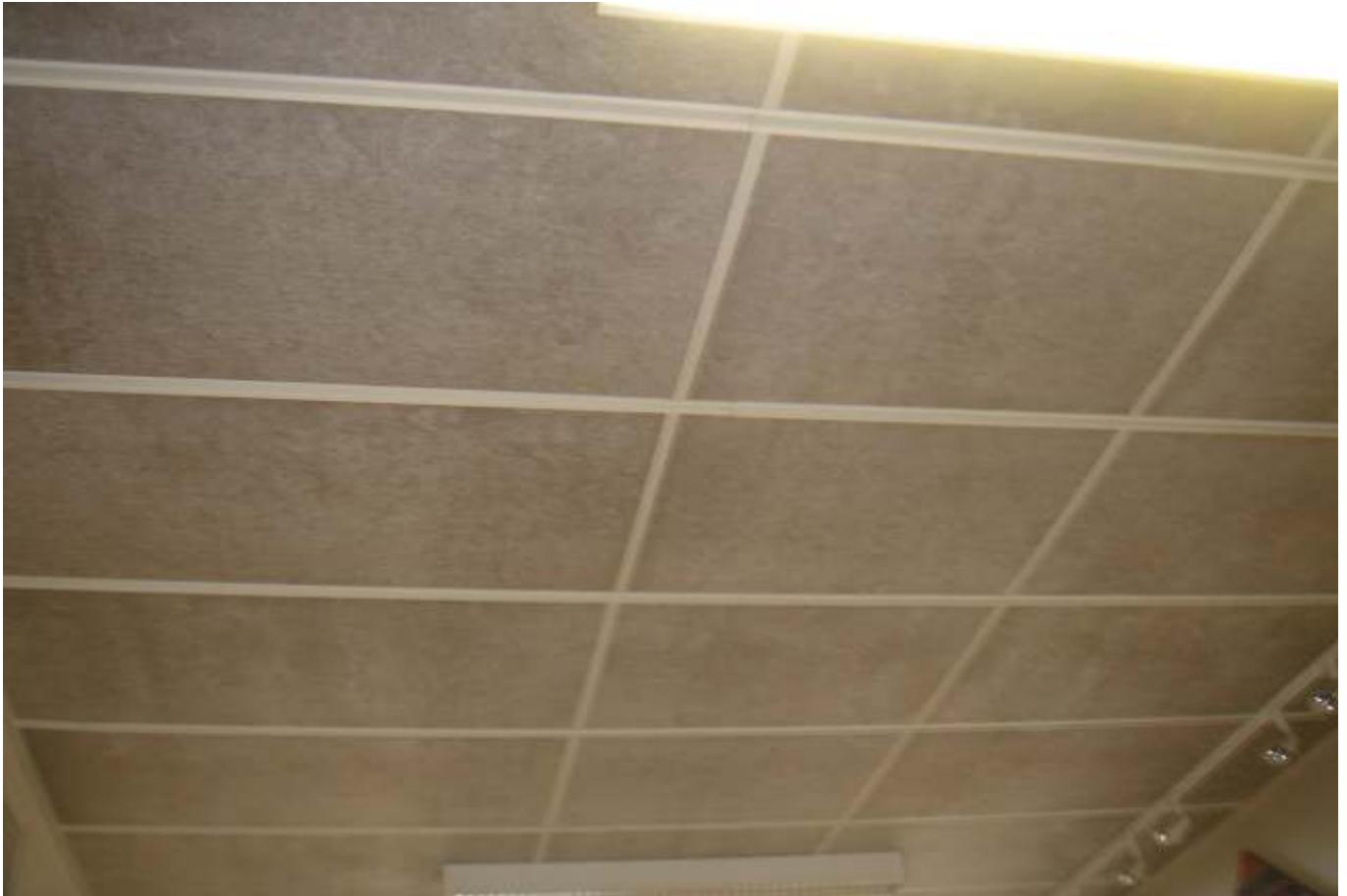
KUVA 17. Yleiskuva käytävän kattolevyistä.
