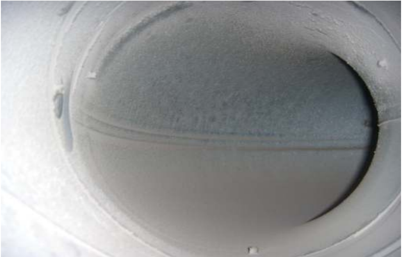
KUVA 9. Yleiskuva luokkatilojen poistoilmakanavasta.
