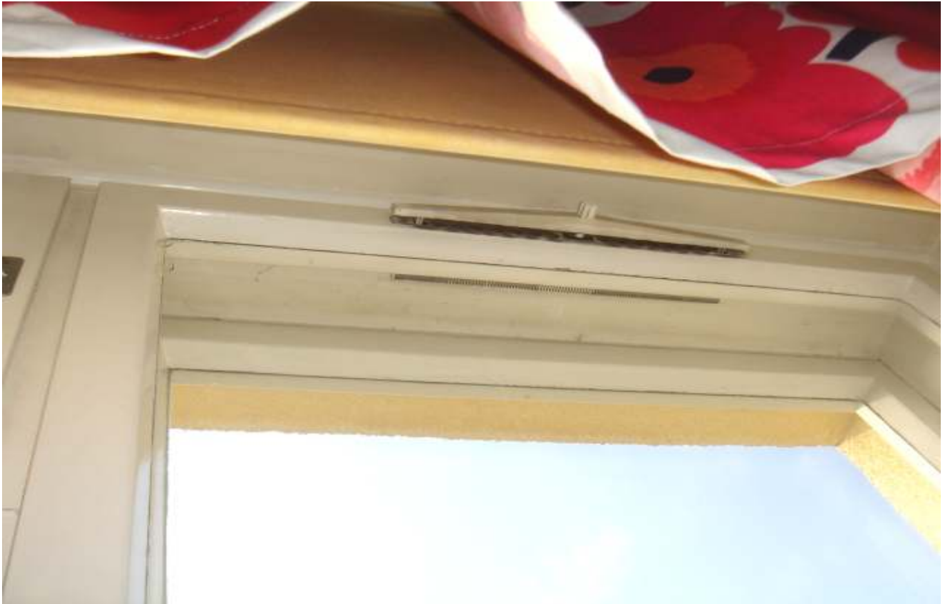
KUVA 13. Yleiskuva luokan korvausilmaventtiilistä, jossa ei ole ulkokarmissa rakoventtiiliä.
