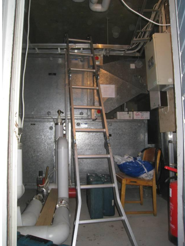
KUVA 3 IV-konehuone, jonka takaseinälle tehtiin tutkimusavaus kantavaan betoniseinään IV-koneiden yläpuolelle tikkaiden kohdalle.
