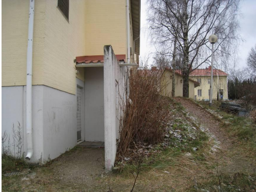
KUVA 1 Lisärakennus IV-konehuoneen kulmalta
