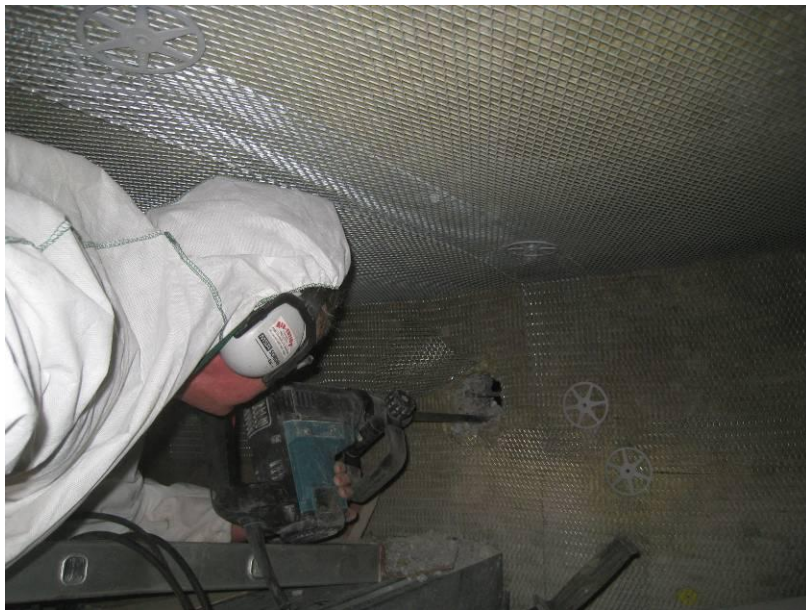
KUVA 4 Tutkimusavauksen teko käynnissä. Avauskohdalla oli rautoitteita.
