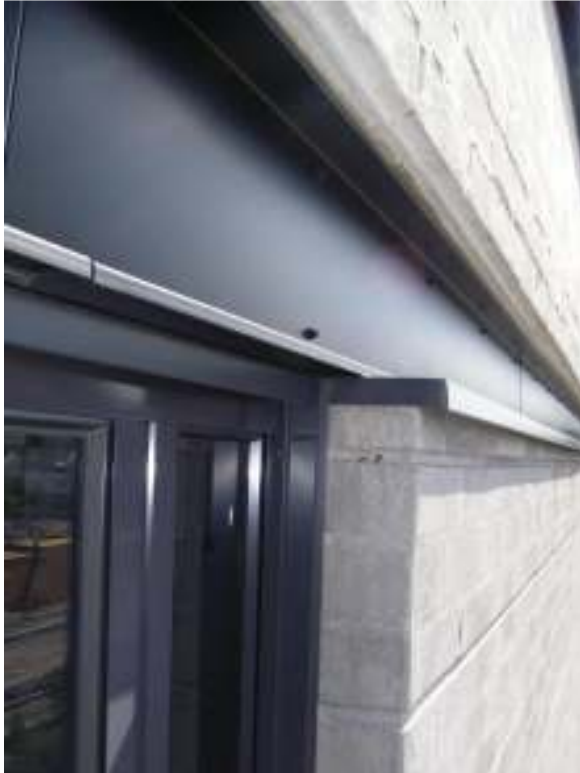
Kuva 9. Pellin taustalla on todennäköisesti tuuletusrako (ei avattu)
