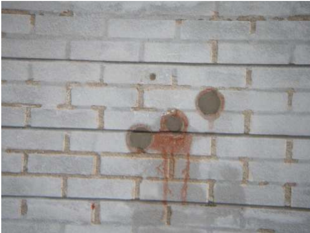
Kuva 1. Näytteet rapautuneesta kohdasta, näytekohta T1
