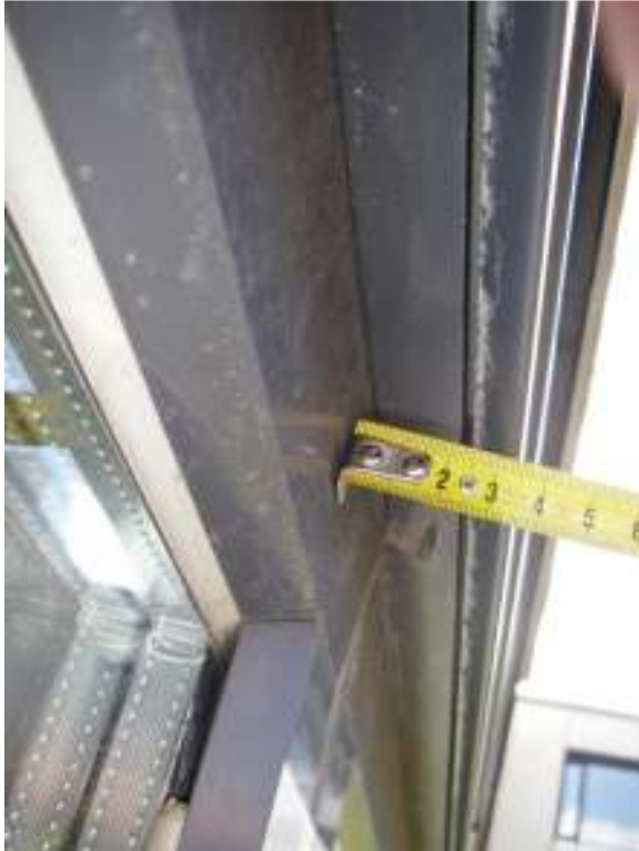
Kuva 11. Pieni tuuletusrako ikkunan yläpuolella, linja D
