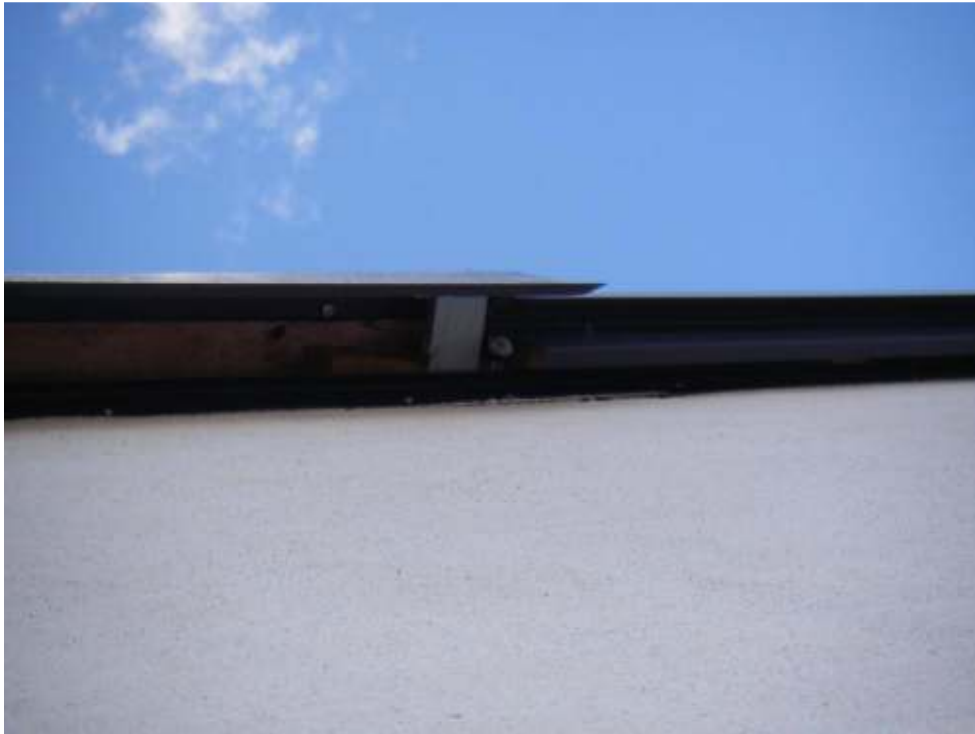
Kuva 15. Rästään rakenteita linjalla 29, itäisivulla
