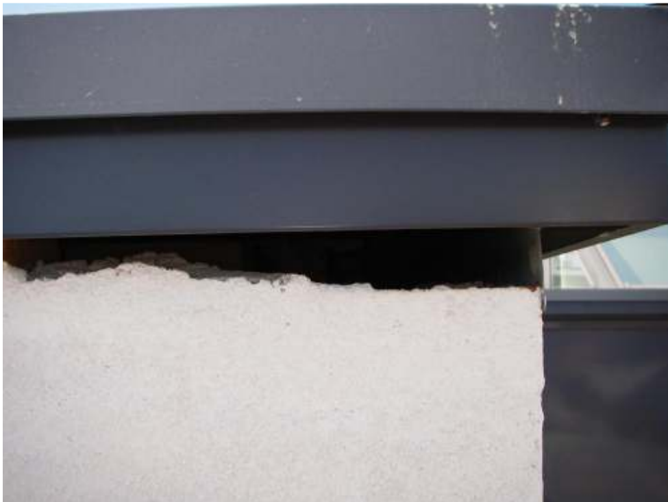
Kuva 16. Rästäällä aukko itäisivulla, oikealla alhaalla ulko-ovi, linja 29
