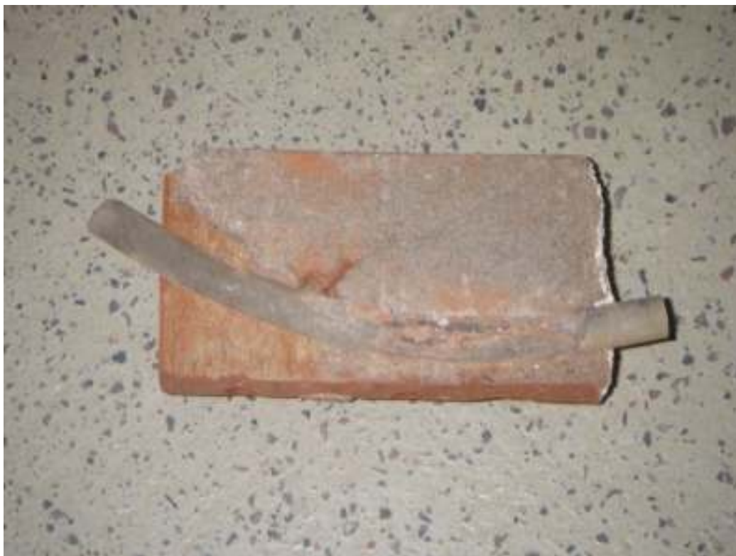
Kuva 2. Tuuletusputki on taivutettu tuuletusraon sisään, näyte linjalta 29
