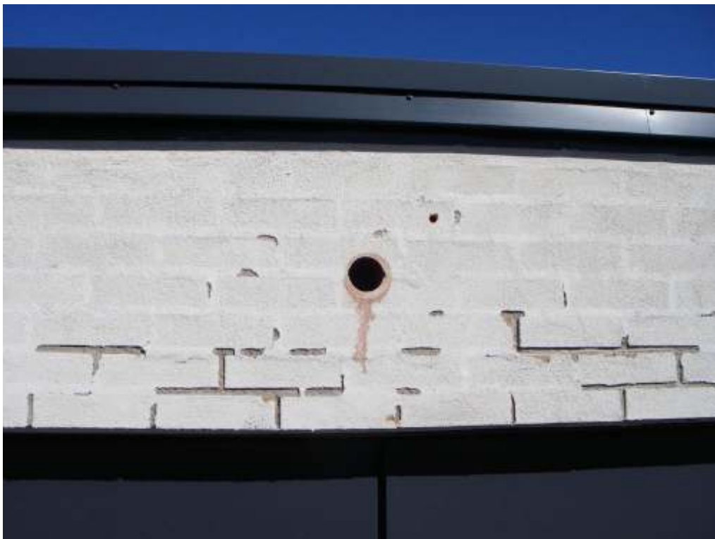
Kuva 4. Rapautunut näytekohta T6, linja M
