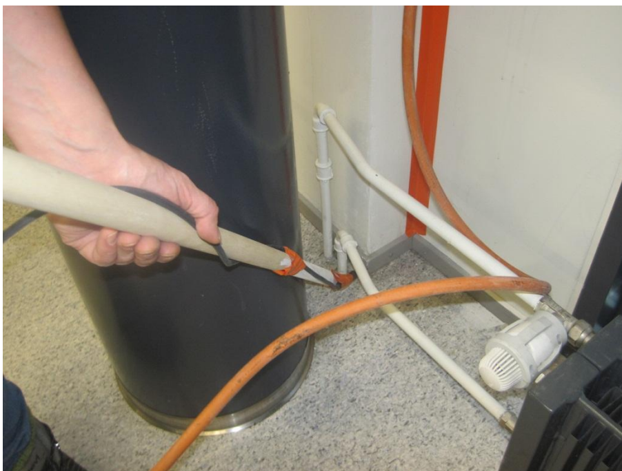
Kuva 11. Lattia/seinäliittymän vuotokohta
