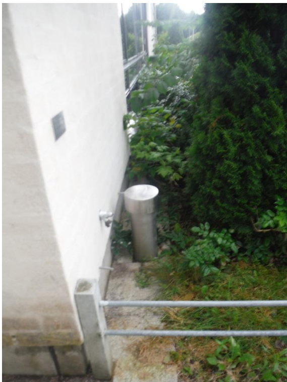
Kuva 4. Alapohjan tuuletusputki
