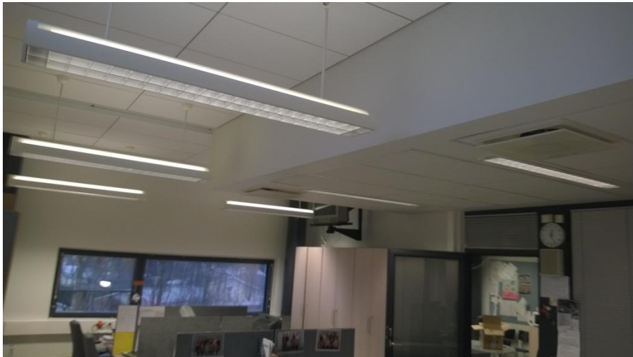
Kuva 20. Tilan b3.047 tuloilman päätelaitteiden sijoitus lähellä työpisteitä
