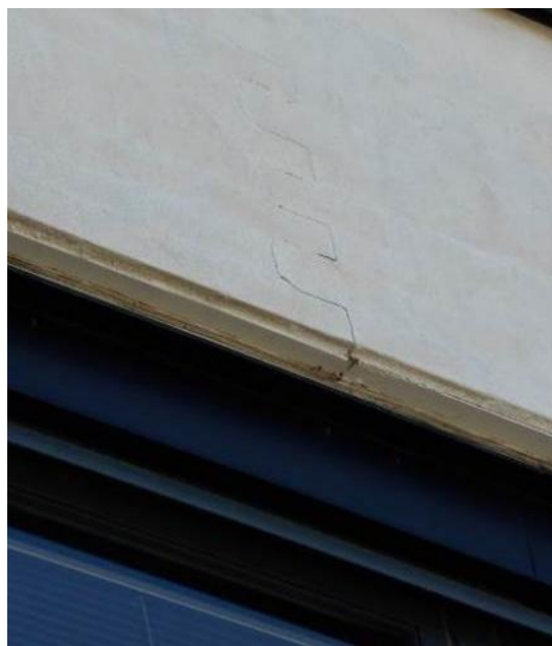
Kuva 11. Julkisivu O käsittää kaikki itäkoillisen suuntaan olevat julkisivut. Pääosin rapautumista ei esiinny, mutta yksittäisiä vaurioita esiintyy ja paikoin on havaittavissa alkavaa rapautumista tiilisaumoissa.
