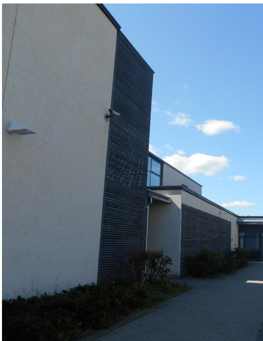
Kuva 11. Julkisivu O käsittää kaikki itäkoillisen suuntaan olevat julkisivut. Pääosin rapautumista ei esiinny, mutta yksittäisiä vaurioita esiintyy ja paikoin on havaittavissa alkavaa rapautumista tiilisaumoissa.
