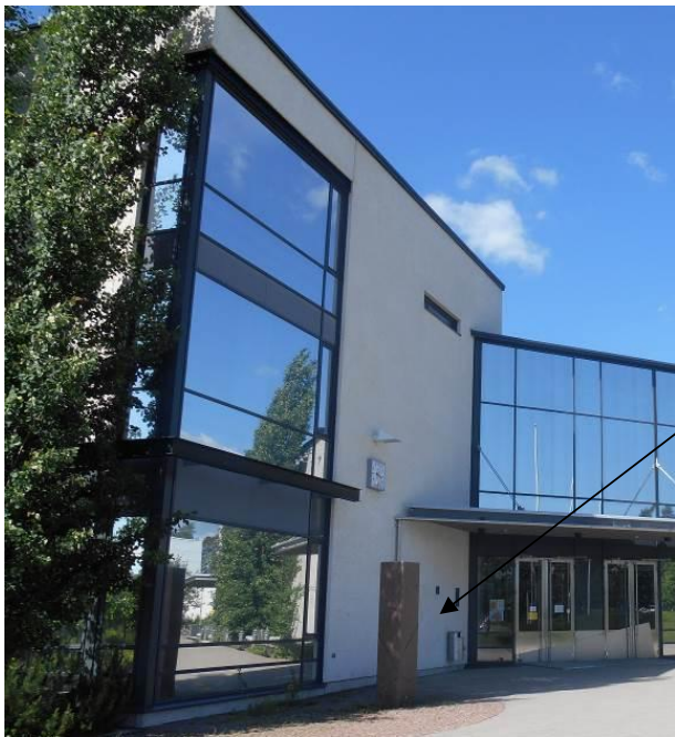
Kuva 1. Julkisivu A on pääoven viereinen lyhyt seinäosuus itäkaakon suuntaan. Tässä osassa ei ole rappausvaurioita, mutta pääoven vieressä on graffitien puhdistusjälkiä.
