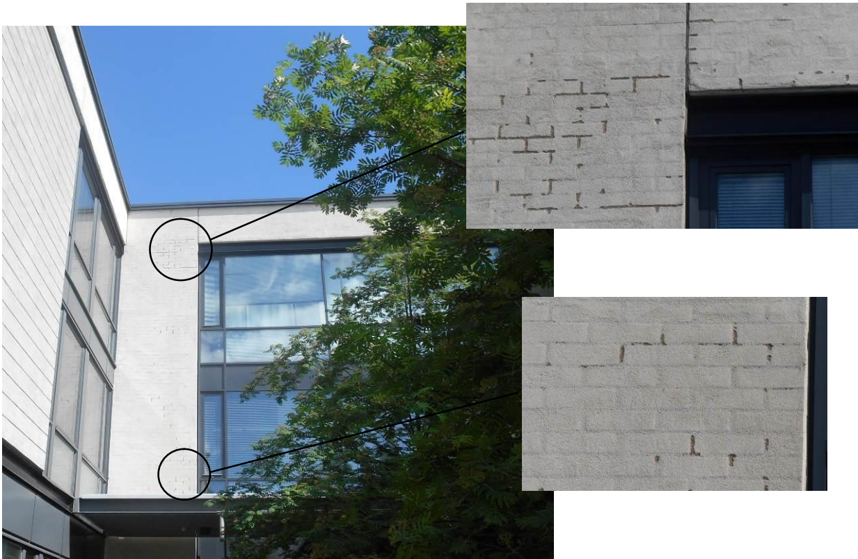
Kuva 5. Vaurioitunut osa julkisivusta C (länsiluoteen suuntaan). Tiilisaumoissa esiintyy alkavaa rapautumista ja yksittäisiä rapautuneita saumoja.
