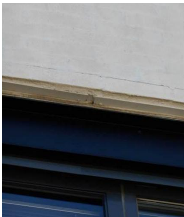
Kuva 11. Julkisivu O käsittää kaikki itäkoillisen suuntaan olevat julkisivut. Pääosin rapautumista ei esiinny, mutta yksittäisiä vaurioita esiintyy ja paikoin on havaittavissa alkavaa rapautumista tiilisaumoissa.
