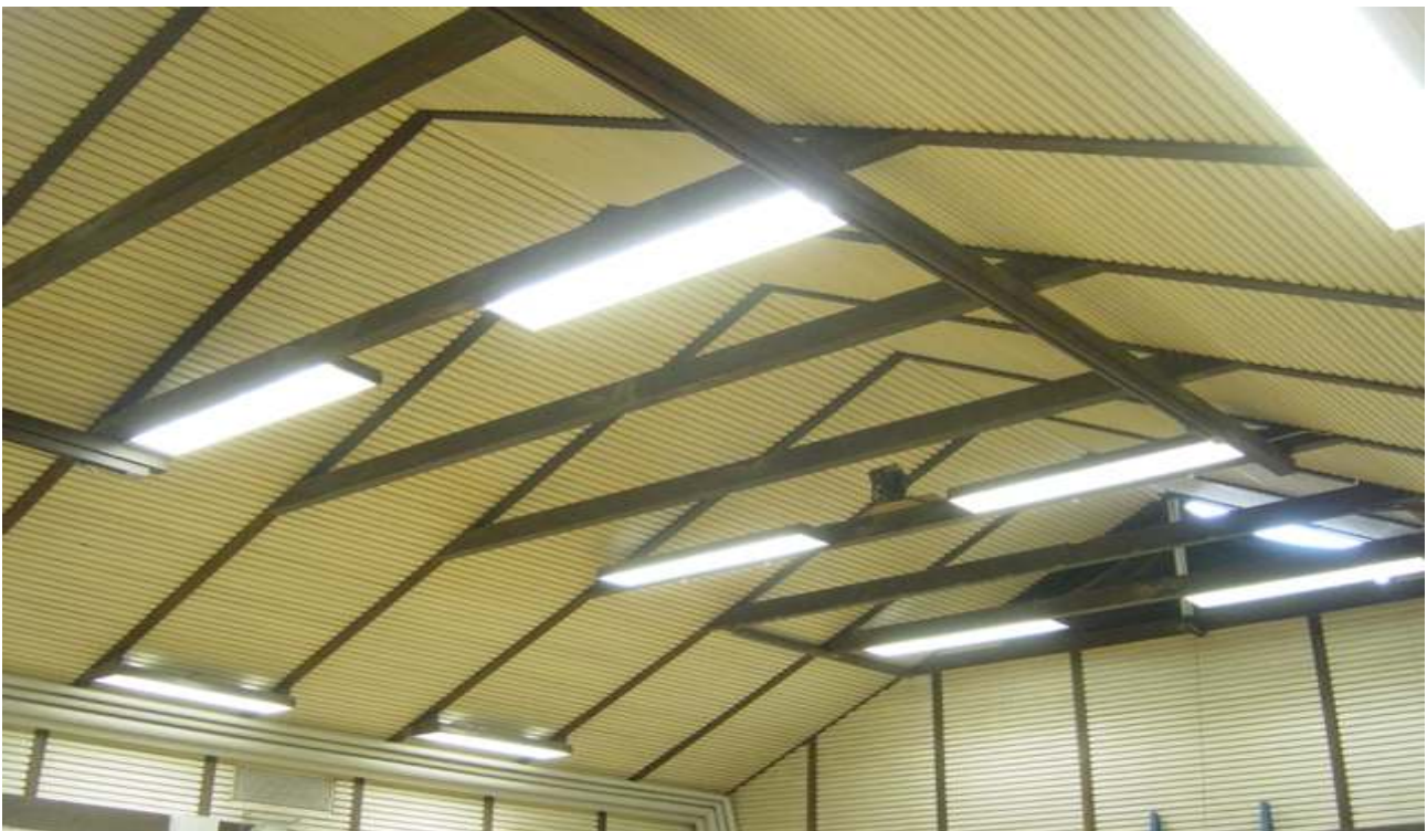
RAK-kuva 10. Päärakennuksen voimistelusalin yleiskuvaa katto- ja seinärakenteesta.
