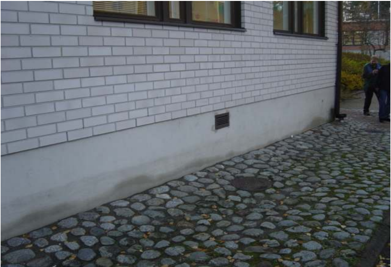
RAK-kuva 11. Yleiskuvaa lisärakennuksen sokkeli- ja julkisivurakenteesta.
