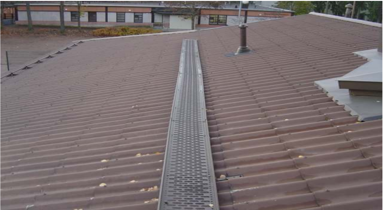
RAK-kuva 13. Yleiskuvaa lisärakennuksen vesikatosta.
