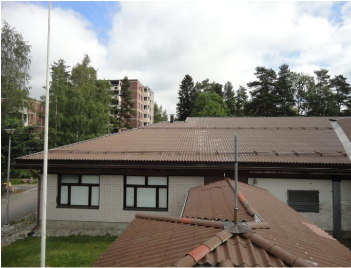
Vesikatto luokkahuoneen 135 yläpuolelta
