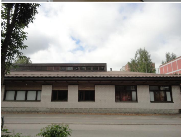
Vesikatto luokkahuoneen 102 yläpuolelta
