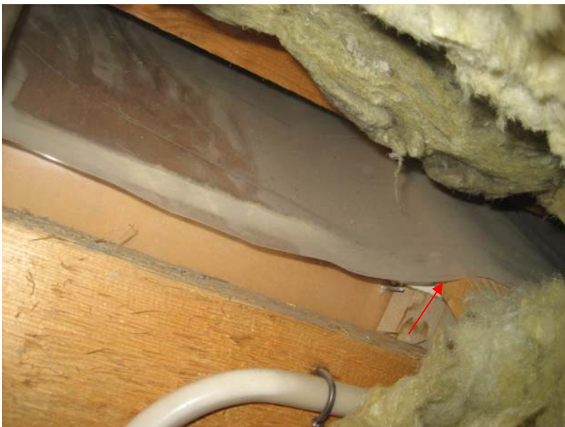
Kuva 39. Rakenneavauskohta AV.09–143. Yläpohjarakenteen vinokatto-osuuden muovi loppuu ulkoseinärakenteen päällä eikä yhdy ulkoseinärakenteen muoviin. Koolauslaudan vierellä ilmavuotokohta on mi-
