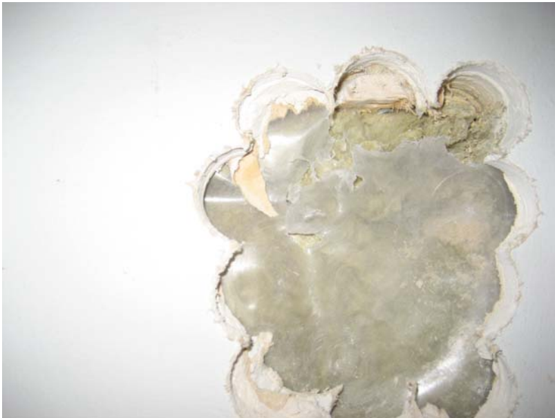
Kuva 1. Rakenneavauskohta AV.01–108. Avaus suoritettiin huonetilassa 108 ikkunan yläpuoliseen kipsilevytykselliseen ulkoseinään liimapuupalkin alla.
