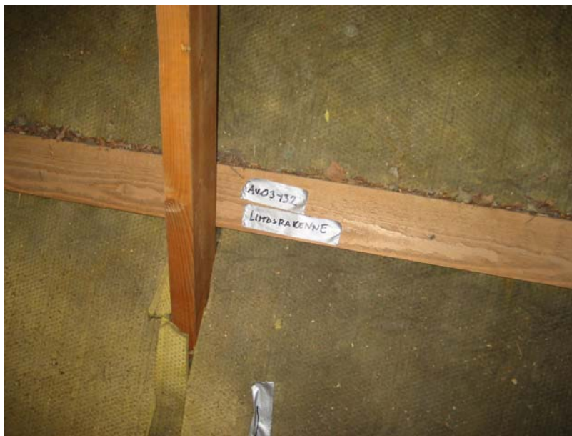
Kuva 9. Rakenneavauskohta AV.03-132 yläpohjan ontelotilasta käsin kuvattuna. Kuvassa näkyy yläpohjarakenteen vinokatto-osuuden lävistävä kattotuolin diagonaali sekä tuulensuojavillaa painava (kiinnittävä) 22x100-lauta.
