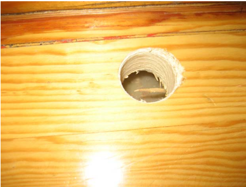
Kuva 44. Rakenneavauskohta AV.11–143 (Ø35-porareikä lattialaudoituksen läpi). Porareistä ei tehty mitään sellaisia havaintoja, jotka viittaisivat puutteisiin tai virheisiin (tosin Ø35-porareikä on melko pieni havaintoja tehtäväksi).
