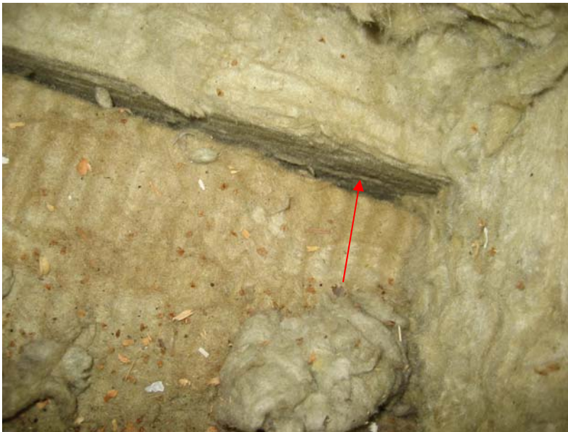
Kuva 31. Rakenneavauskohta AV.08–135. Eristelevyjen välinen sauma ei ole puskuksa vaan sauma on auki useita millimetrejä, paikoin jopa lähelle senttimetrin (punainen nuoli).
