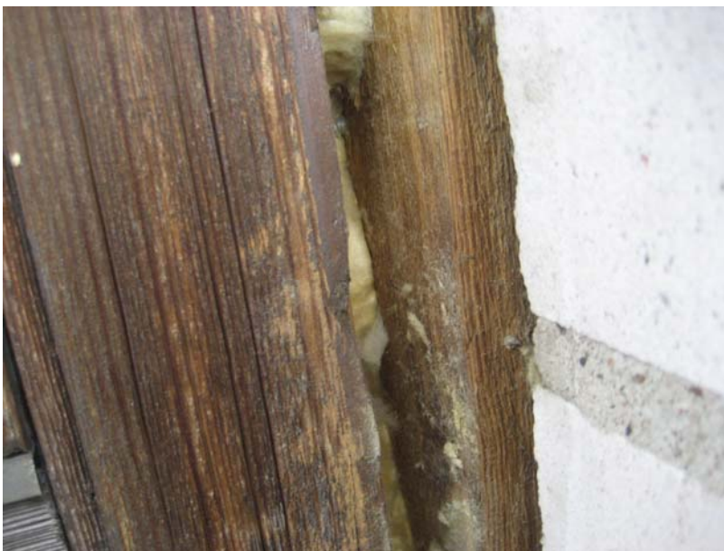
Kuva 28. Rakenneavauskohta AV.07-134 ulkotilasta käsin kuvattuna (sivukarmisauma). Karmisauma on todennäköisesti alun alkaen eristetty mineraalivillalla ja polyuretaanivaahdotus on asennettu jälkikäteen huonetiloista käsin. Ulkoseinän ulkokuorimuurauksen ja apukarmin välissä on rako.
