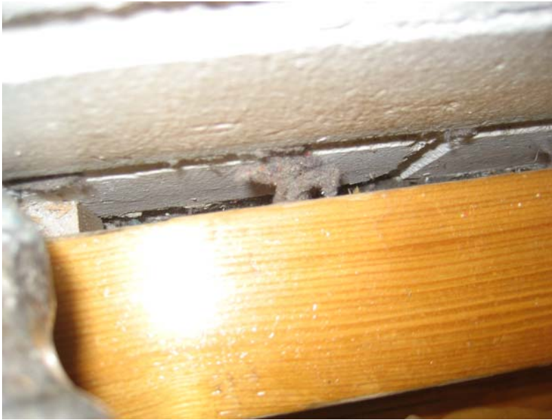
Kuva 45. Rakenneavauskohta AV.11–143 (jalkalistan longotus seinäpinnasta). Lattialaudoituksen ja sisäkuorimuurauksen välisestä raosta ei tehty mitään sellaisia havaintoja, jotka viittaisivat alapohjarakenteen liittyviin tiiveys- tai eristysongelmiin.
