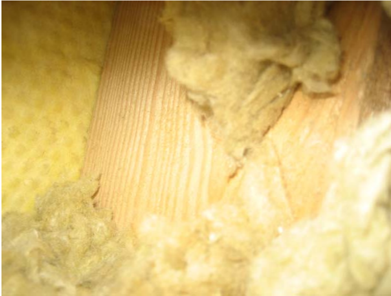
Kuva 3. Rakenneavauskohta AV.01–108. Rakenteessa eristeet ja puuaines olivat hyväkuntoisia ja mineraalivillalevyjen reunat kiinni koolausrungossa, tosin avaus oli niin pienikokoinen, etteivät eristesaumamat tai liitos tiiliväliseinäin olleet juurikaan näkyvissä.
