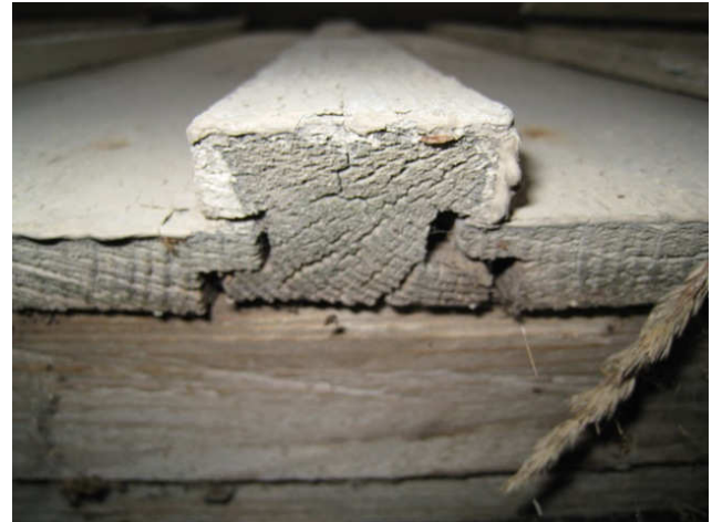
Kuva 34 Työnjohtajan asunnon ulkoverhouksessa on käytetty saumoissa H-profiilia ja laudoissa on puolipontti. Kuva alareunasta
