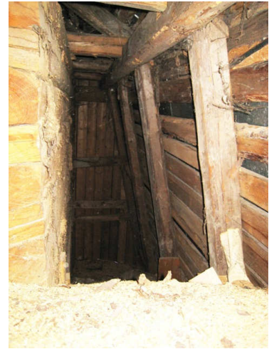
Kuva 38 Työnjohtajan asunnon sivuontelo portaiden yläpuolella mansarditaitteen alla.
