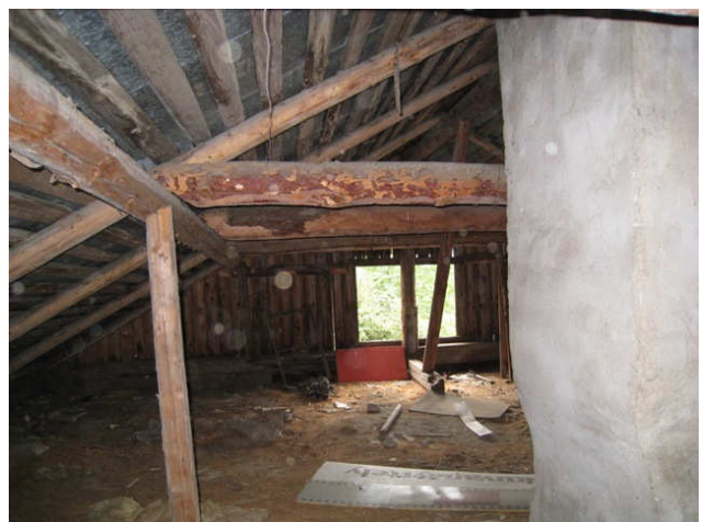
Kuva 18 Yleiskuva työväen asuinrakennuksen ullakolle ja vesikattorakenteista.
