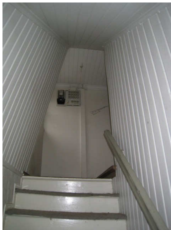
Kuva 51 Työnjohtajan asunnon yläkertaan johtava porras on yläosalta kapea.
