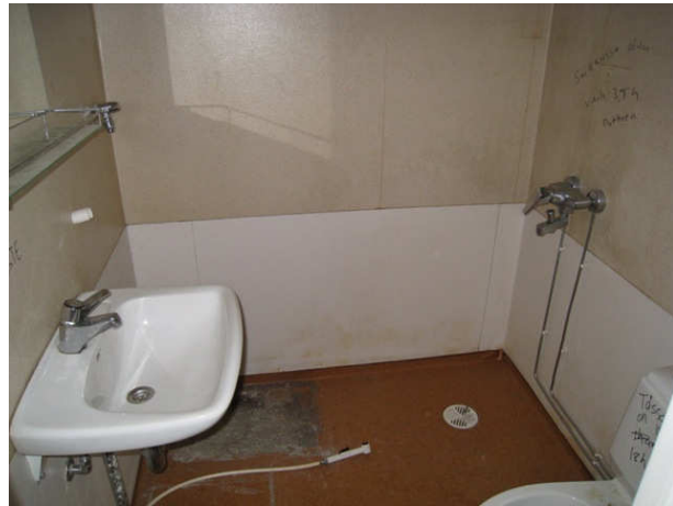
Kuva 52 Työnjohtajan asunnon yläkerran wc-suihku-tila, materiaalit ovat vanhoja.
