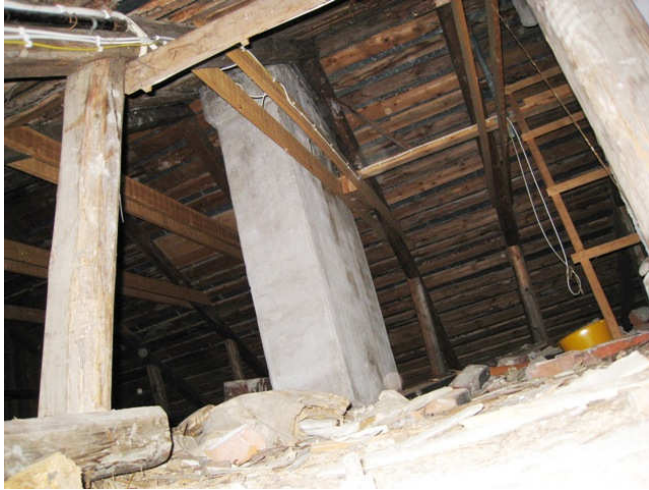
Kuva 37 Yleiskuva työnjohtajan asunnon ullakolta ja vesikattorakenteista.
