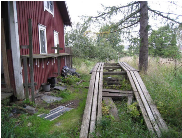
Kuva 57 Työväen asunnon päädyssä oleva autonkorjauspaikka ja epämääräisiä nesteitä seinävieren ämpäreissä.
