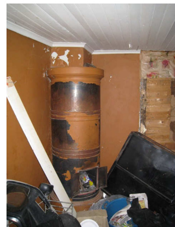
Kuva 24 Työväen asuinrakennuksen yhdessä huoneessa on vanha pystyuuni.
