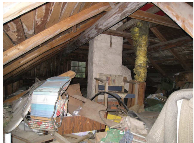
Kuva 6 Yleiskuva saunarakennuksen ullakolta ja vesikattorakenteista.
