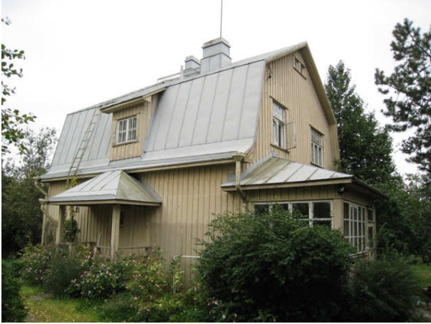
Kuva 25 Yleiskuva työnjohtajan asunnosta.
