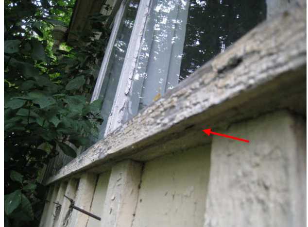
Kuva 32 Ikkuna-aukkojen ala- ja yläreunassa on suoja laudat, joissa on tippaurat.
