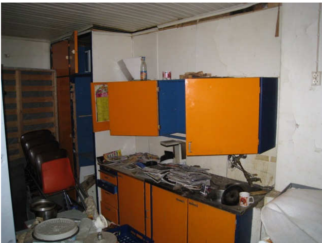
Kuva 21 Työväen asuinrakennuksen keittiöt ovat vanhoja.
