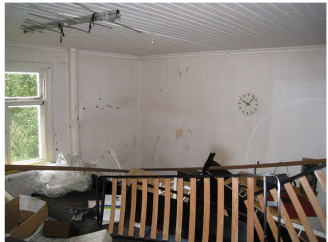
Kuva 22 Työväen asuinrakennuksen tyyppinen huonetila.
