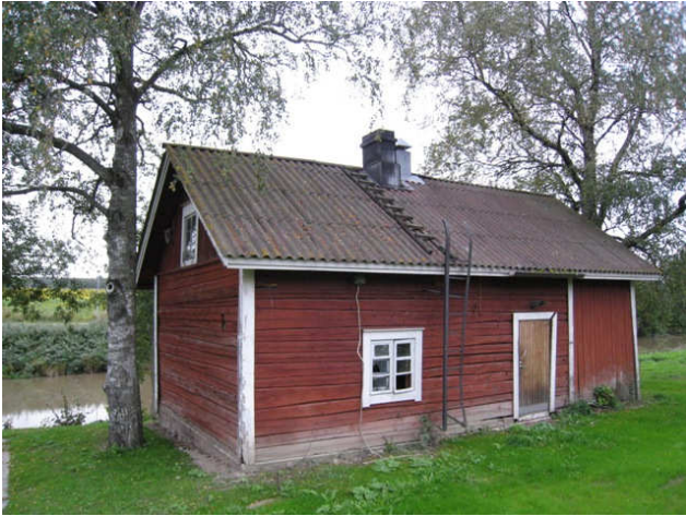
Kuva 1 Yleiskuva saunarakennuksesta. Maasto viettää kohti rakennusta
