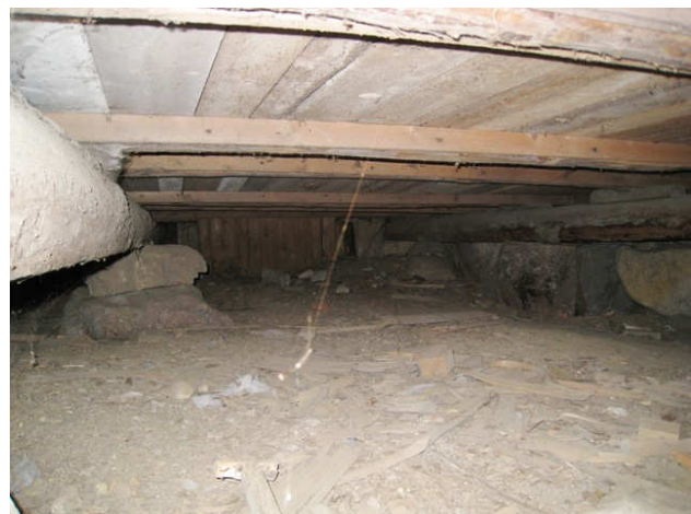
Kuva 42 Työnjohtajan asunnon alustatila, jossa alapohjaa ja piippua kannattelevat tiililatomukset.
