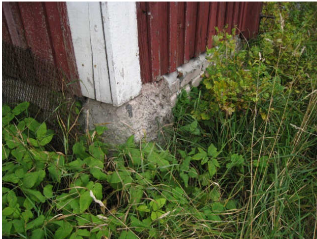
Kuva 15 Työväen asuinrakennuksen perustuksina on mm. kiviä ja välissä on muuraamattomia tiililatomuksia.
