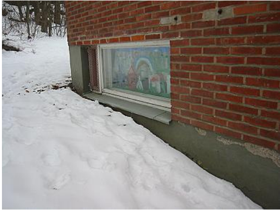
Kuva 3 Julkisivu länteen. Ikkunarakenne lähellä maanpintaa.
