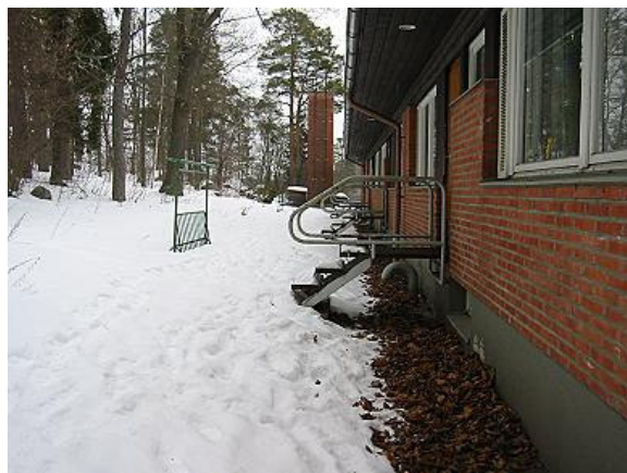
Kuva 5 Maanpinta viettää rakennukseen päin. Leveät räystäät suojaavat ulkoseinä-rakenteita pitkillä sivuilla.
