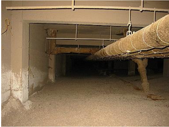
Kuva 9 2-kerroksisen rakennusosan alapohjaa.
