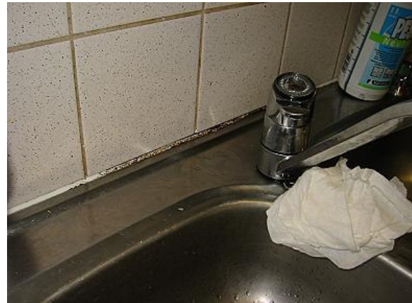
Kuva 14 Huoneistokeittiöiden silikonisaumaukset tummuneet.
