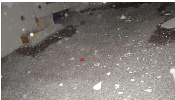
Kuva 19. Kuva alapohjan ryömintätilasta.
