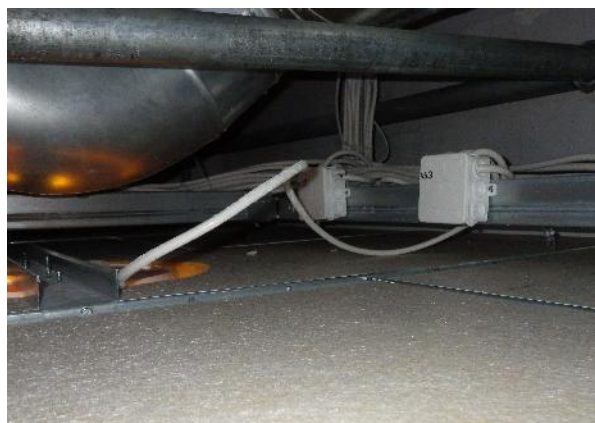
Kuva 16. Alakattolevytyksen pinnoilla ei ole havaittavissa merkittävää pölyisyyttä.
