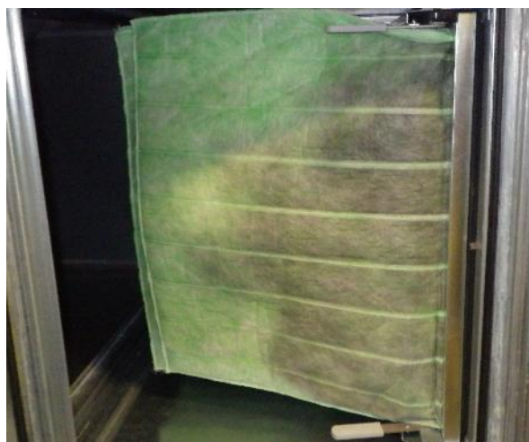
Kuva 8. Ilmanvaihtokoneen poistoilmasuodatin.
