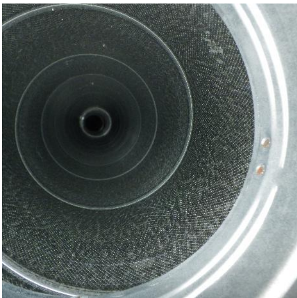
Kuva 1. Huoneen 057 tuloilmakanava. Kanavassa ei ole merkittävää pölykertymää.
