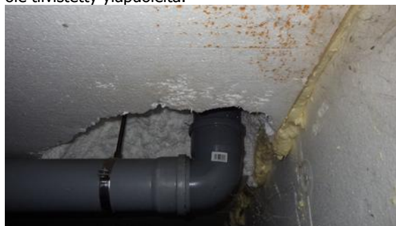
Kuva 20. Ryömintätilassa näkyvä alapohjan viemäriputken läpivienti. Läpiviennin tiiveyttä ei tarkastettu (alapohjan tarkastusluukku ei saatu avattua).
