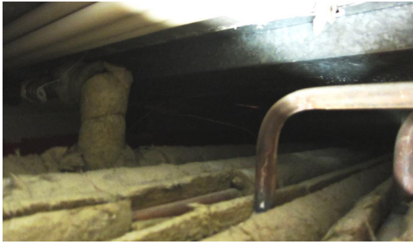
Kuva 13. Näkymä käytävän alaslasketun katon yläpuolelle.
