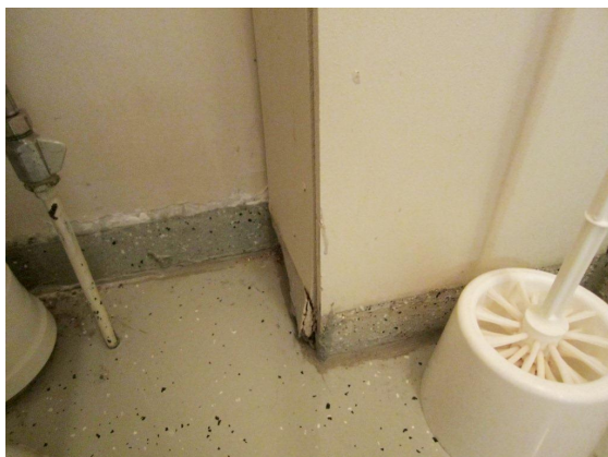
Kuva 6. Lasten WC:n lattialla on massapinnoite. Liittymäkohdat ulkoseinälle, väliseinille ja koteloon on tiivistetty elastisella kittauksella.
