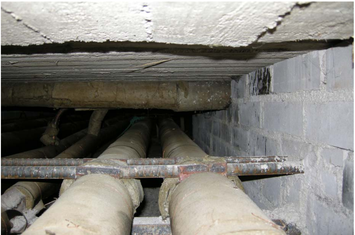
Kuva putkikanaalin putkista ja rakenteista.
