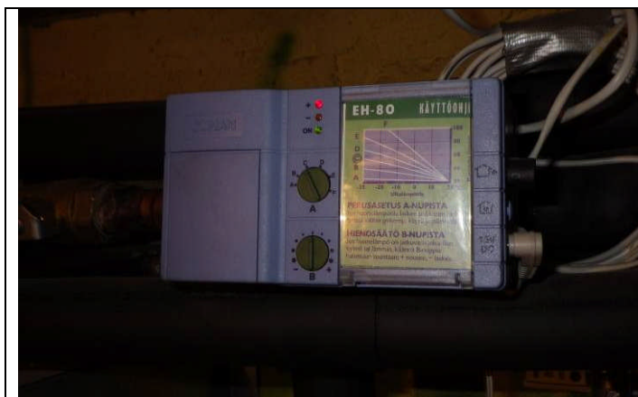
31. Lämmityksen yksikkösäädin.
