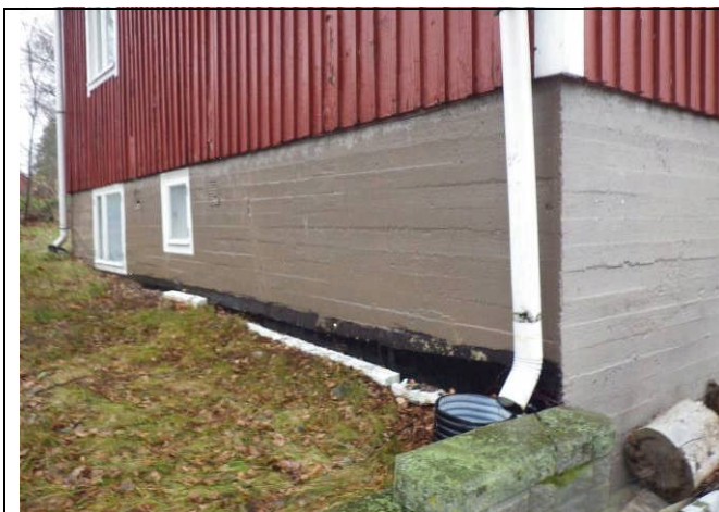
3. Perusmuuria vasten on lisätty vedeneristyslevyt ja lämmöneristyslevyjä.
