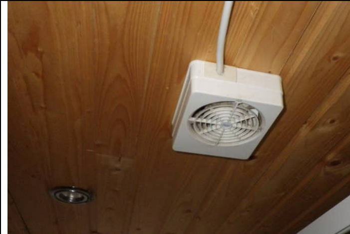
33. Poistopuhallin suihkutilan katossa.
