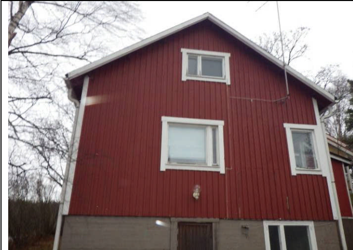
9. Rakennuksen julkisivua päädystä.
