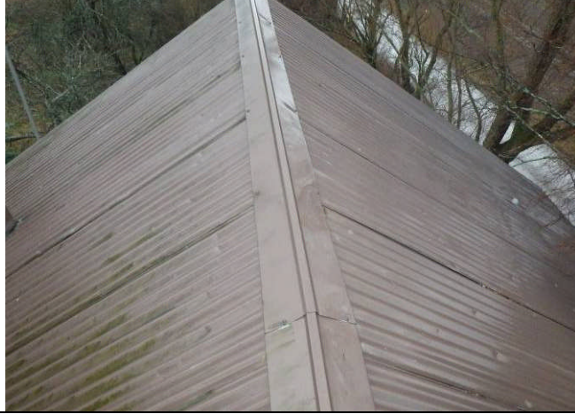
15. Katteen harjaa. Tiiveys tulee tarkastaa yläpohjajättilän tarkastuksen yhteydessä.
