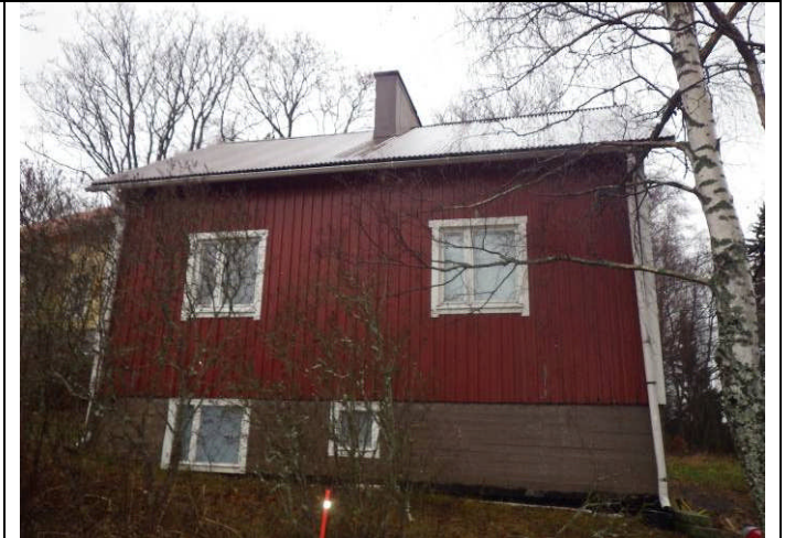
10. Tien puoleinen julkisivu.
