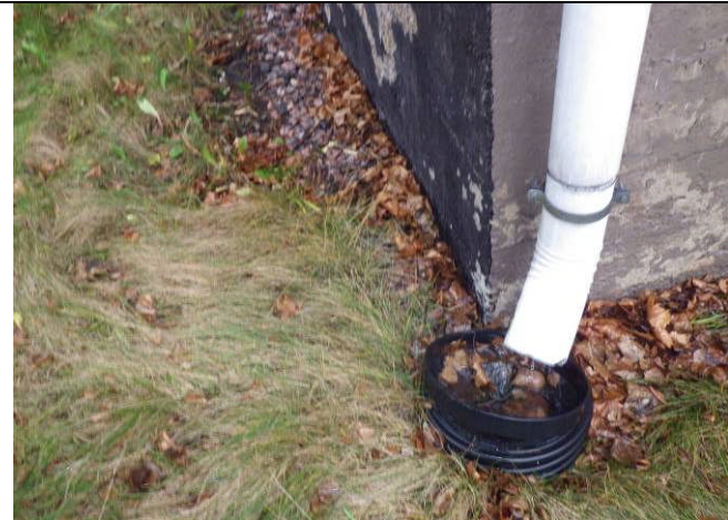
5. Sadevedet ohjautuvat salaojajärjestelmään.
