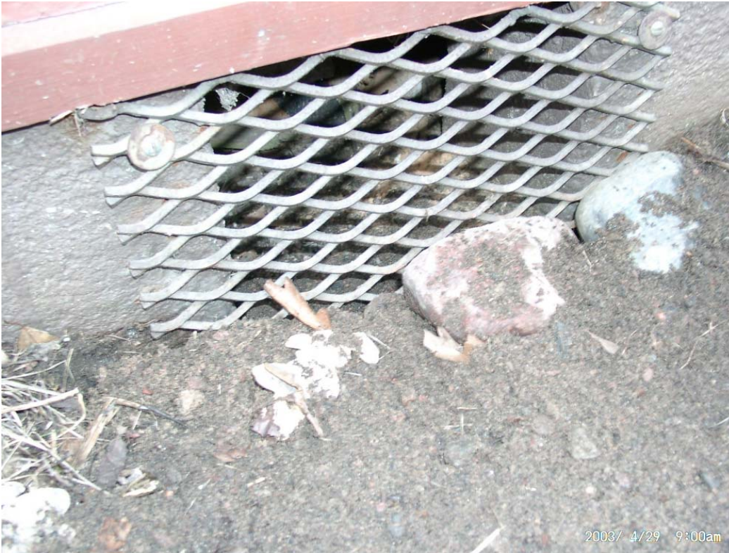
Kuva 5. Tuuletusaukoissa maanpinta oli 0...50 mm alempana kuin sokkelin ulkopuolella. Tuuletusaukkojen alareunan tulisi olla >150 mm korkeudella maanpinnasta.
