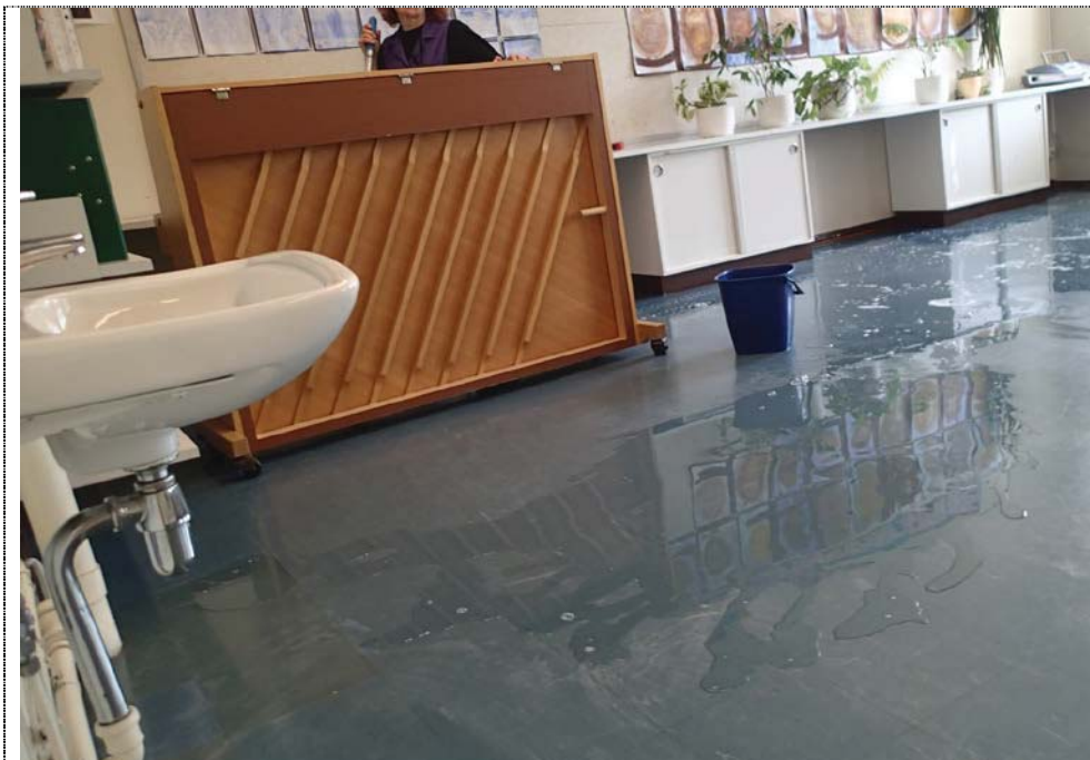
Kuva 20: Peruspesut, vettä kaadetaan yhä reilusti suoraan ämpäristä lattialle.
