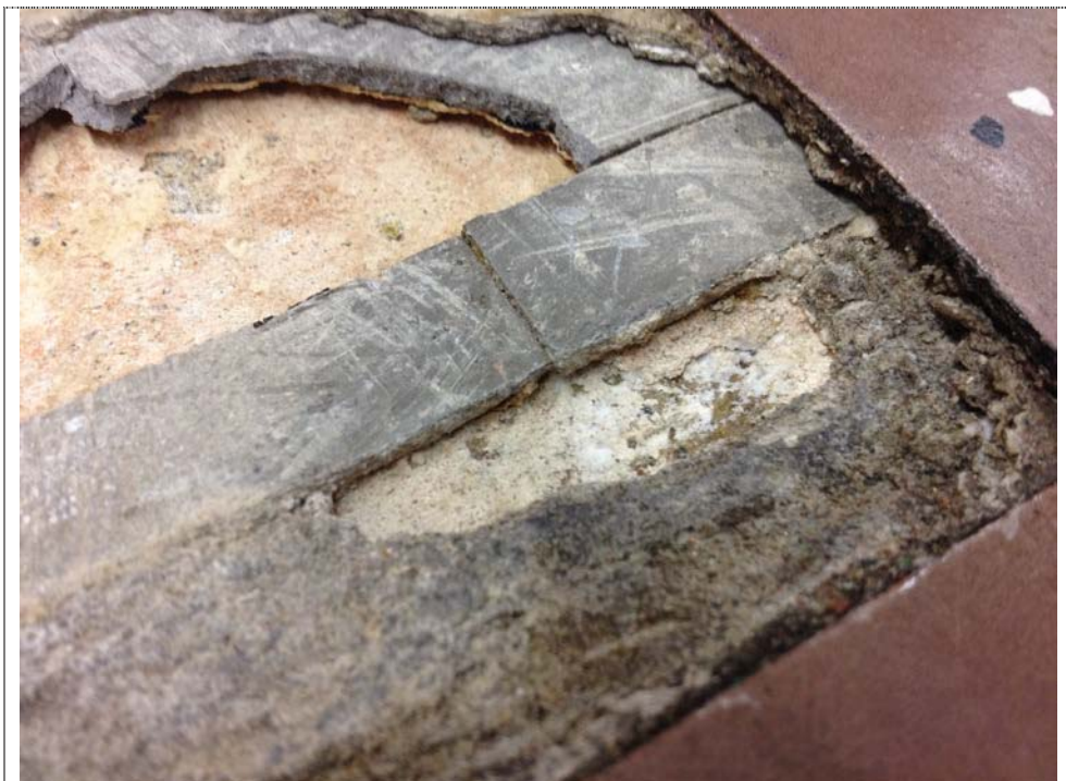
Kuva 28: Luokka 149, vinyylilaatat on asennettu vanhan vinyylilaatan päälle
