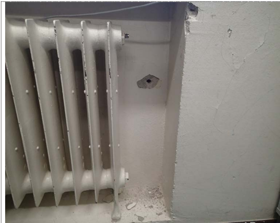
Kuva 1: Ulkoseinän patterisyvennys, rakenneavaus.
