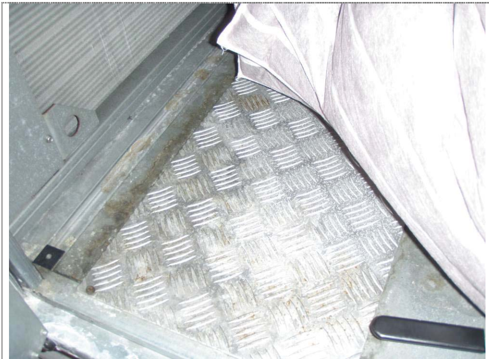
Kuva 33: Tuloilmakoneen TK01 suodatinosassa kosteusjälkiä..
