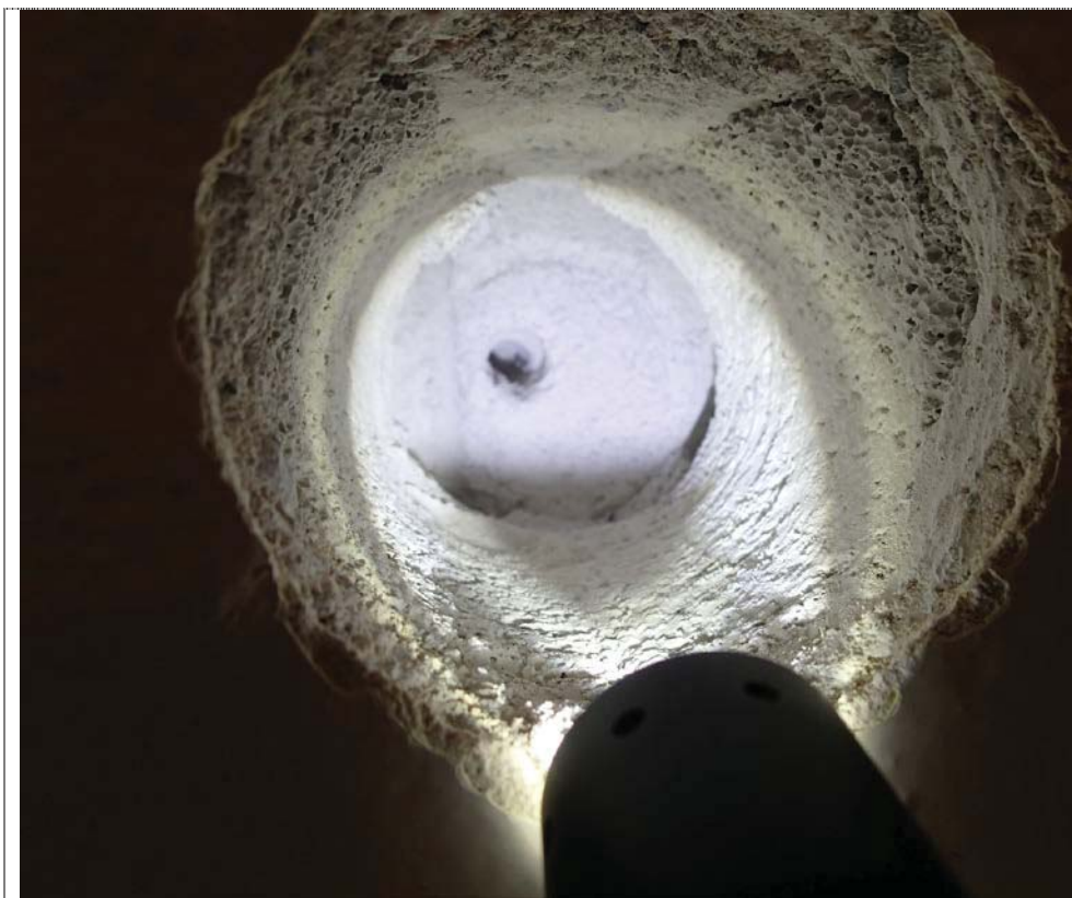
Kuva 2: Patterisyvennyksen kevytbetonirakenne.
