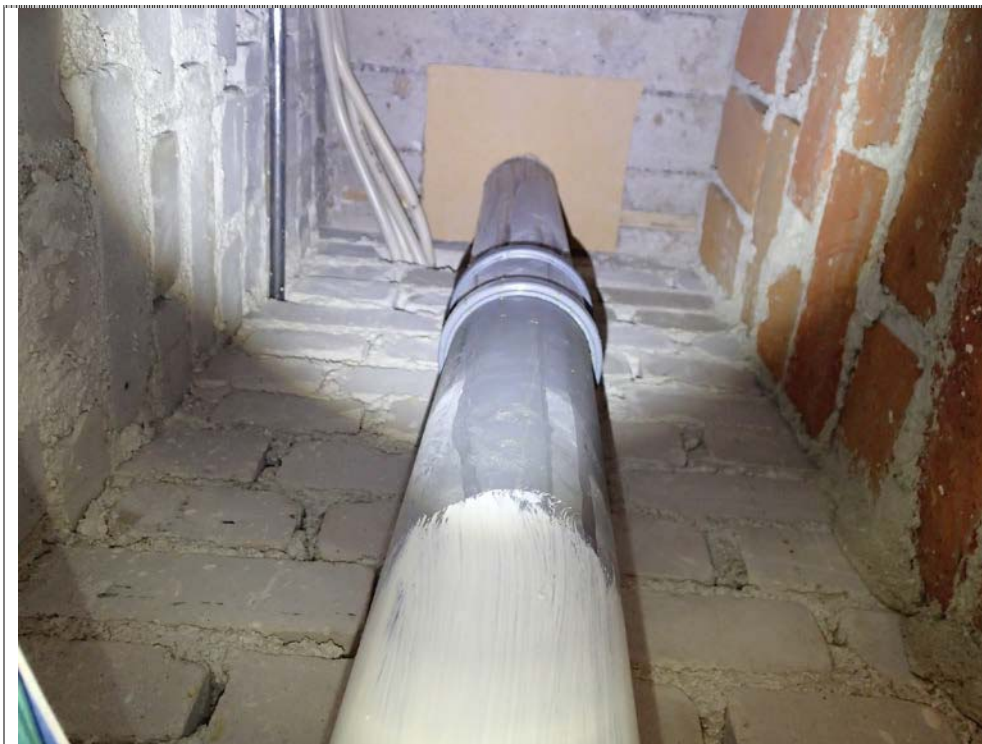
Kuva 10: Luokan 322 komeron yläpuolinen tila, tuuletusviemäri.
