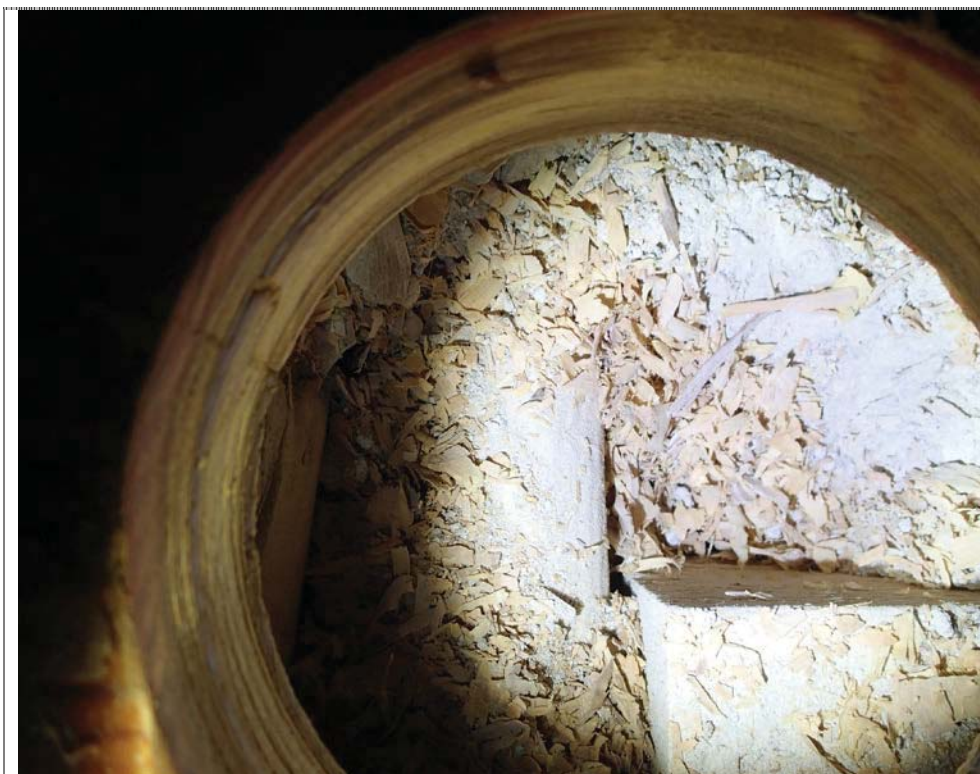
Kuva 18: Välipohjan rakenneavaus IP-kerhon tilassa.
