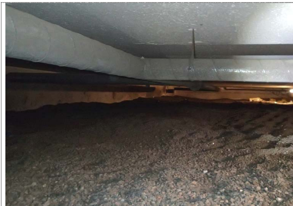
Kuva 30: Uuden puolen ryömintäosa, siisti ja kuiva.
