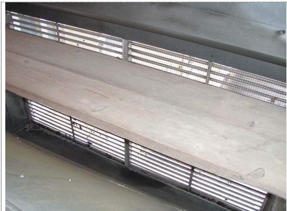
Kuva 32: Varsinainen RI-kammio on syvä ja kapea, jolloin ilmavirta ei pysty jakautumaan tasaisesti koko säleikön alalle.
