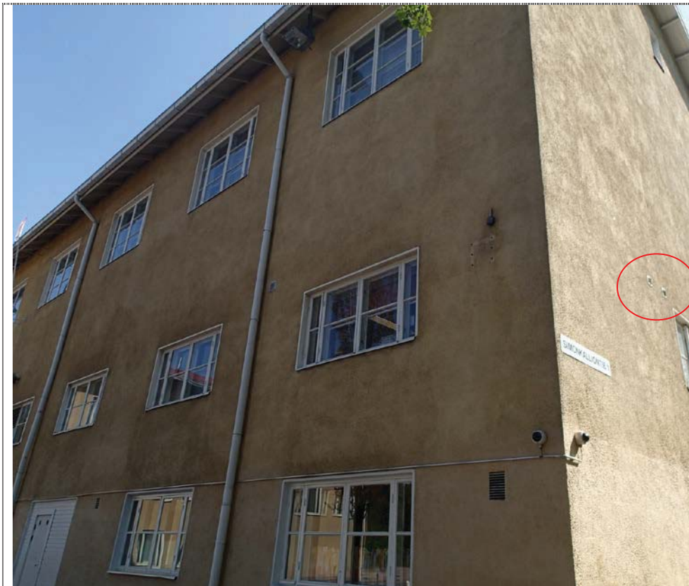
Kuva 43: Rikkinäisiin säleikköihin on linnut tehnyt pesiä.
