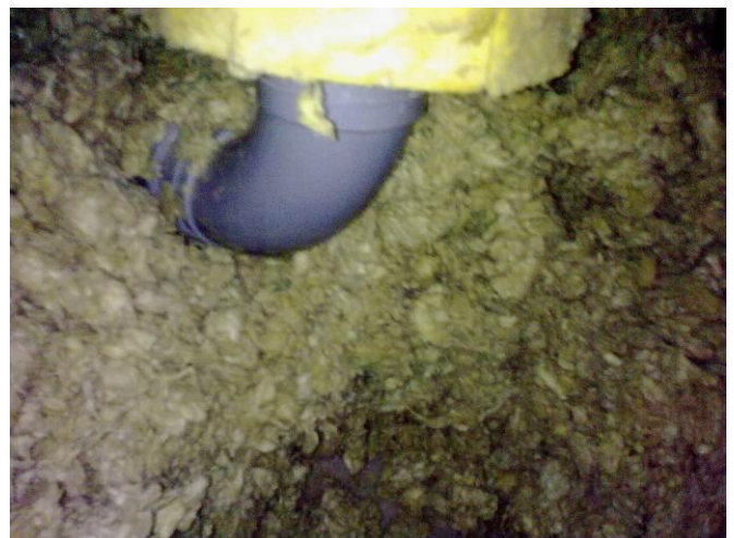
Kuva 4 Puutteellinen eristys
