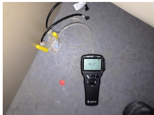
Kuva 2. Tilaan saatiin alipainetta -8 pascalia teippaamalla tuloilmaventtiili. Paine-ero mitattiin sisätilan ja betonilaa- tan väliltä kaasun syöttöreiästä.
