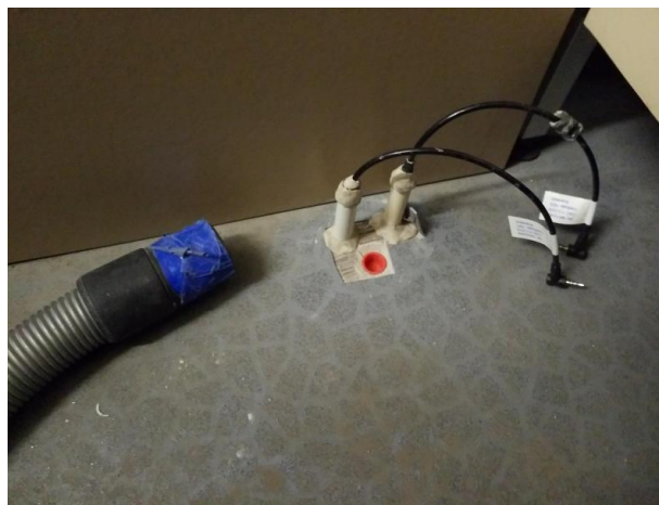
142 WC lattian kosteumittaus. Mittapiste 8
