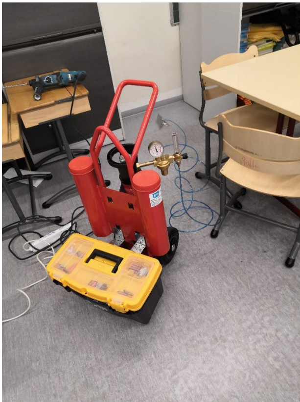
Kuva 6. Tilan 150 kaasun syöttökohta lattiaan.
