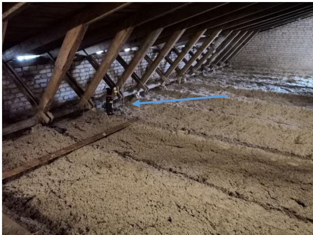
Kuva 26. Yleiskuva huoneen 231 päältä, kaasun syöttökohta on merkitty nuolella.
