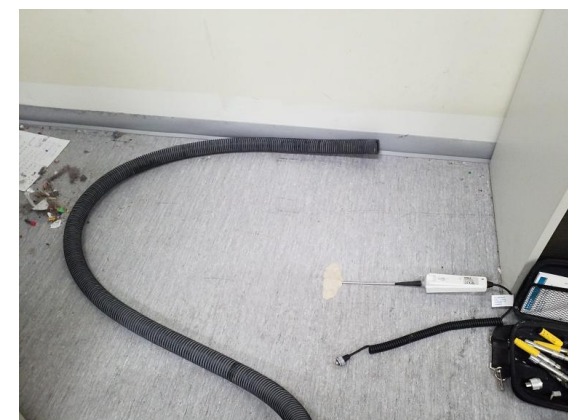
150 Opestustilan lattian kosteusmittaus. Mittapiste 6
