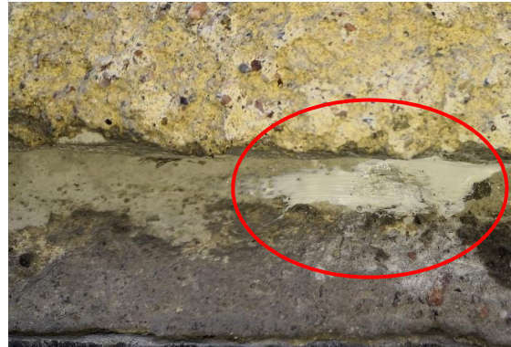
Kuva 13. Kaasun syöttöreikä korjattuna.
