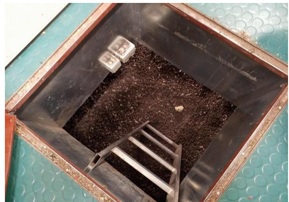
Tilassa kulku ryömintätilaan
