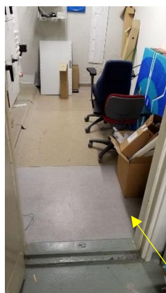
126 SPK Lattian mittaus. Mittapiste 5
