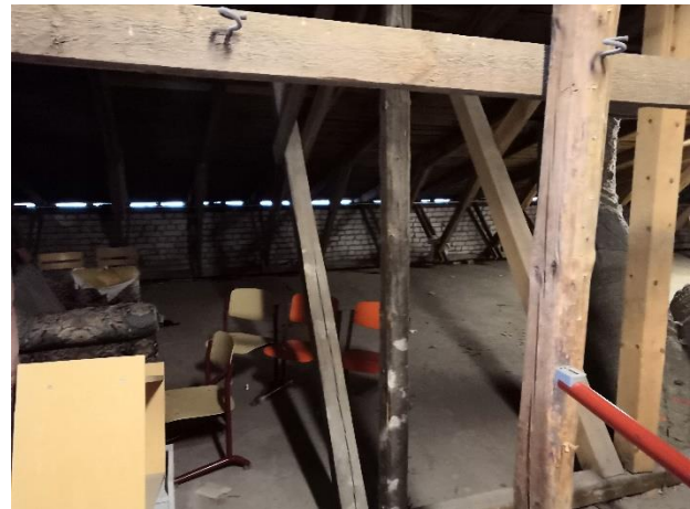
Kuva 27. Yleiskuva huoneen 324 yläpuolelta
