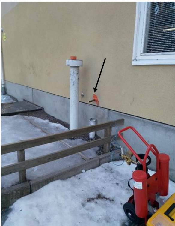
Kuva 18. Kaasun syöttö ulkoseinään.
