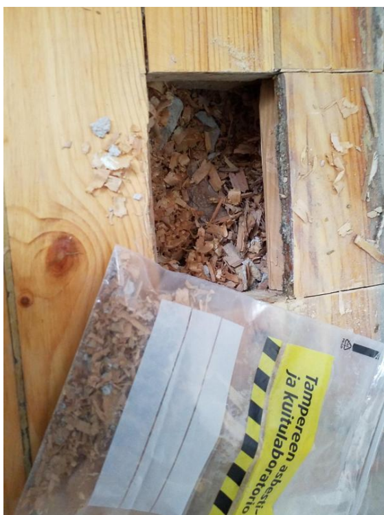
Kuva 10. Asunto A2. Näyte välipohjasta.
