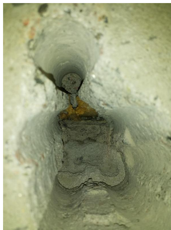
Kuva 11. Käytävä 200. Näyte uuden ja vanhan osan liitoskohdasta välipohjasta, jossa on jäljellä vanhaa ulkoseinää.
