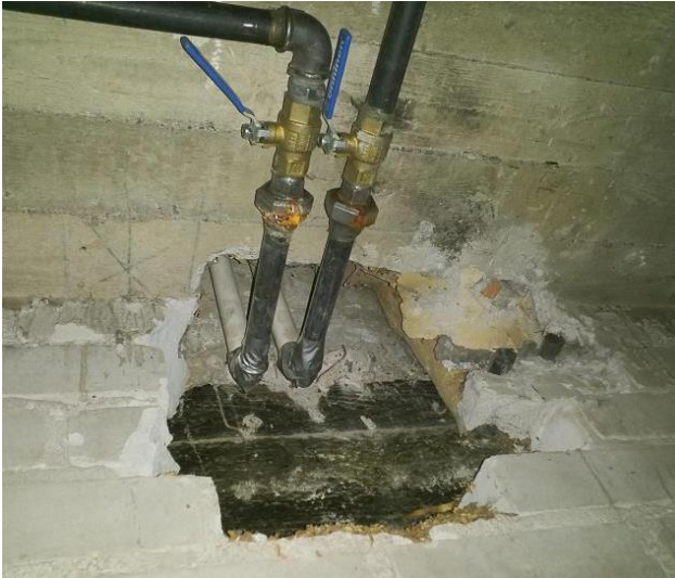
Kuva 24. Asuntolan käytävän lämpöputkien läpiviennit auki.
