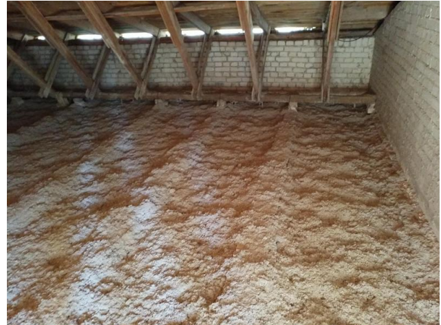
Kuva 3. Vanhan osan korjattua yläpohjaa. Puhallusvillan alta on nähtävissä alalaattapalkistot.
