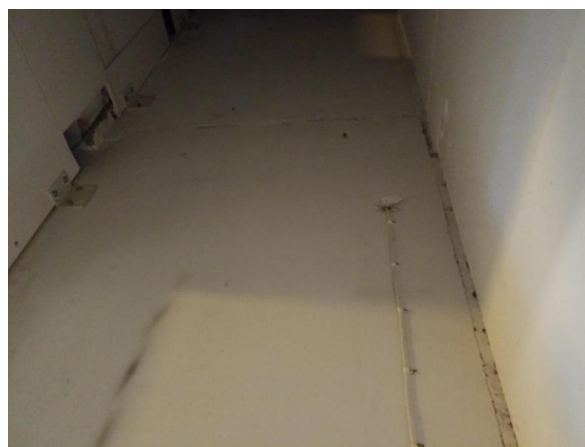
Kuva 28. Sähköputken läpivienti auki 1. krs alakaton tasalla.
