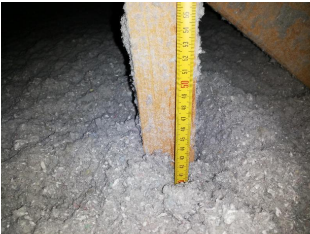
Kuva 30. Uuden osan yläpohjassa selluvillaa 400 mm
