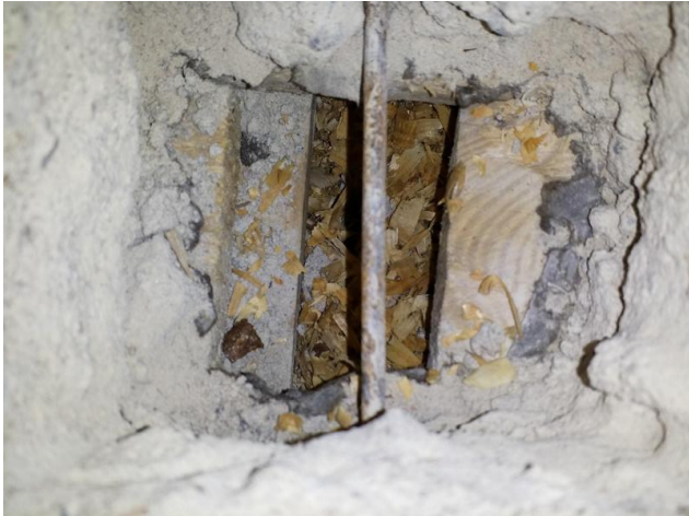
Kuva 2. Vanhan osan yläpohjarakennetta: betoni, piki-pahvi, laudoitus ja eristekerros.
