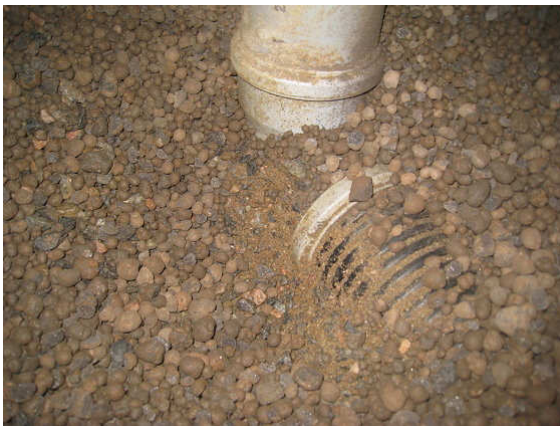
Kuva 21 TP nro. 2:n kohdalla salaojaputken tasolla kosteaa hiekaista sepeliä.
