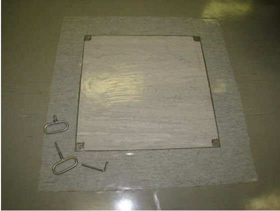
Kuva 1 Lattialuukku alustatilaan eteistilassa 2.
