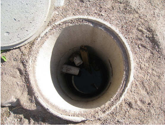
Kuva 25 Kaakon puoleisen seinälinjan keskikohdan tarkastuskaivo.
