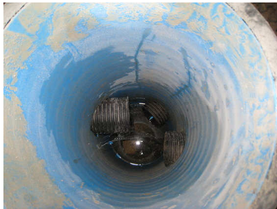
Kuva 22 Tarkastuskaivon pohjalla on kirkasta vettä.
