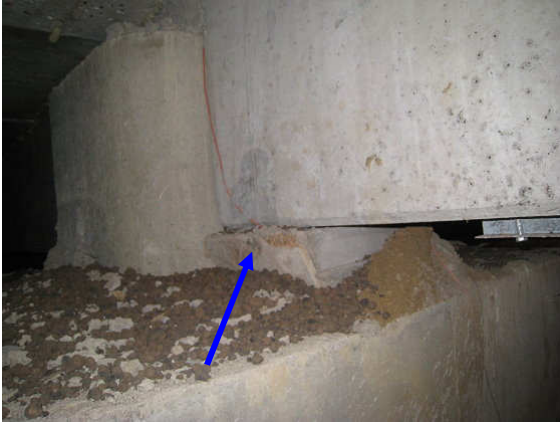
Kuva 13 Muottina käytettyä lastulevyä.
