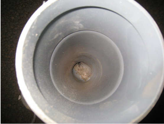
Kuva 19 Salaojaputken TP nro. 1.
