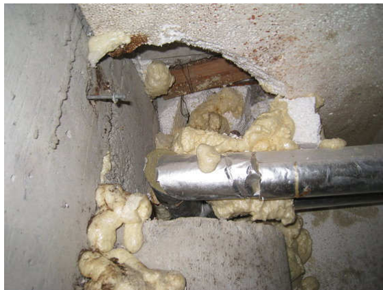
Kuva 17 Läpivienti, jossa näkyvillä lautta ja polystyreenilevyä.
