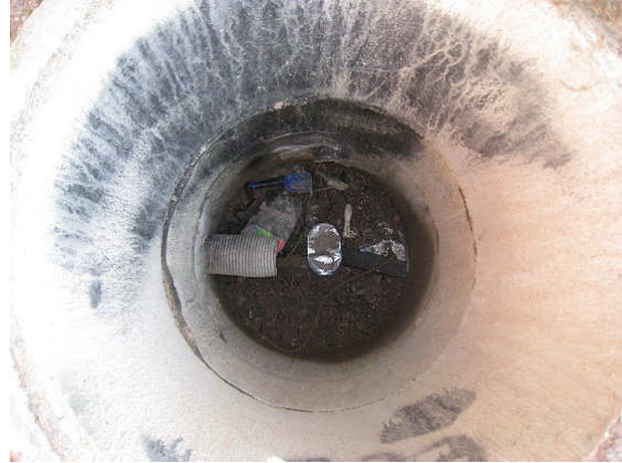
Kuva 26 Lähellä koilliskulmaa oleva tarkastuskaivo. Pohjalla ei ole vettä.
