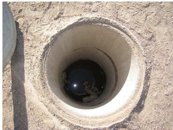
Kuva 24 Salaojien tarkastuskaivo pohjoiskulmassa.
