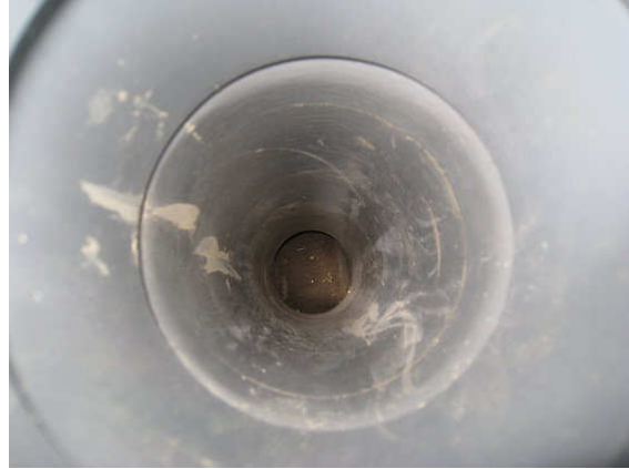
Kuva 20 Salaojaputken TP nro. 2.
