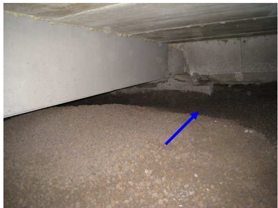
Kuva 6 Painanteissa kostea kevytsoraa.
