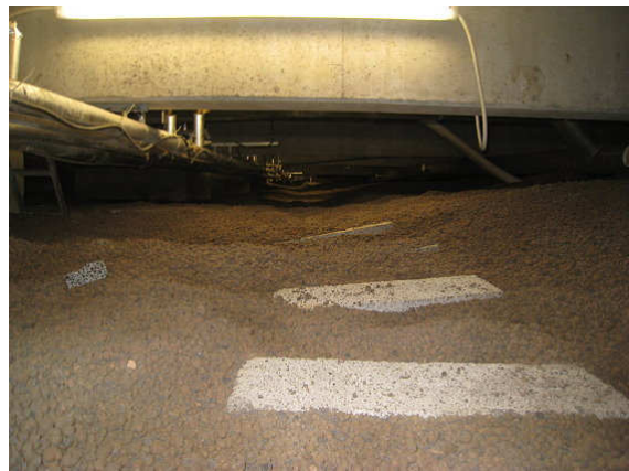
Kuva 4 Keskilinjalla kevytsoraharkot helpottamassa liikkumista.
