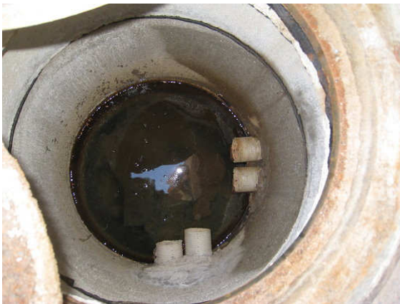
Kuva 23 Ulkopuolisten salaojien tarkastuskaivo lounaan puoleisessa kulmassa.
