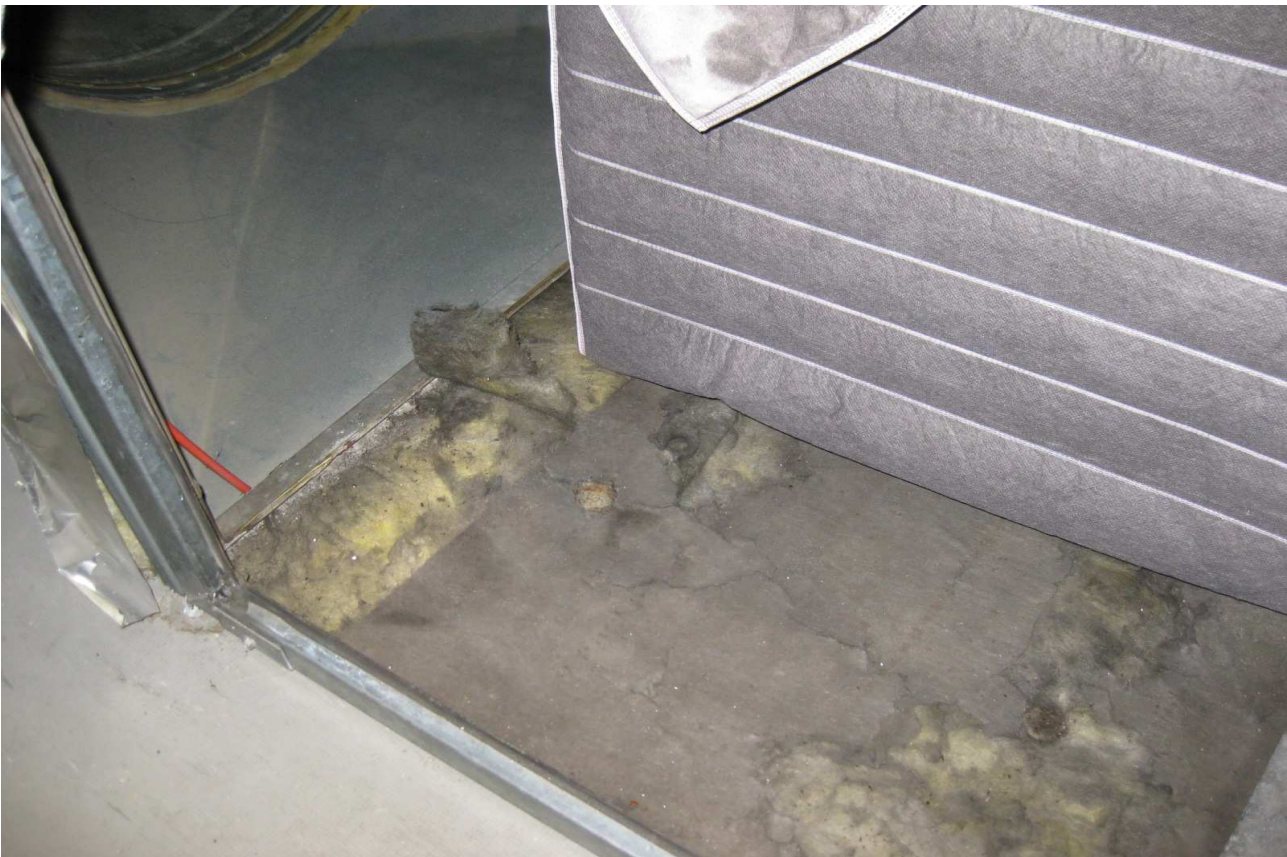
LVI-kuva 11. Yleiskuva tuloilmakoneen kammiosta, joka on eristetty mineraalivillalla.
