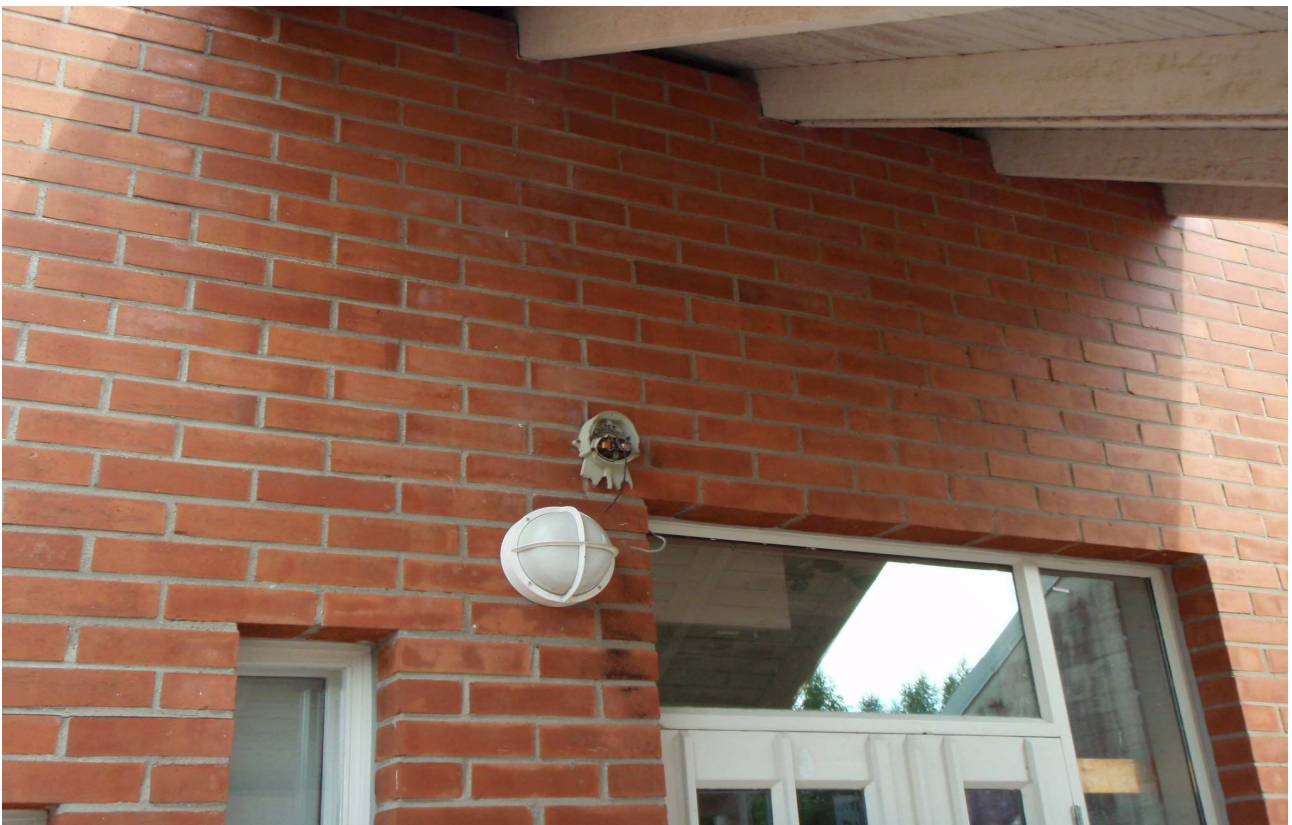
S-kuva 1. Sisäänkäynnin valaistus.
