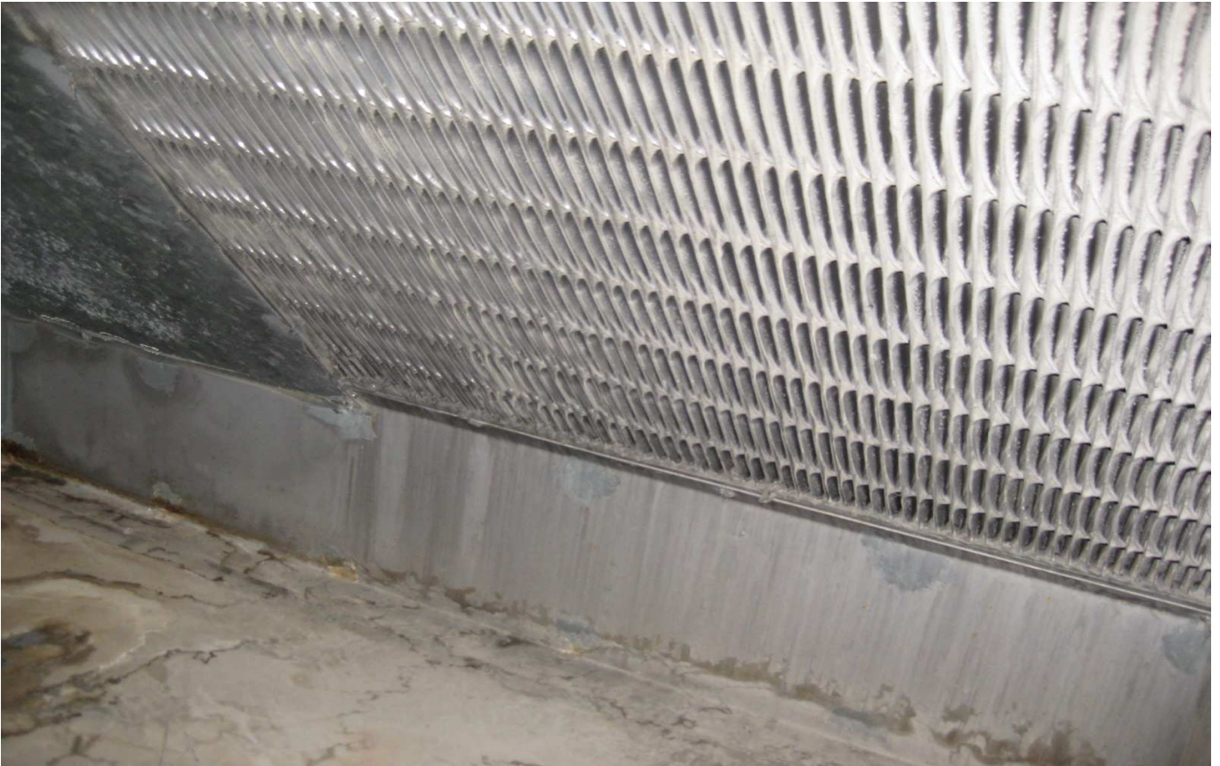
KUVA 3. Yleiskuva LTO- kuutiosta.
