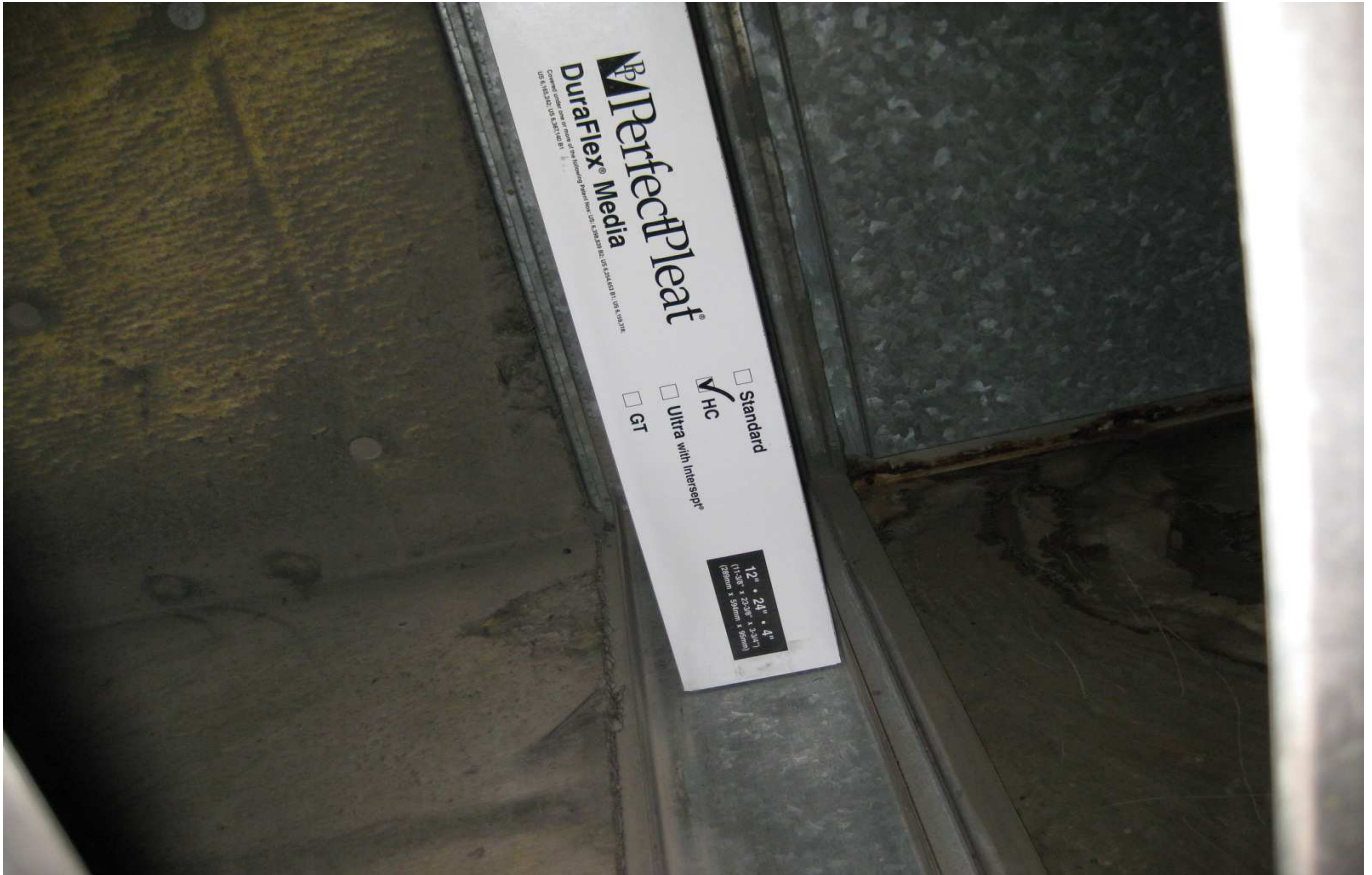
KUVA 7. Yleiskuva poistoilmasuodattimen kehyksestä.
