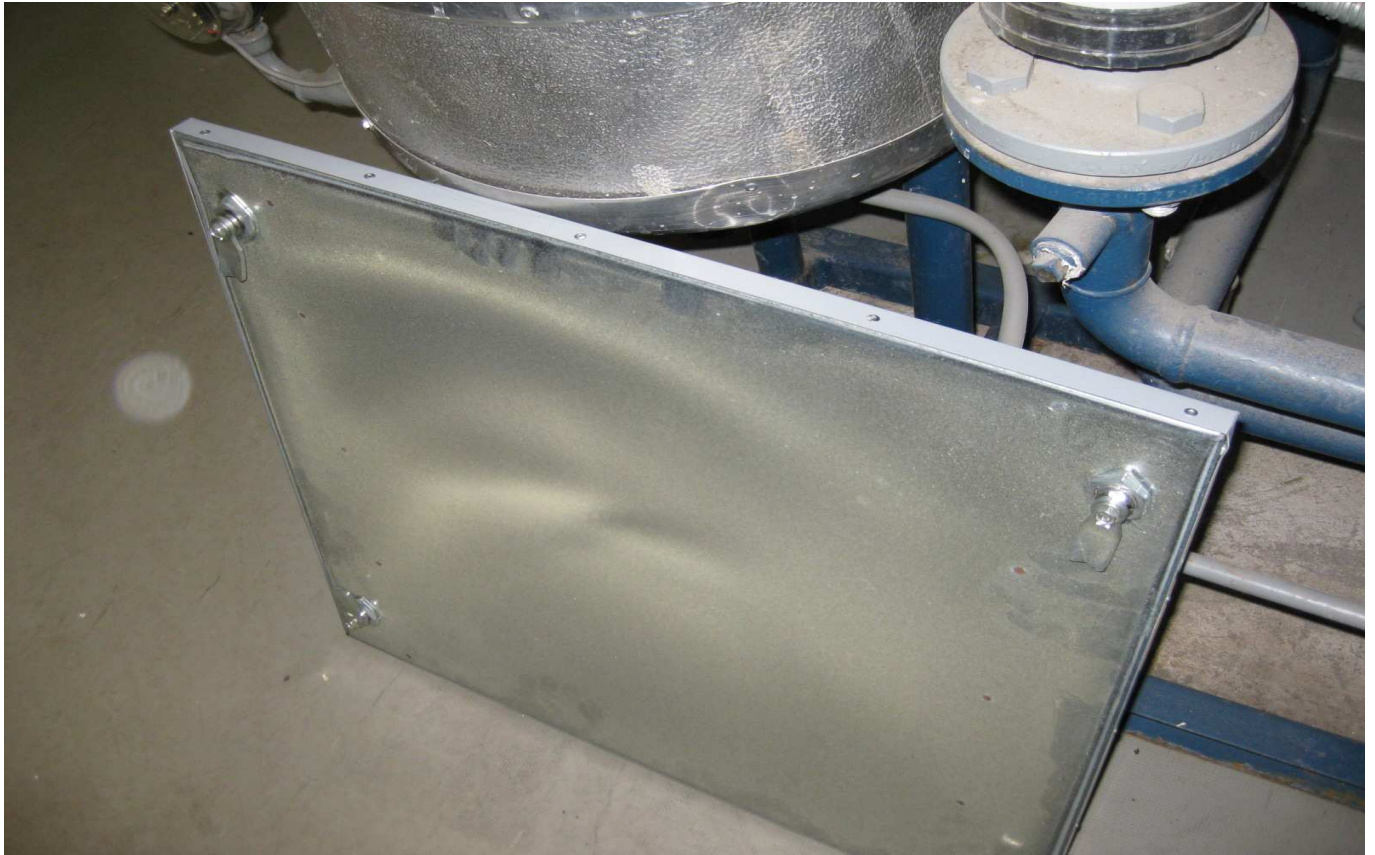
KUVA 11. Yleiskuva tuloilmakammioista TK 06.
