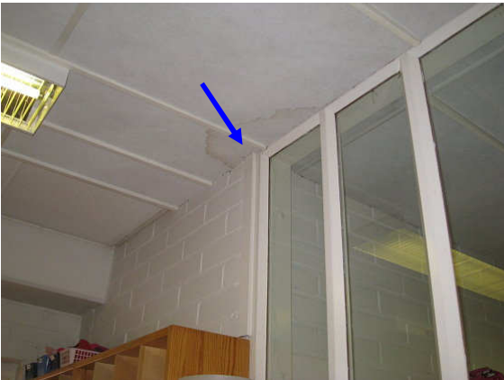
Kuva 25 Vesivuotojälki kuraeteistilassa 1.
