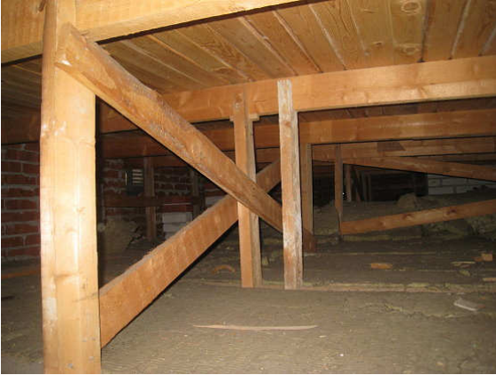
Kuva 23 Vesikattorakenteissa ei havaittu vaurioita.
