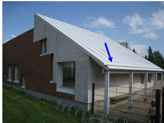
Kuva 4 Jalkarännit ovat matalat.
