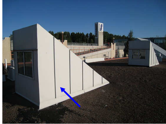
Kuva 30 Kattolyhdyissä on peltikate-/ verhous.
