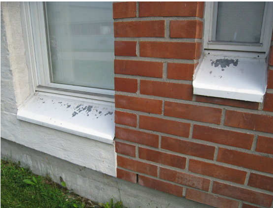
Kuva 37 Vesipellityksissä maalivaurioita.
