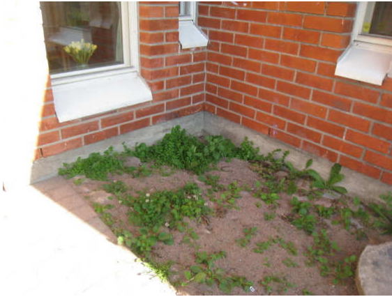
Kuva 1 Maanpinta viettää kaakon puoleisella sivustalla/kulmassa rakennukseen päin.
