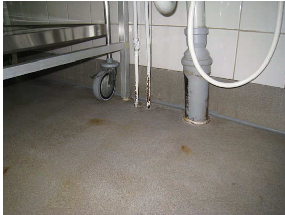
Kuva 13 Keittiössä on seinän ja lattian rajaa tiivistetty.
