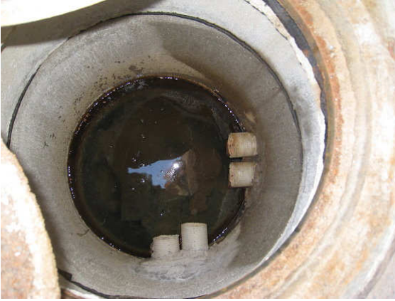
Kuva 5 Lounaan puoleisen kulman salaojien tarkastuskaivo.
