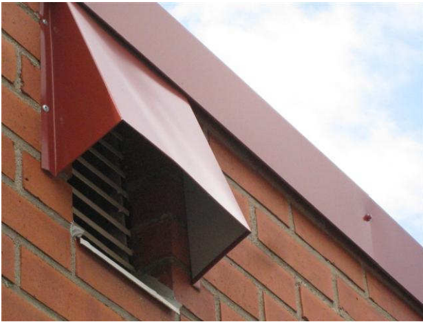
Kuva 19 Länsisivulla uusittuja räystäspellityksiä ja yläpohjan tuuletusaukon suojaus.
