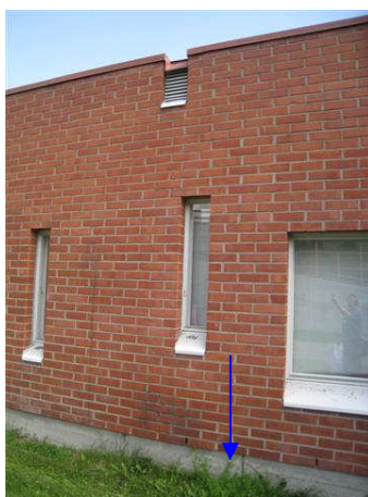
Kuva 5 Länsisivun sokkelissa on liikuntasauva pukuh 40 pilarin kohdalla
