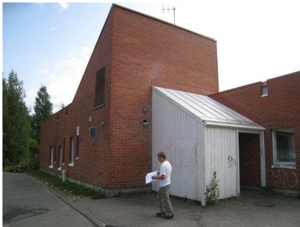
Kuva 3 Yleiskuva pohjoispäädyistä. Puinen vaja on maalattu graffiteilla.
