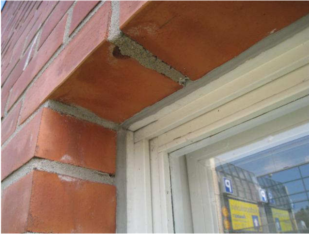
Kuva 7 Ikkunoiden kohdalla on tiilestä muurattut palkit. Ikkuna- ja oviliittymien elastiset saumat eivät sisällä lyijyä.
