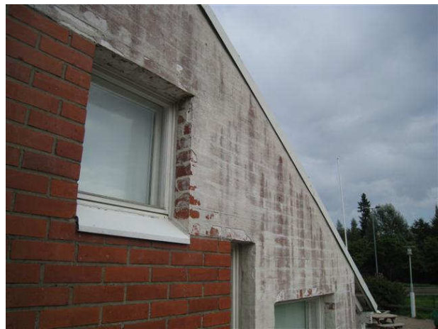
Kuva 22 Slammaus on kulunut myös pielistä pois
