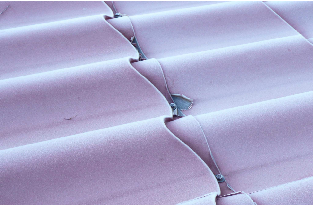
RAK- kuva 6. Yleiskuva lisärakennuksen vesikatolta.
