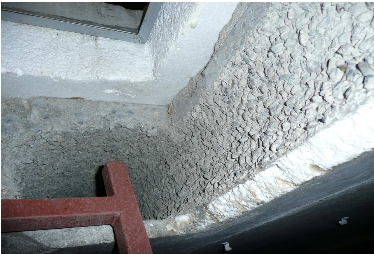
RAK- kuva 4. Yleiskuva alapohjarakenteista.
