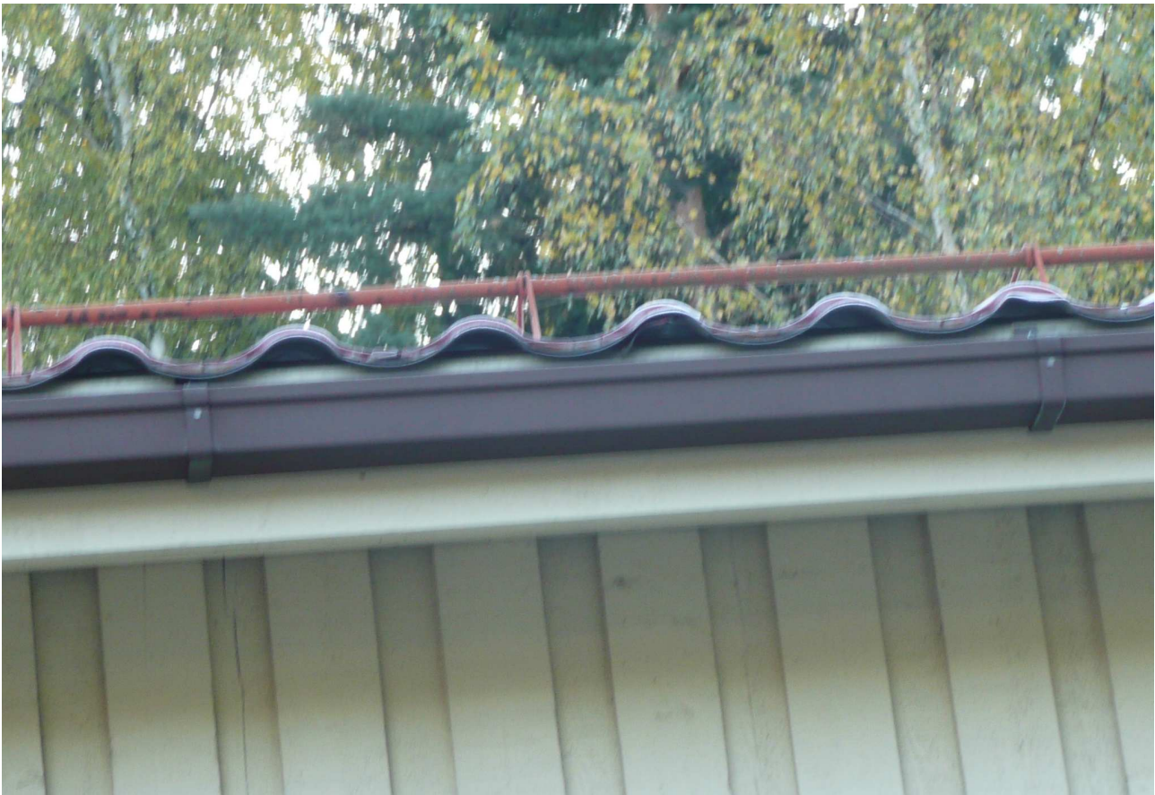
RAK- kuva 7. Yleiskuva putkilumiesteistä.
