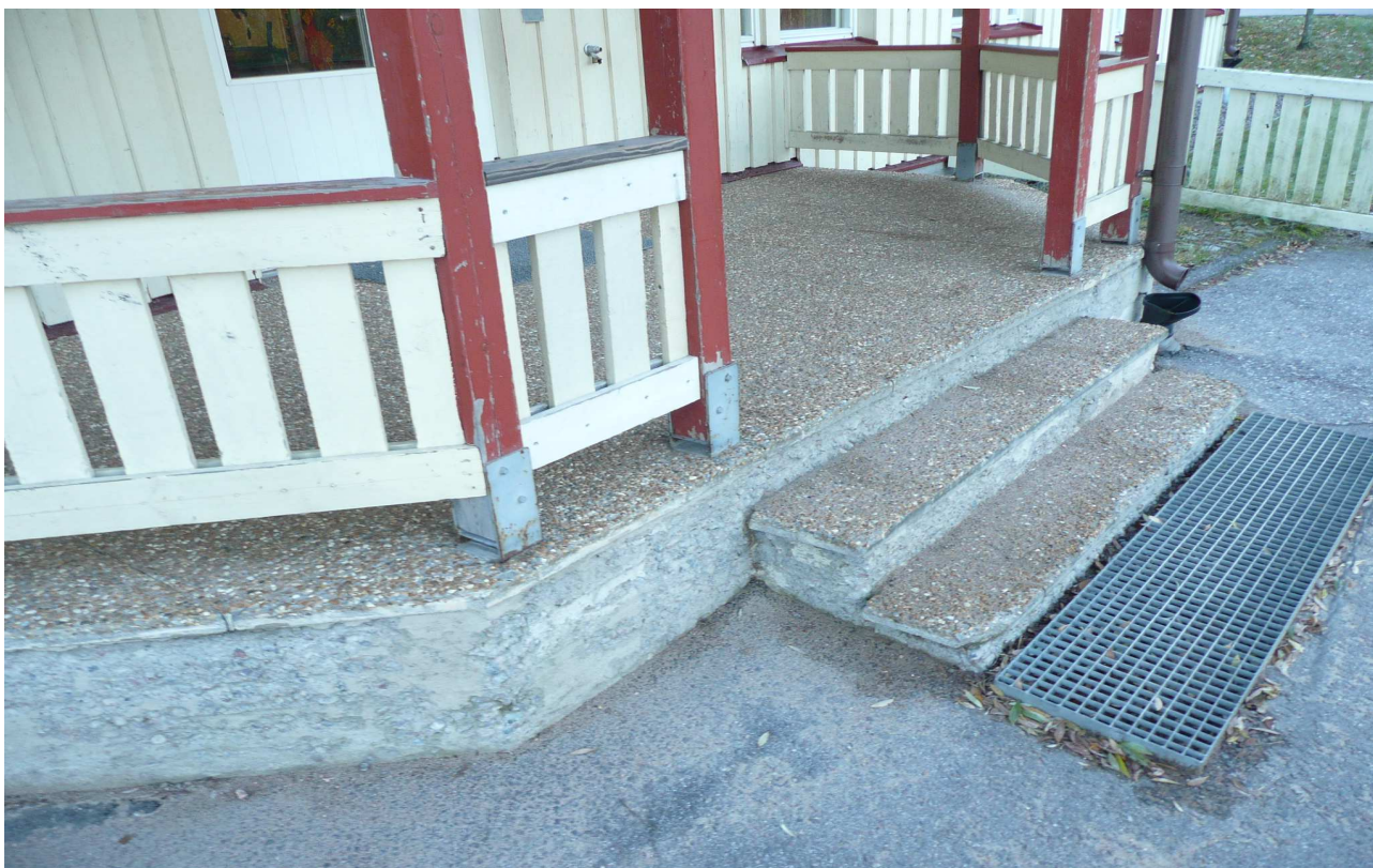
RAK- kuva 3. Yleiskuva lisärakennuksen portaista.
