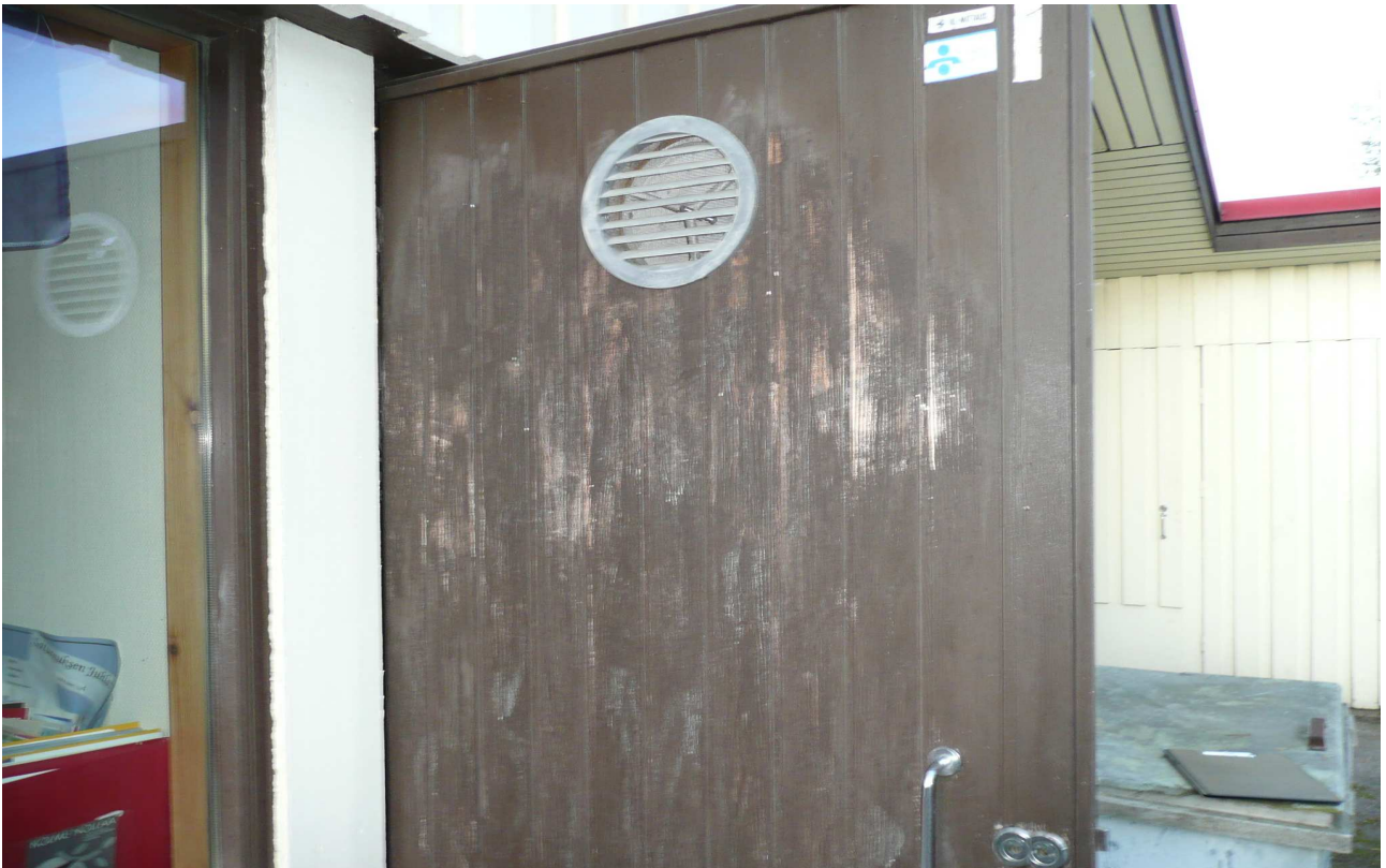
RAK- kuva 5. Yleiskuva päiväkodin puuvista.
