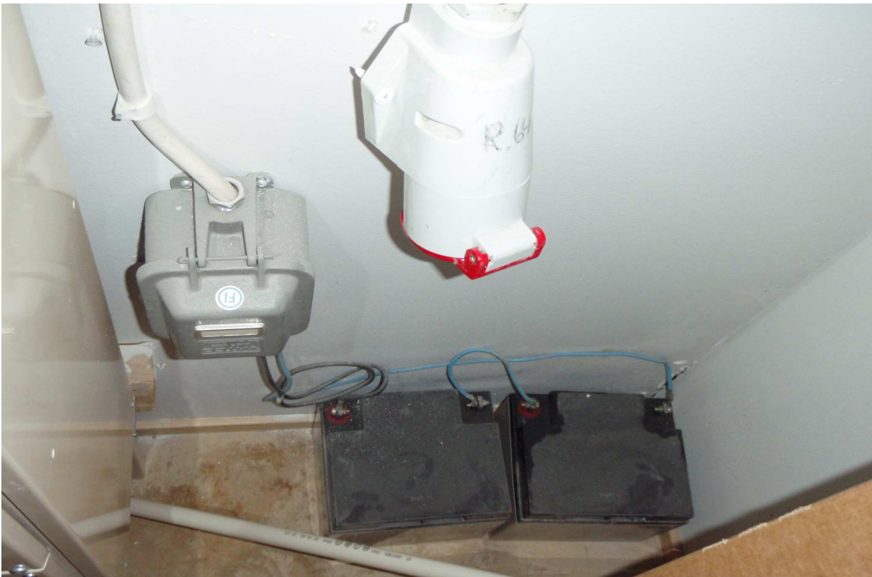
S-KUVA 6. Pääkeskustilassa on voimavirtapistorasiasia 32A irti.
