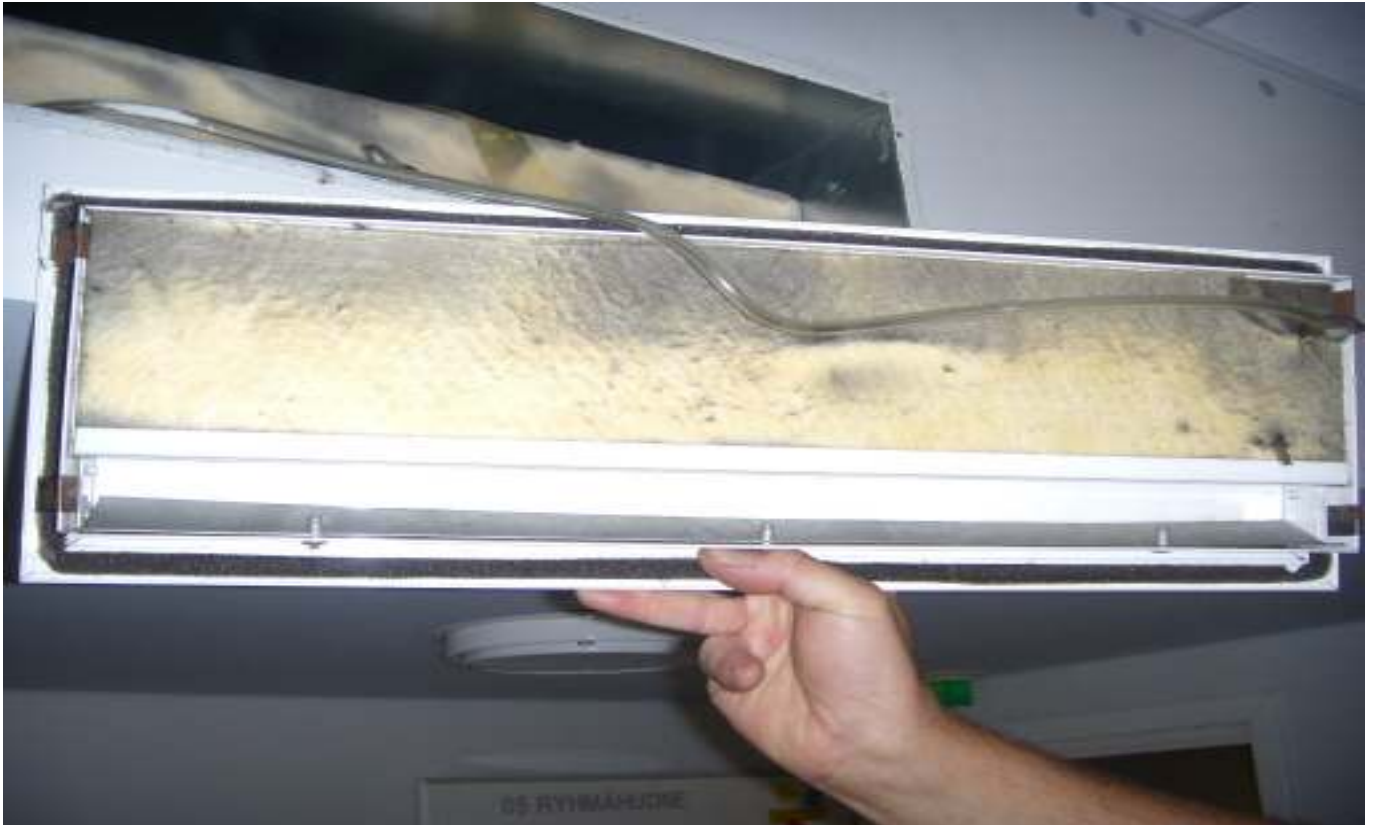
KUVA 19. Tuloilmasäleiköissä on mineraalivillaeristettä.
