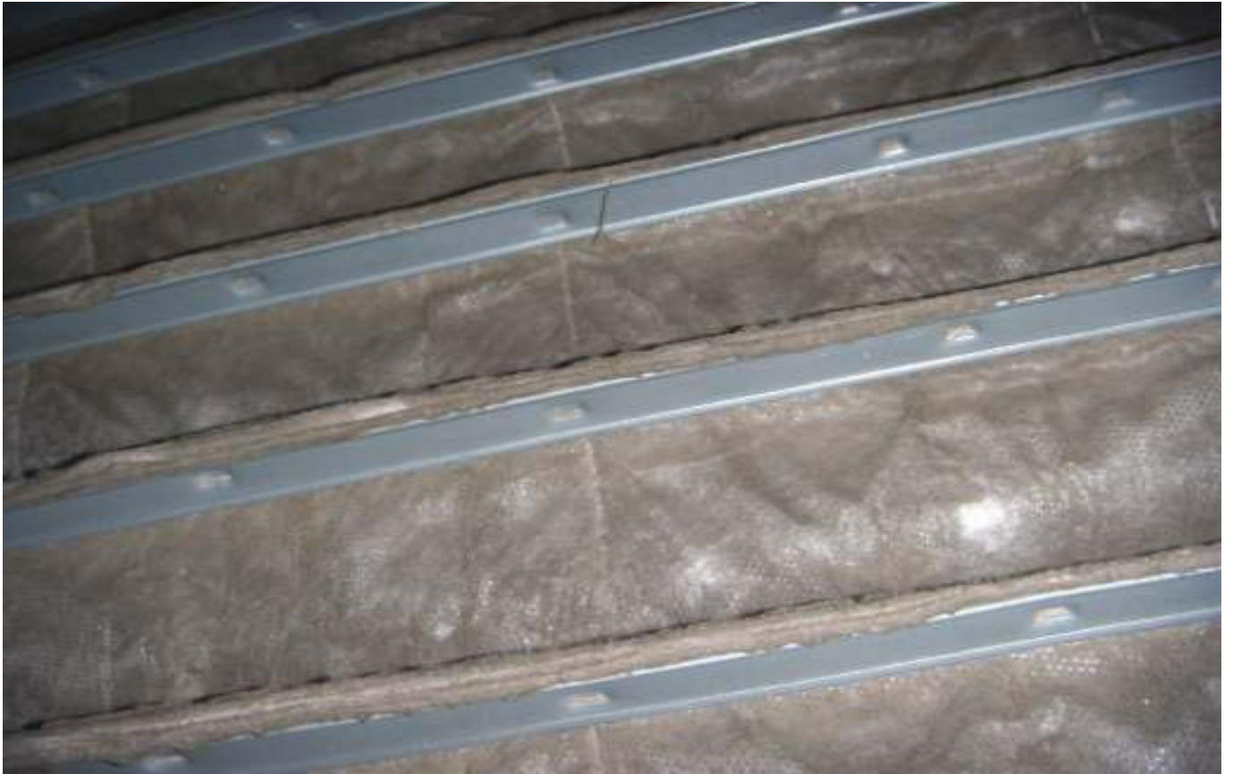
KUVA 5. Yleiskuva tuloilmasuodattimesta.
