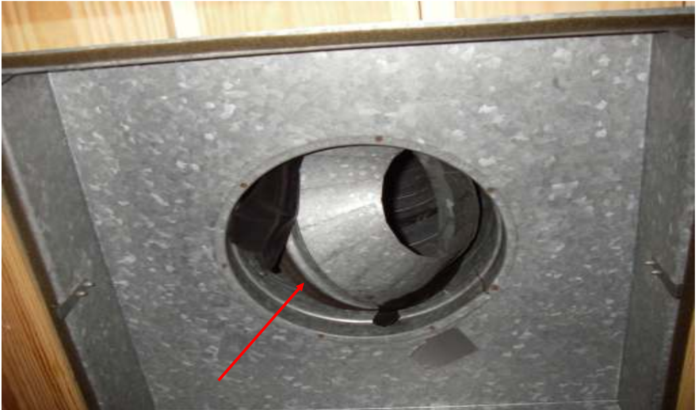
KUVA 21. Yleiskuva eteisen kattohajottajasta.
