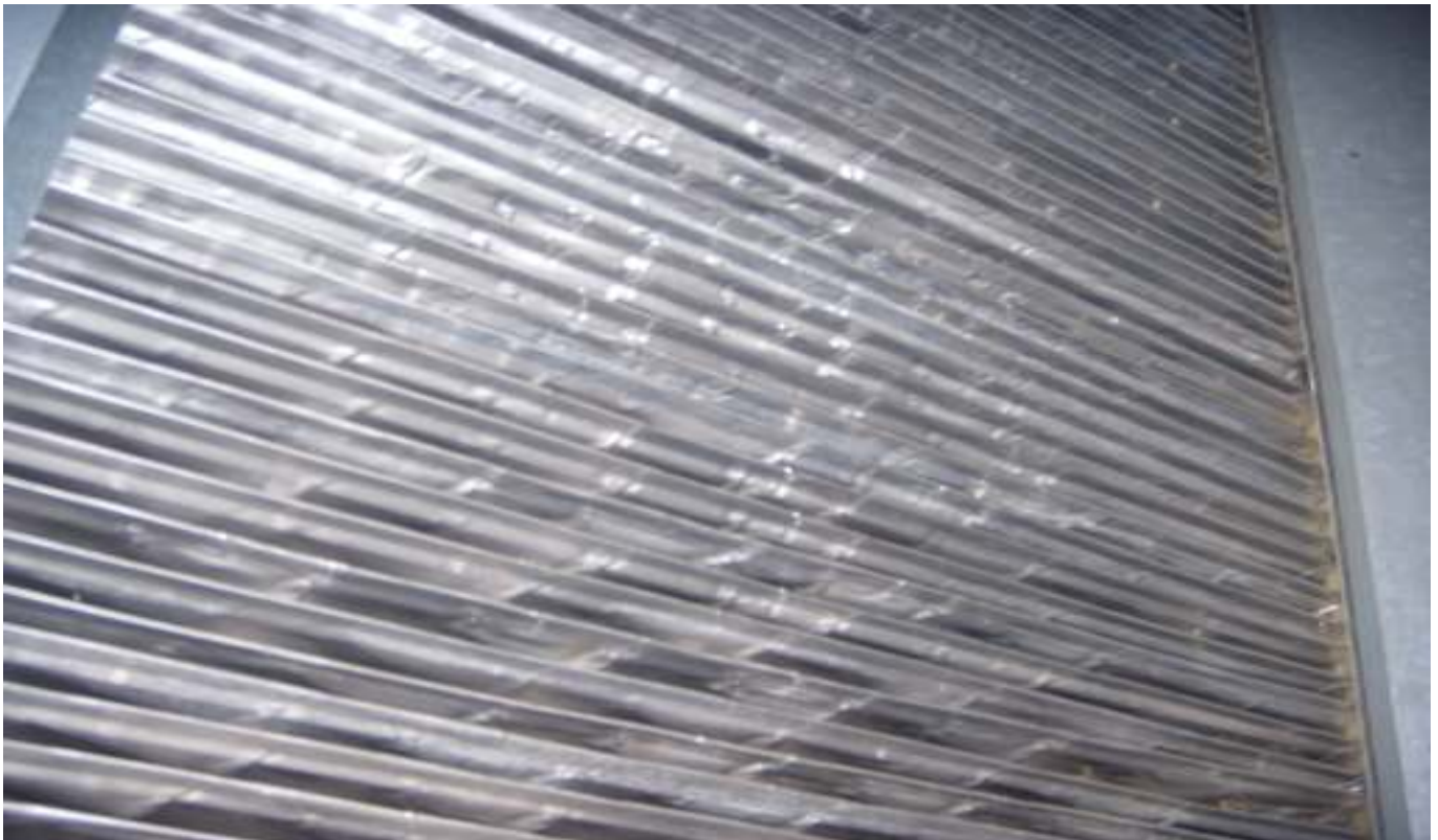
KUVA 12. Lisärakennuksen LTO- kuutio on hieman pölyinen.
