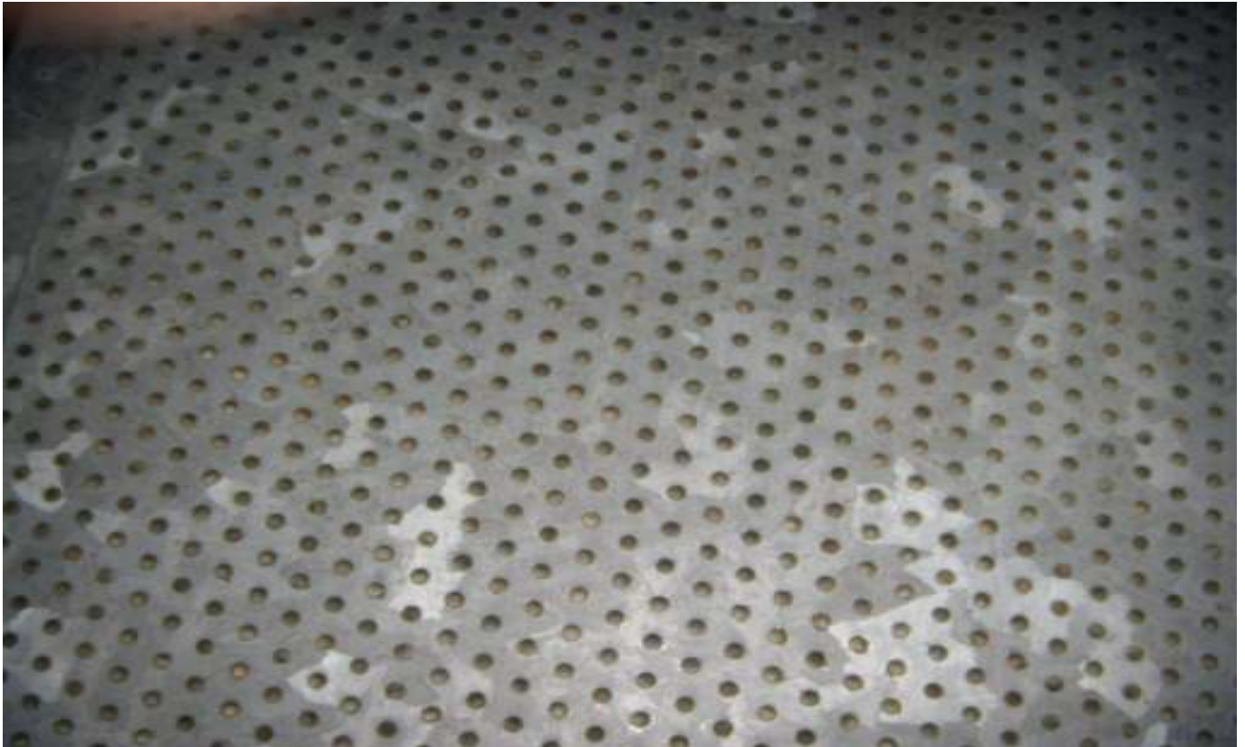
KUVA 9. Tuloilmakoneen kammiot on eristetty mineraalivillalla, joka on päällystetty reikäpellillä.
