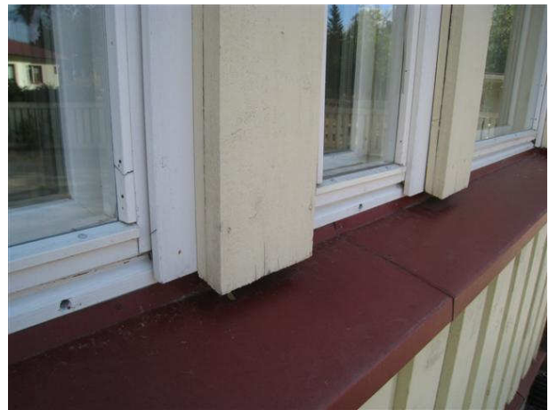
Kuva 40 Ikkunoiden kunto on vielä hyvä. Vesipelitykset ovat loivia.
