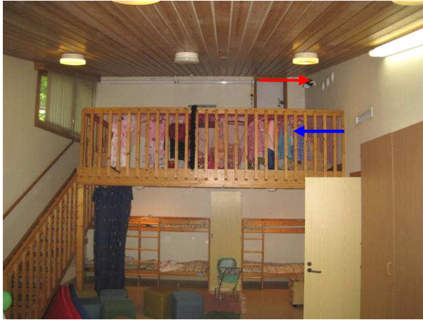
Kuva 31 Ilmanvaihto ei toimi kunnolla parvien alla.
