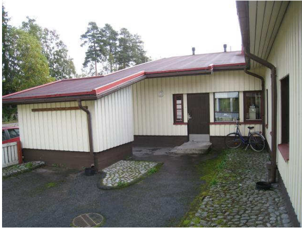
Kuva 1 Yleiskuva päärakennuksen huoltopihalta. Asfalttia ja kenttäkiveystä.
