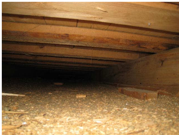
Kuva 23 Viiston yläpohjan tuuletusväli on riittävä.
