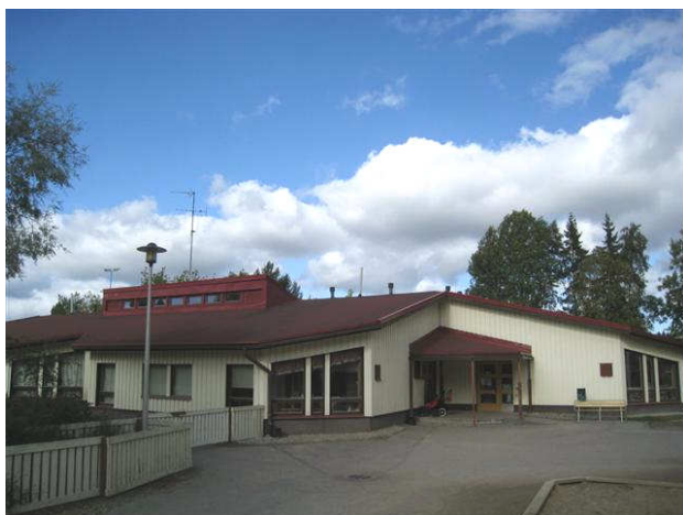
Kuva 17 Päärakennuksen vesikatto on moni-muotoinen, lisäksi on katoksia.
