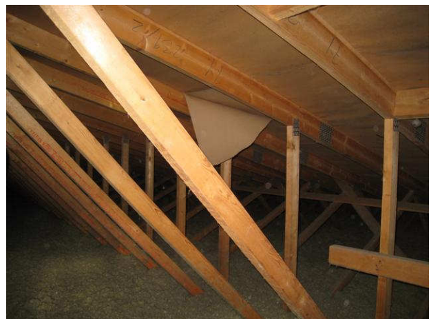
Kuva 42 Aluskatteet ovat kunnossa.
