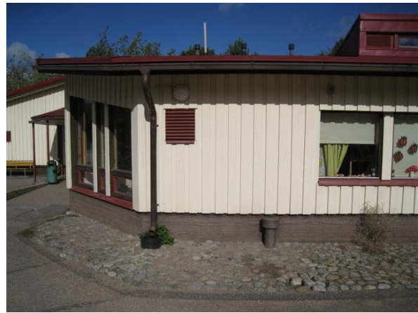
Kuva 2 Yleiskuva kotikeittiö 19 - ryhmähuone 20 kulmalta. Kallistukset ovat hyvät.
