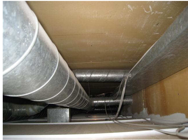
Kuva 32 Käytävän alakaton asennuksia.
