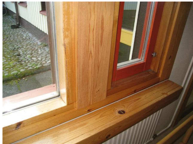
Kuva 14 Päärakennuksen ikkunat ovat pääosin kiinteitä 2-lasisia umpiolasi-ikkunoita.
