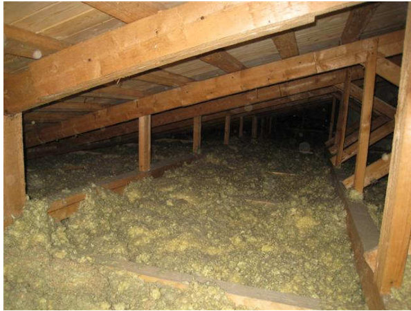
Kuva 21 Yläpohjaontelossa on puhallusvillaeristeet tasakatto-osuuksilla.
