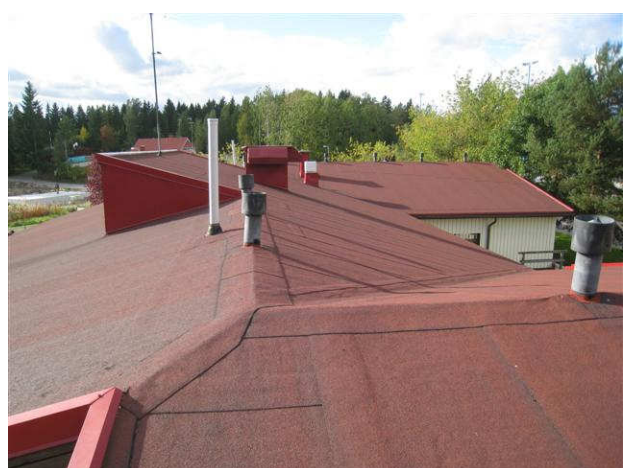
Kuva 18 Yleiskuva vesikatolta, harjalla on tuule-tusputkia yläpohjaonteloon.
