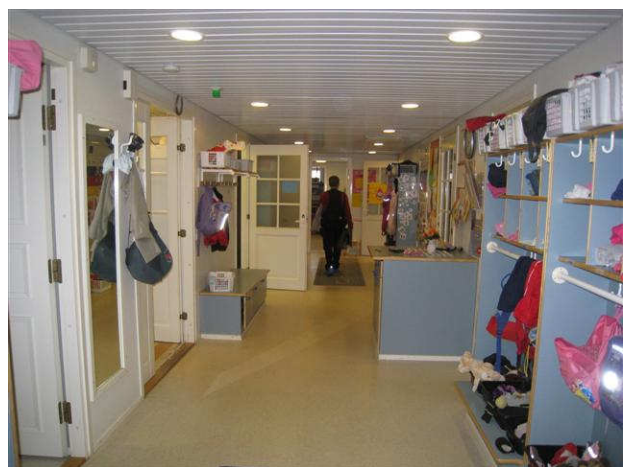
Kuva 46 Yleiskuva eteiskäytävältä 02. Alakattotilassa on IV- ja putkiasennuksia.
