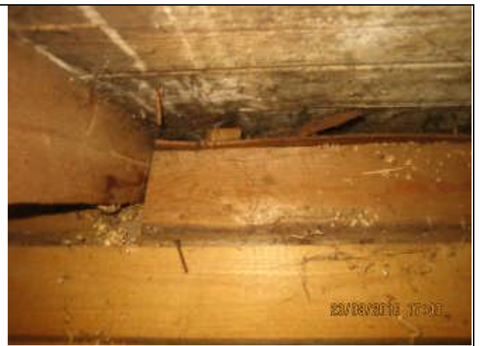
19. Vinolla yläpohjan osalla on tuuletusrako
