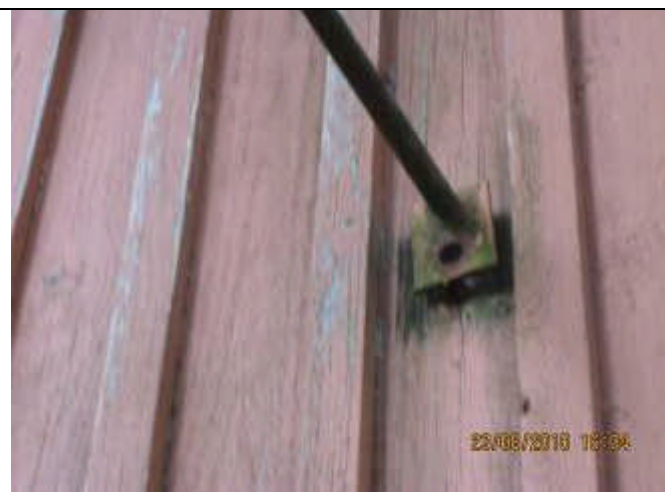
15. Talotikkaan kiinnike on irti
