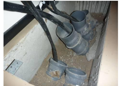
KUVA4. Alapohjan täyttömaata päästiin tarkastelemaan lattialuukusta.
